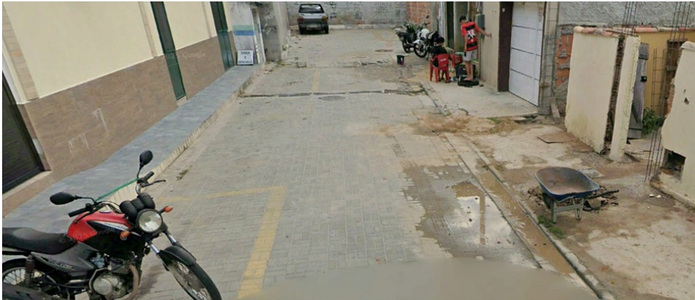
Foto 2 – Vista do local da EEE Vila Caranga ( no final do logradouro ).
