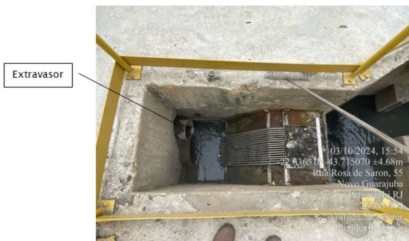
Foto 04 – Gradeamento de chegada
