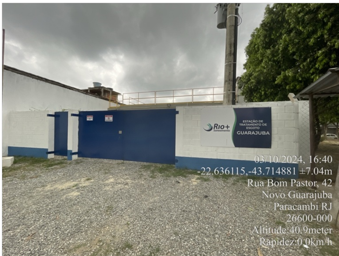
Foto 02 – Vista da fachada da ETE.
