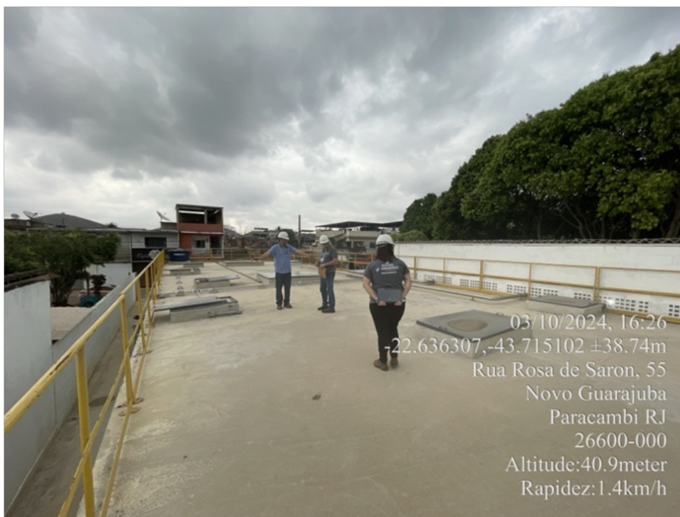
Foto 07 – Laje do reator SBR
