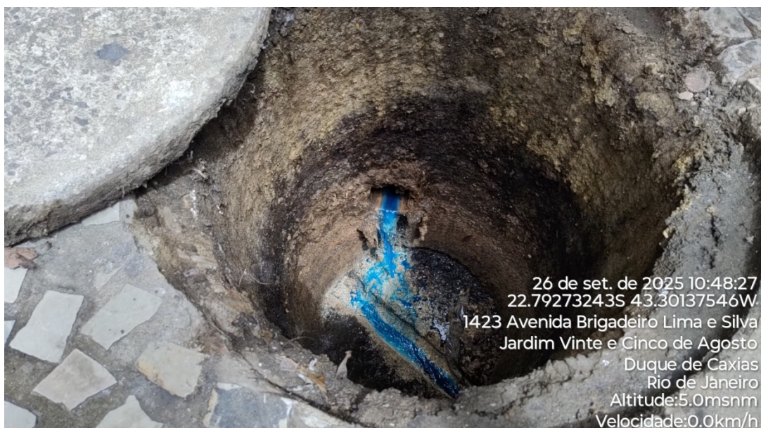
Foto 04: Caixa que recebe os efluentes do estabelecimento e a aplicação do corante.
