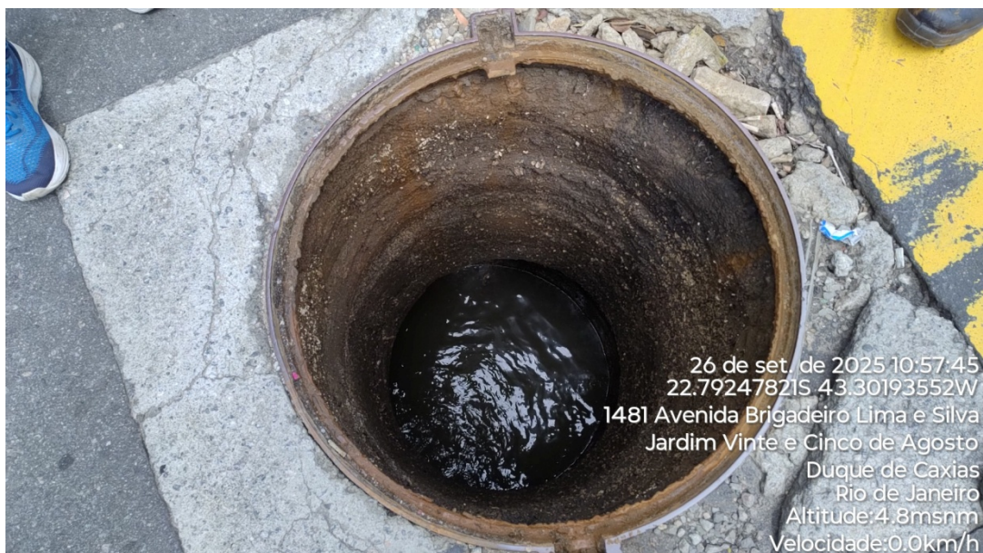
Foto 08: Poço de visita da rede de esgoto na esquina da Av. Brigadeiro Lima e Silva com a Rua General Dionísio antes da chegada do corante.
