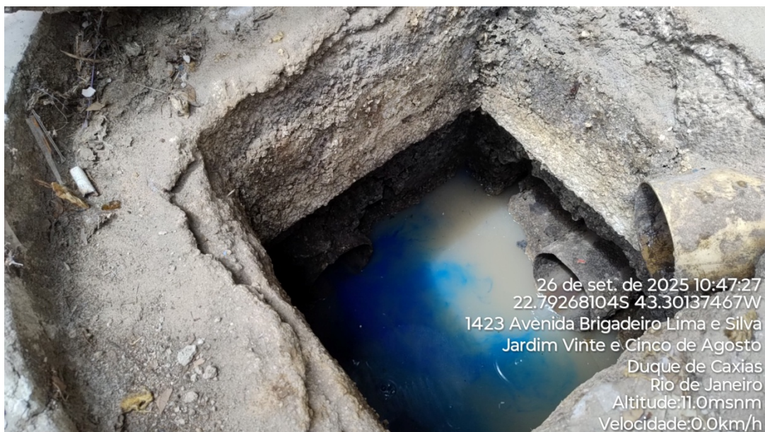
Foto 04: Caixa que recebe os efluentes do estabelecimento e a aplicação do corante.
