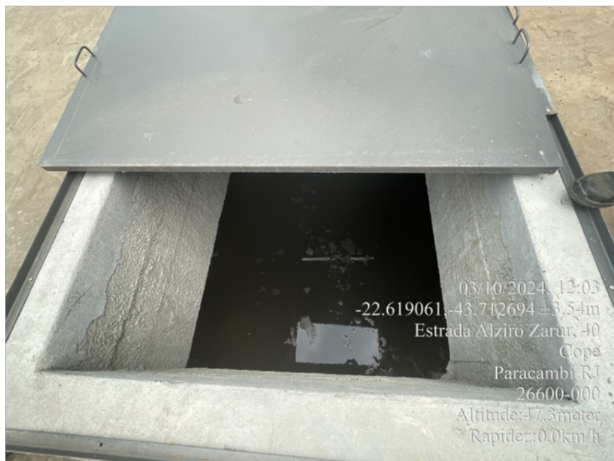
Foto 08 – Decantador primário
