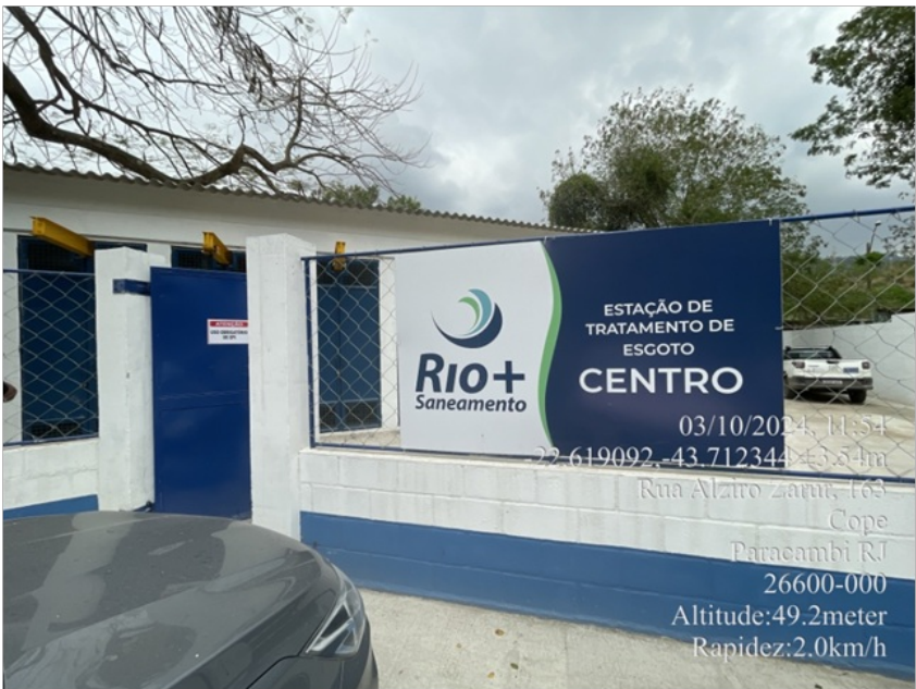
Foto 02 – Vista da fachada da ETE.
