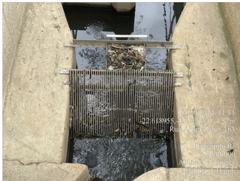
Foto 05 – Gradeamento de chegada
