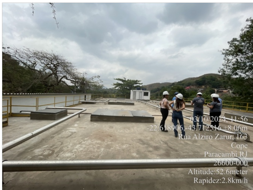
Foto 10 – Laje das câmaras de tratamento
