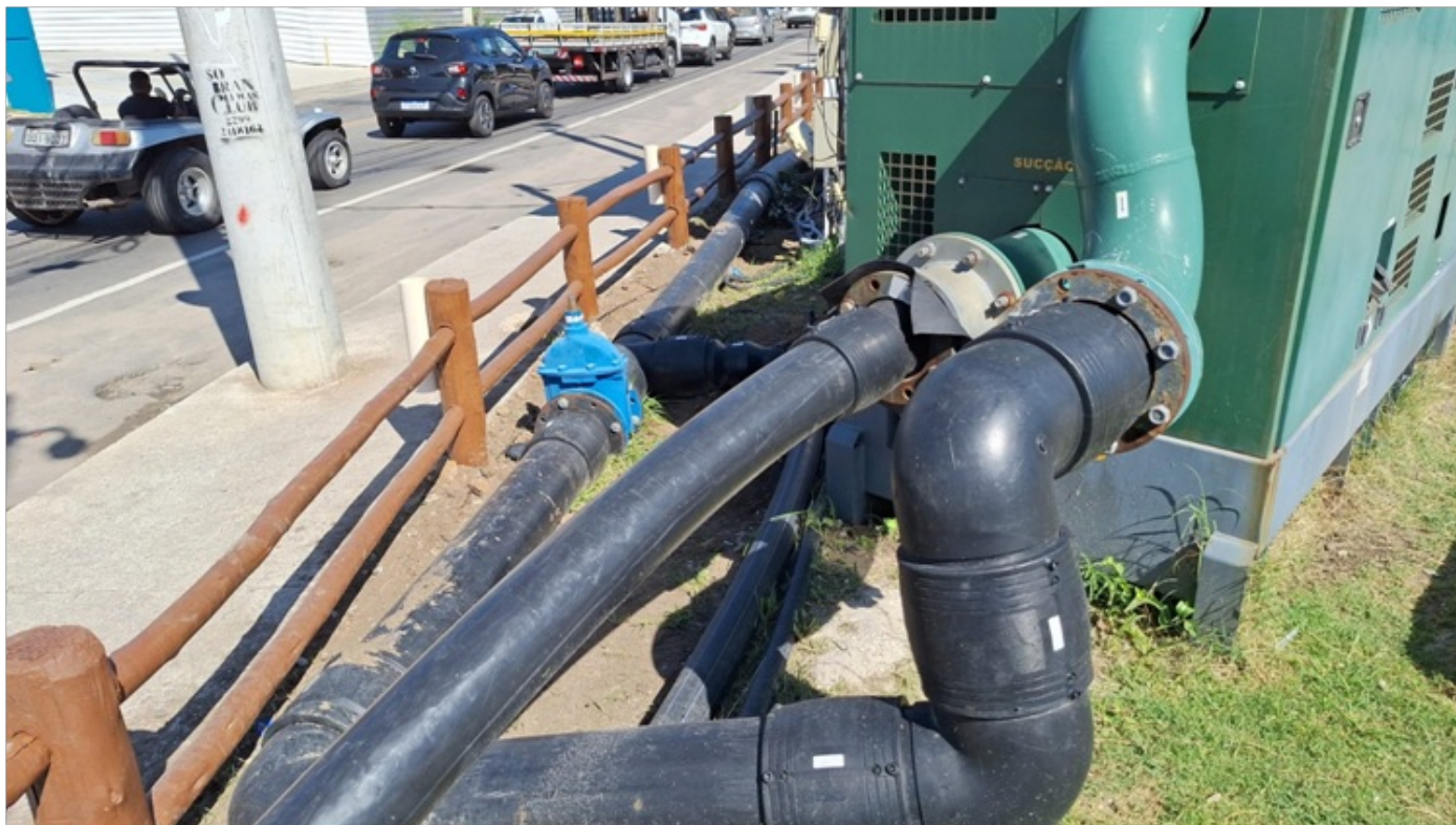
Foto 3 – Arranjo da sucção e recalque, aparentes ,da bomba locada para operação.
