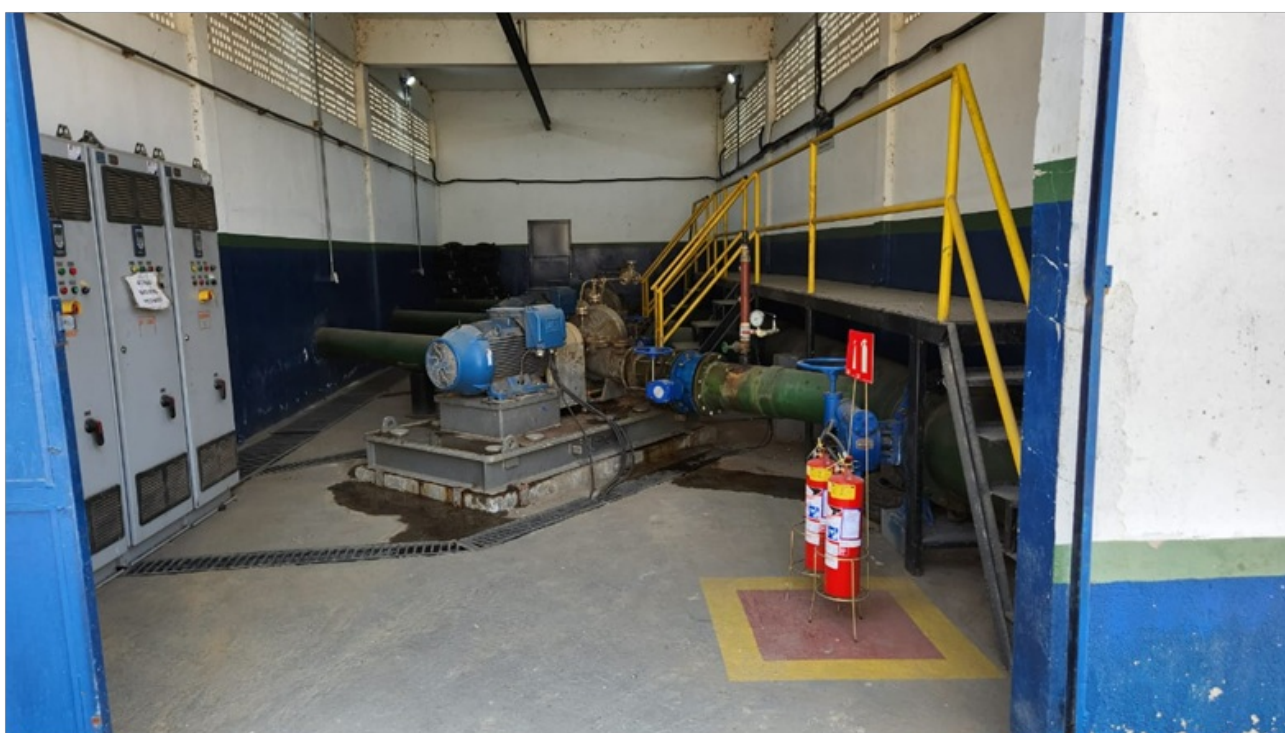
Foto 6 – Abrigo de alvenaria
