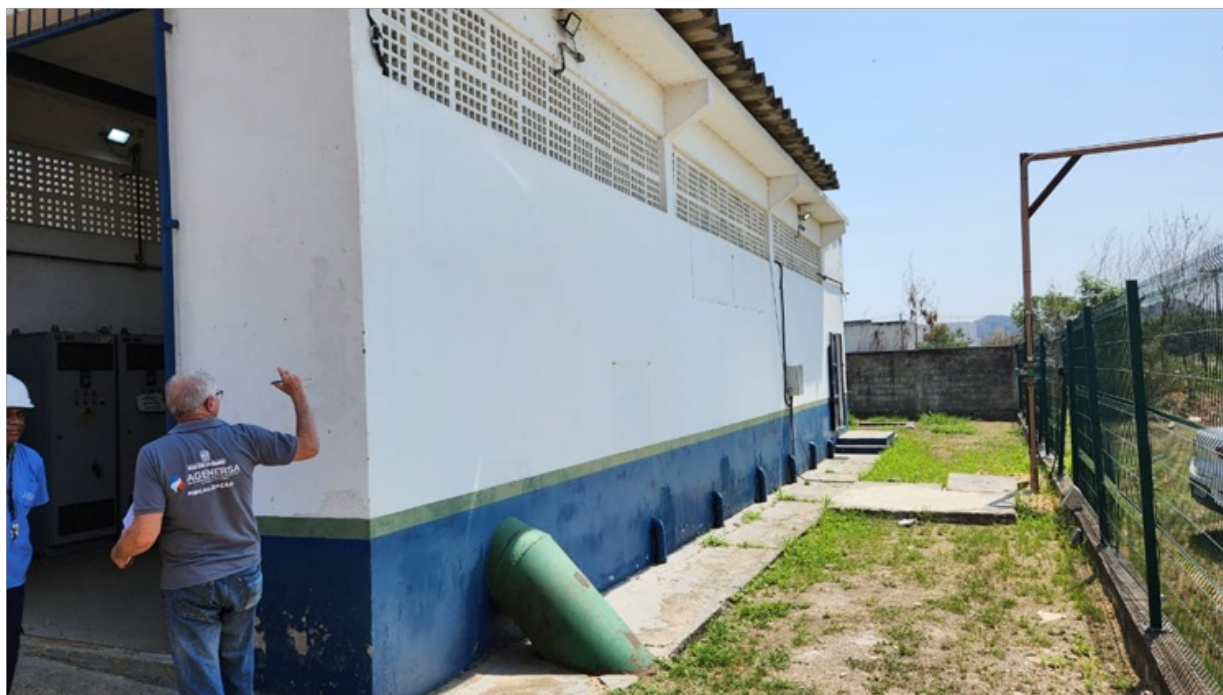
Foto 12 – Tubulação de entrada no booster
