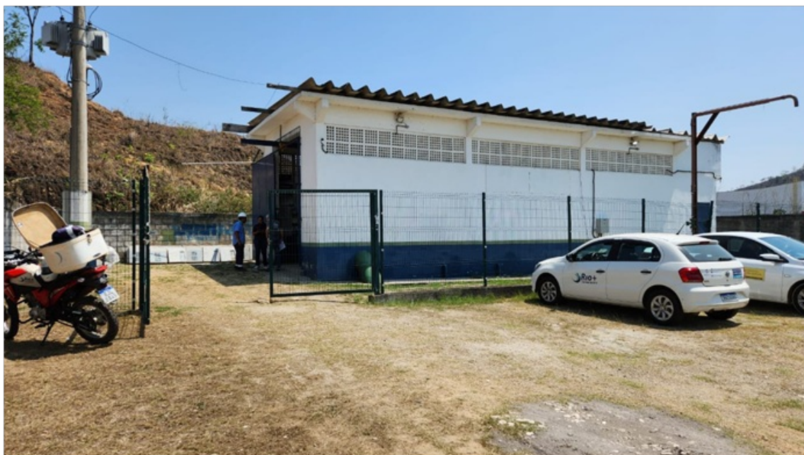
Foto 5 – Abrigo de alvenaria
