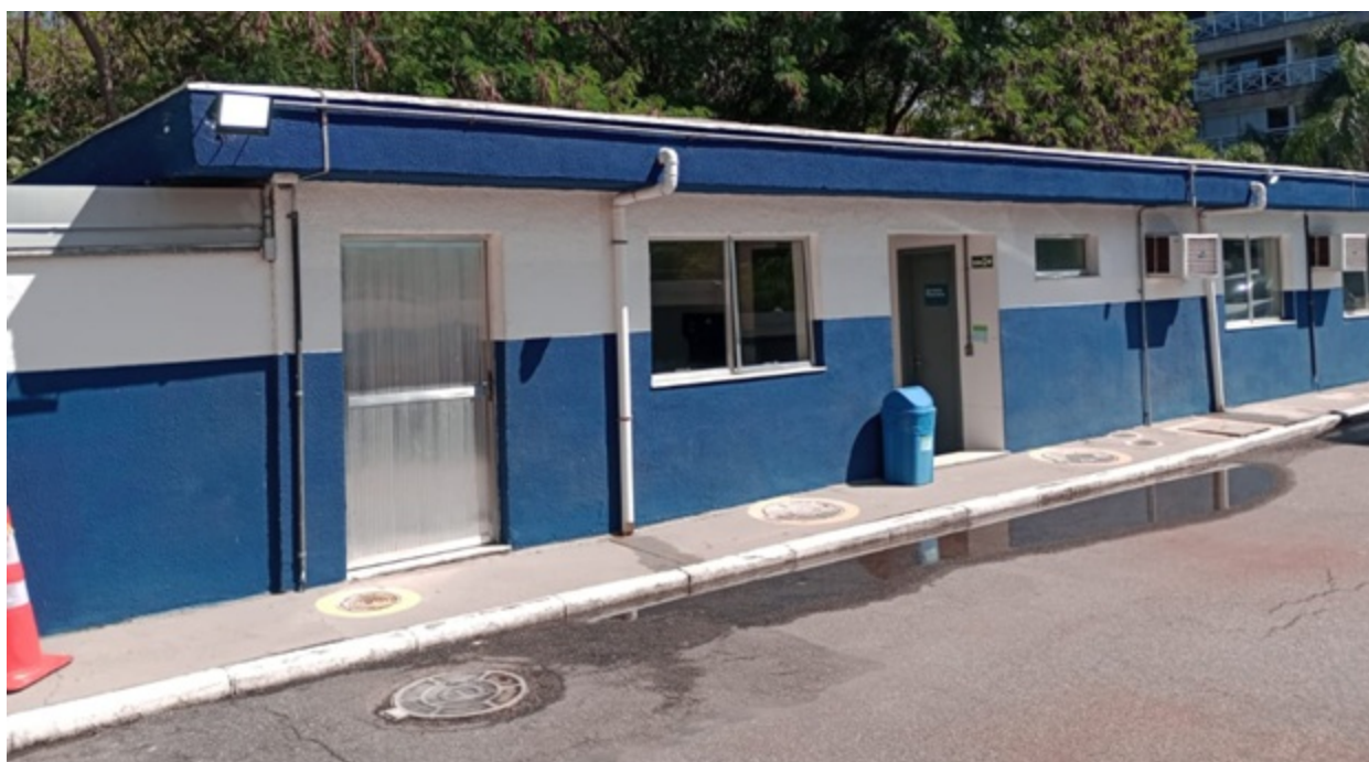
Foto 15 – Prédio onde estão localizados os painéis elétrico e de controle das motobombas da EEEB
