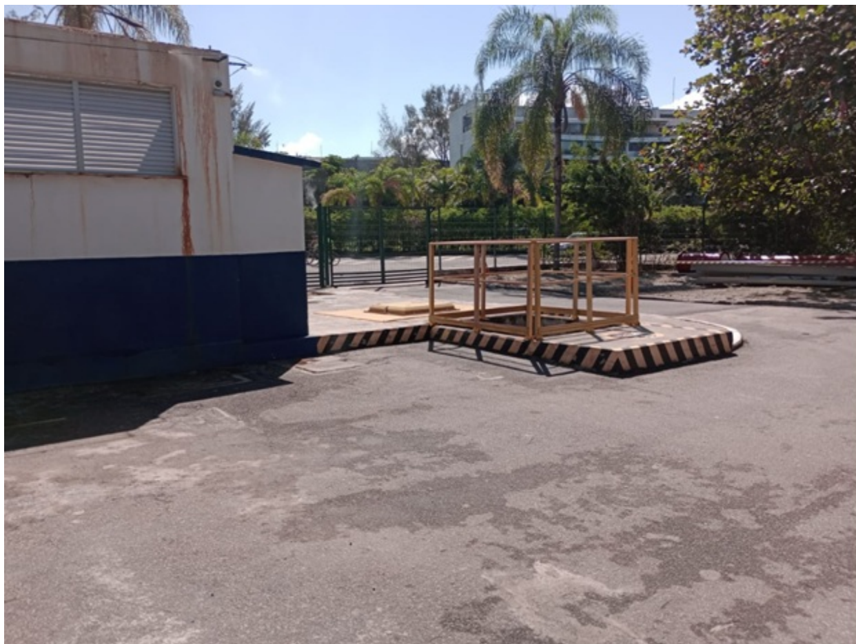
Foto 13 – Guarda corpo da caixa de coleta para extravasamento
