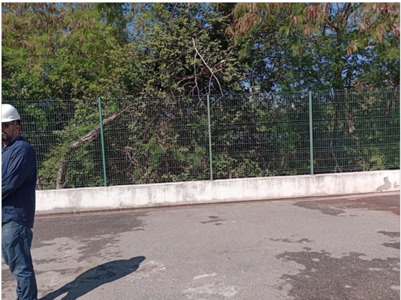
Foto 2 – Grades com base em muro de alvenaria
