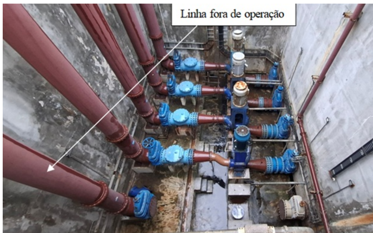
Foto 20 – Poço das motobombas com quatro grupos
