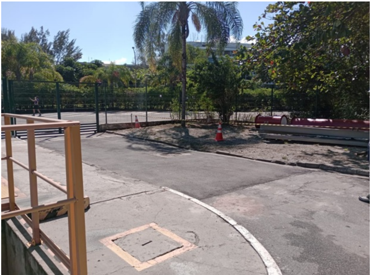
Foto 3 – Acesso restrito com grades em base de muro de alvenaria
