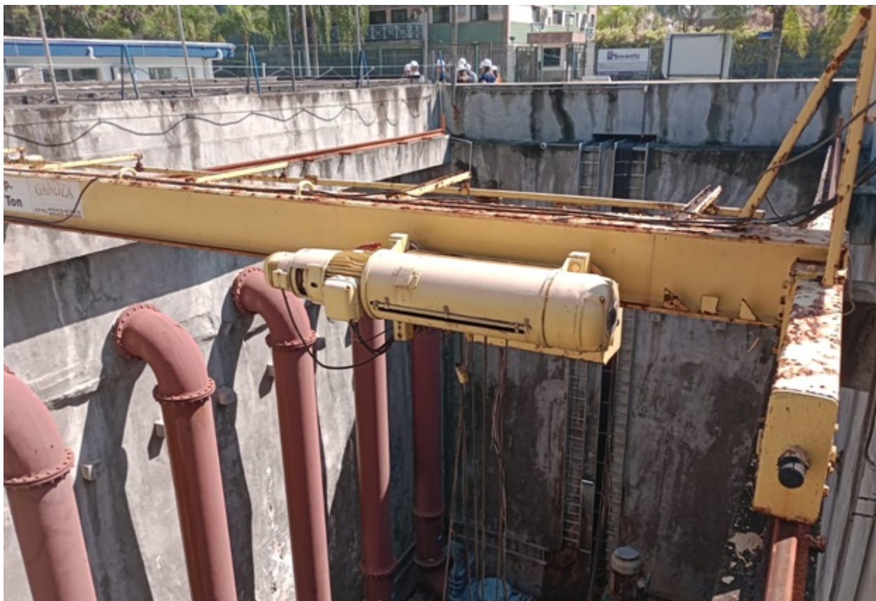
Foto 18 – Poço sem cobertura
