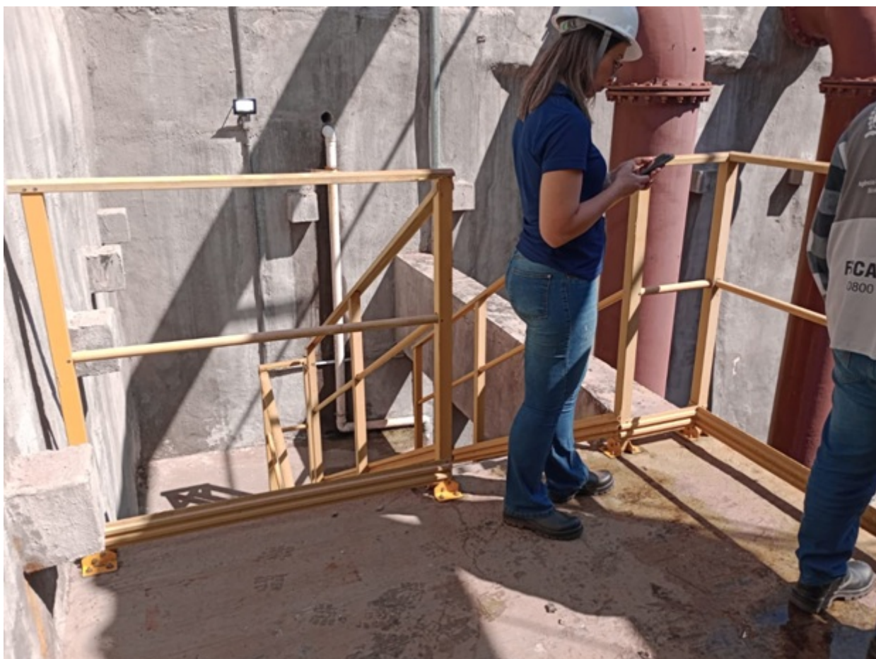
Foto 14 – Guarda corpo no patamar e nas escadas que levam até o poço das motobombas
