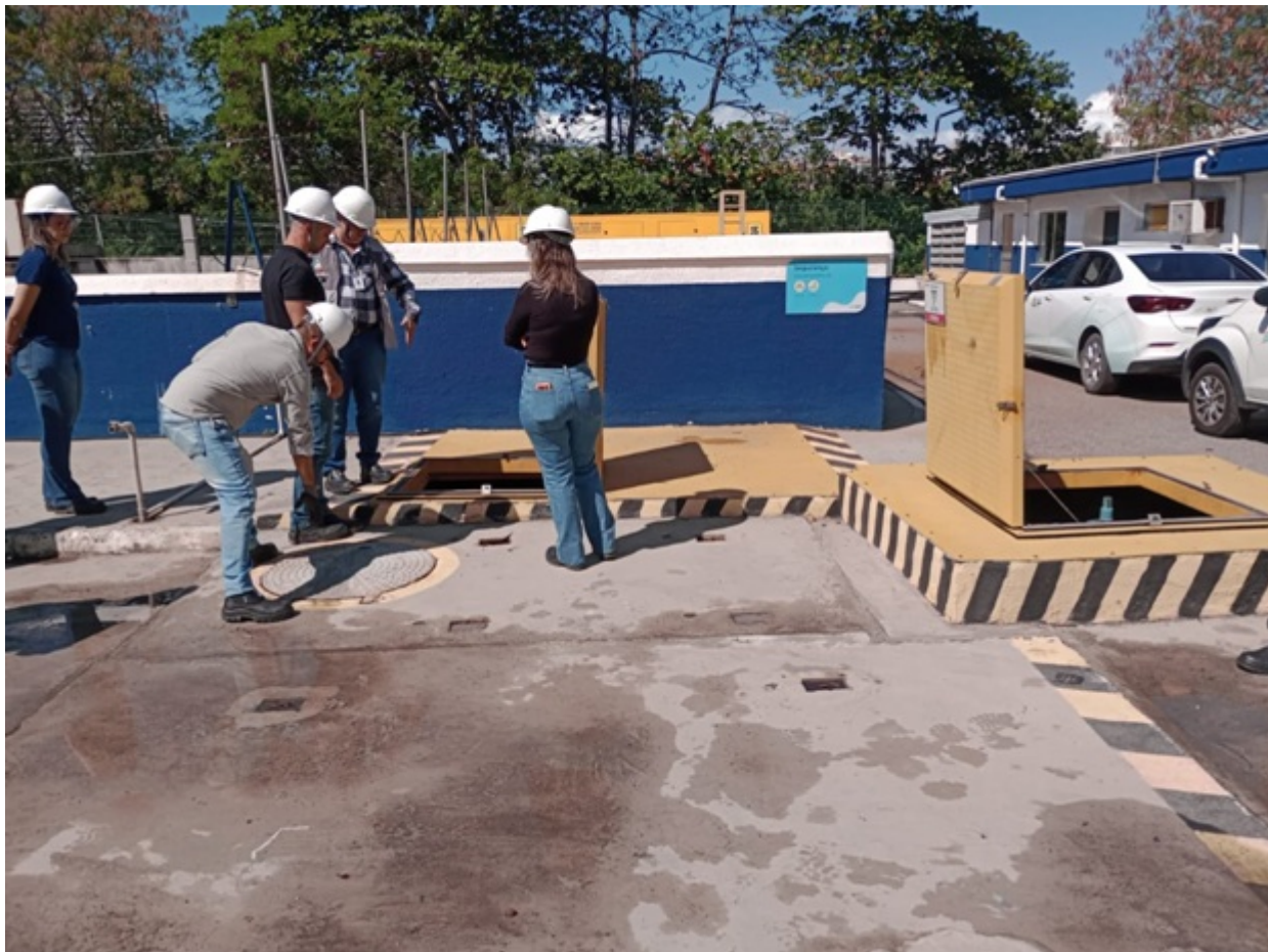
Foto 5 – Tampas de poços de visita
