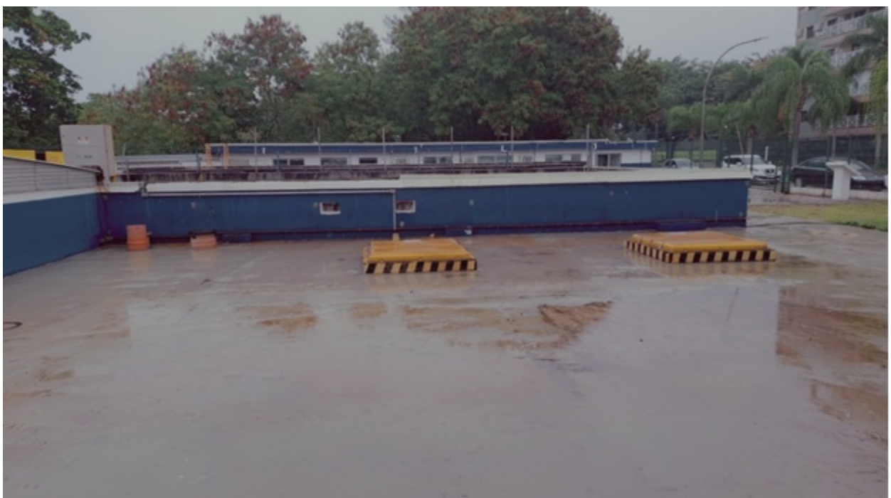
Foto 4 – Tampas do poço de sucção
