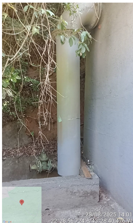
Foto 10 – Caixa de desague
