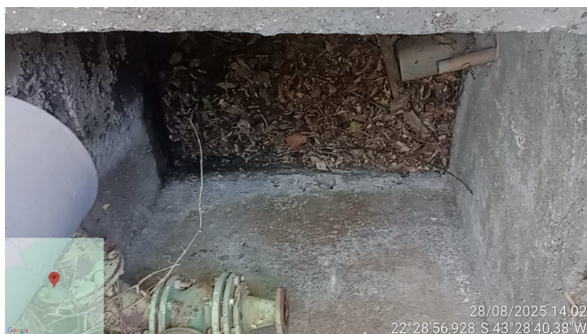
Foto 11 – Caixa de desague
