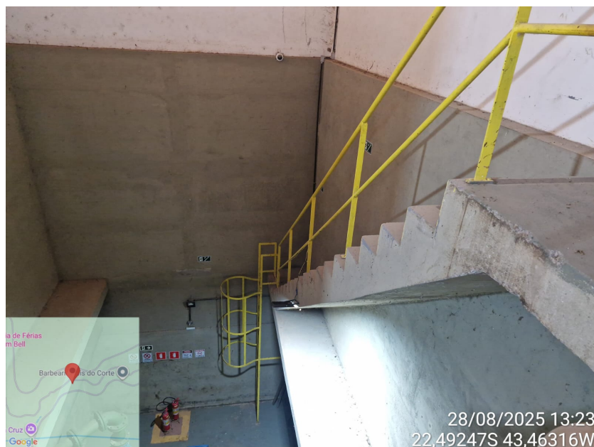
Foto 11 – Guarda corpos no poço das motobombas
