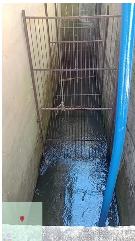
Foto 8 – Gradeamentos com espaçamentos grosso, médio e fino
