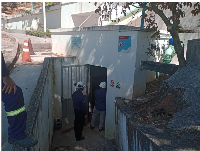
Foto 2 – Abrigo da EEAT
