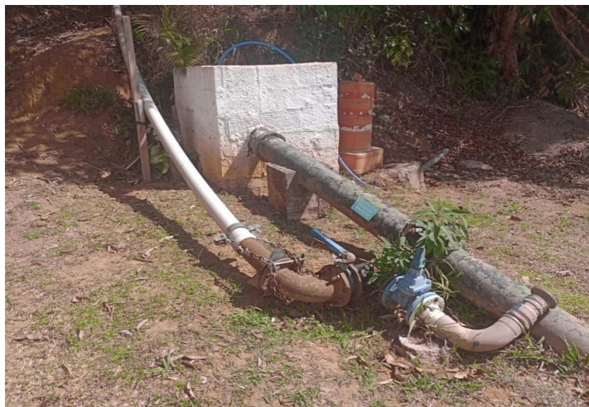
Foto 6 – Tubulação de recalque
