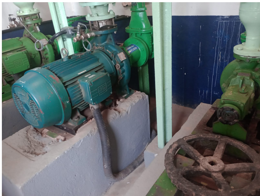
Foto 11 – Apoio pronto para instalação de um terceiro grupo
