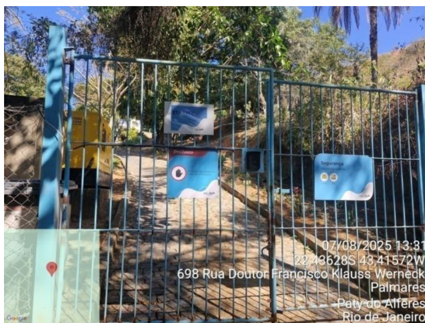
Foto 2 – Entrada da ETA
