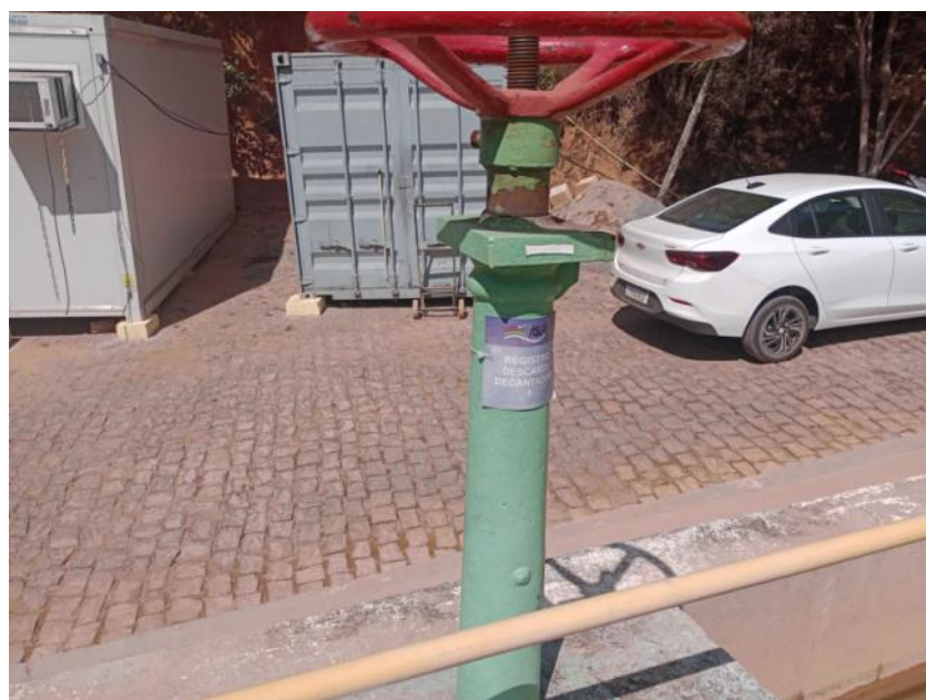
Foto 22 – Válvula de descarga do decantador 1
