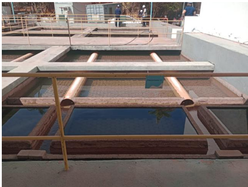
Foto 19 – Decantador 2 (fluxo vertical)
