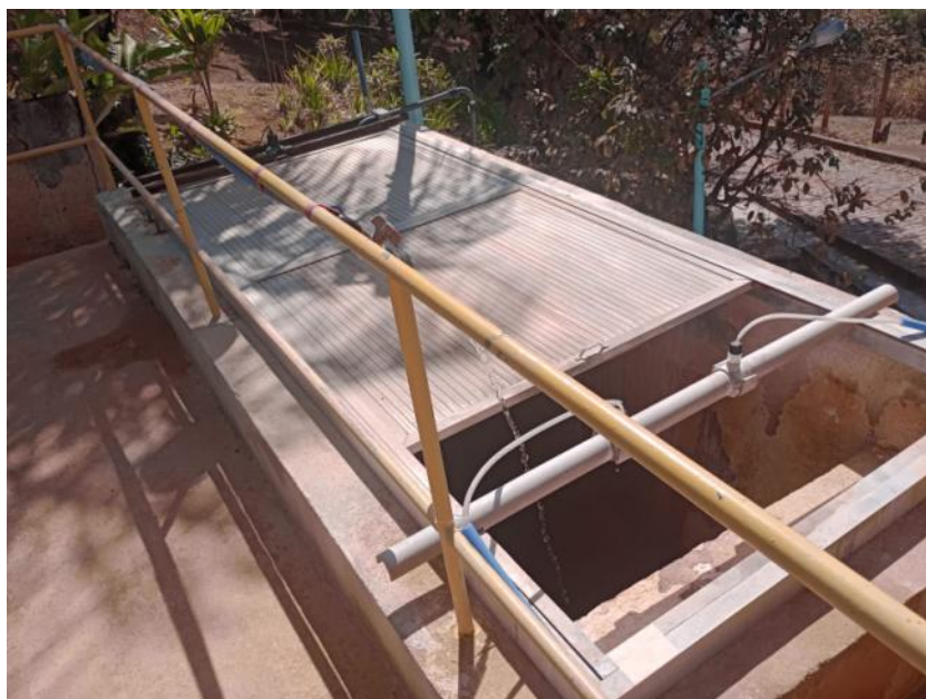
Foto 26 – Gotejador e tanque de contato
