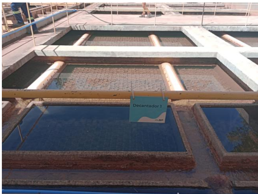
Foto 18 – Decantador 1 (fluxo vertical)
