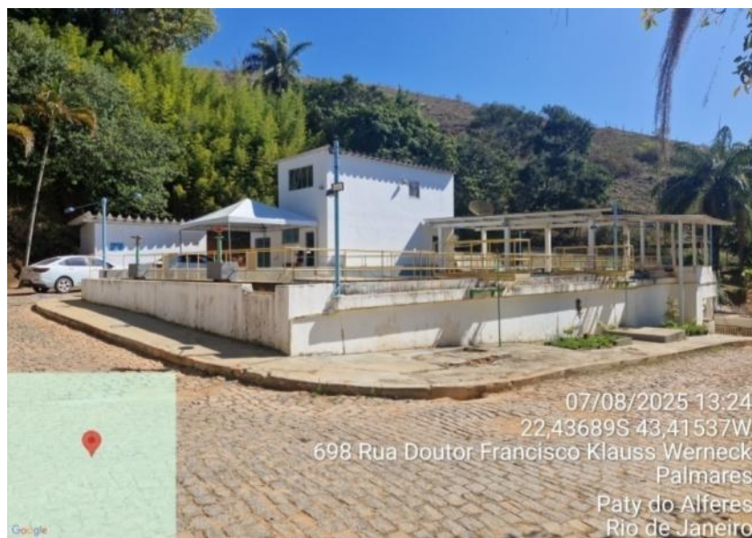
Foto 1 – Vista da ETA
