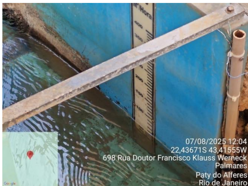
Foto 8 – Régua para medição na Calha Parchall
