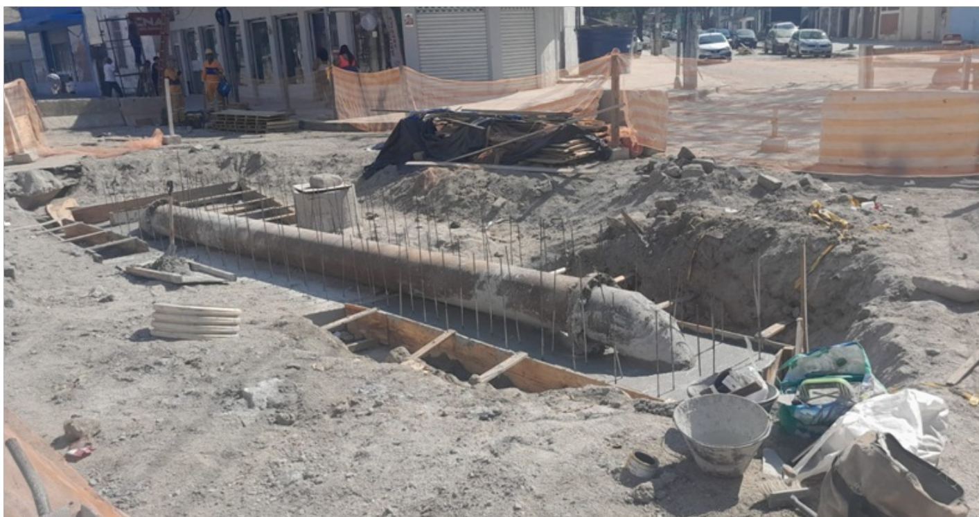
Foto 15 – Primeira concretagem sendo executada
