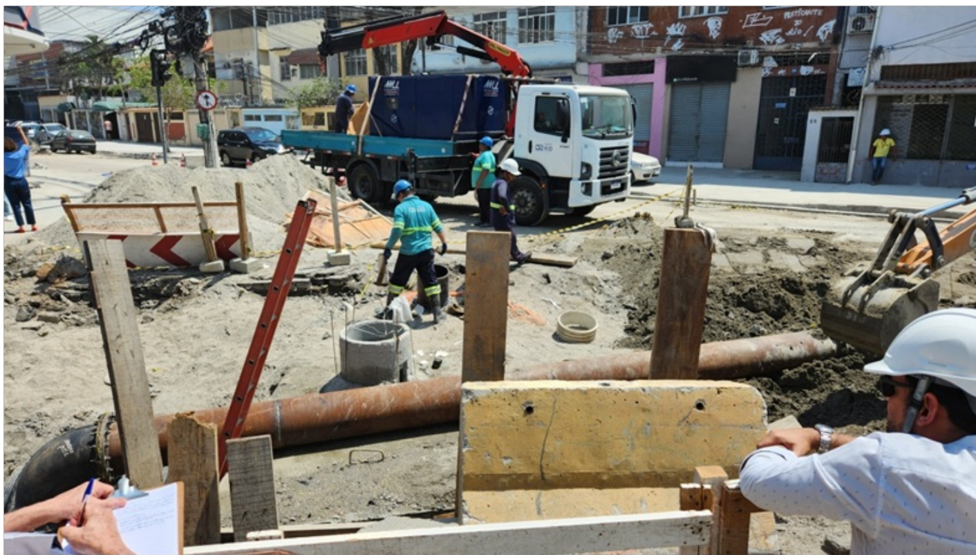
Foto 4 – Reaterro da escavação executado pela Concessionária
