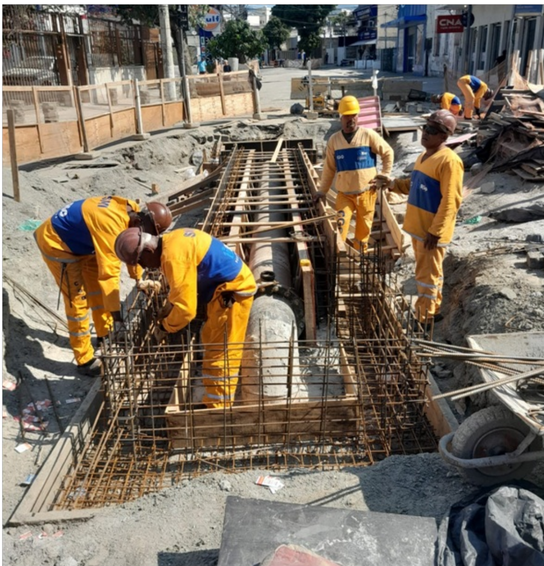
Foto 16 – Preparo para execução da segunda concretagem
