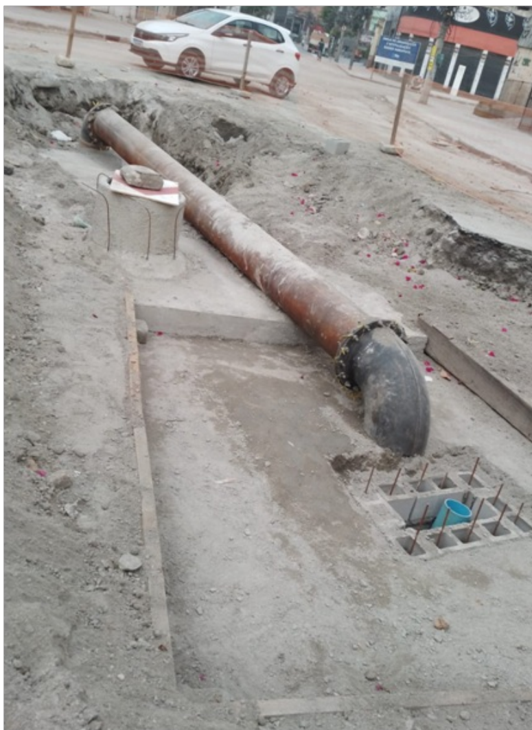
Foto 14 – Tubulação em aço assentado, após o vazamento, unindo os trechos montante e jusante
