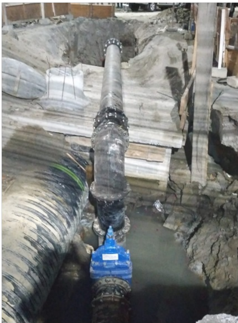
Foto 13 – Cavalete executado antes do vazamento
