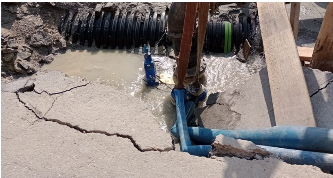
Foto 5 – Água sendo esgotada
