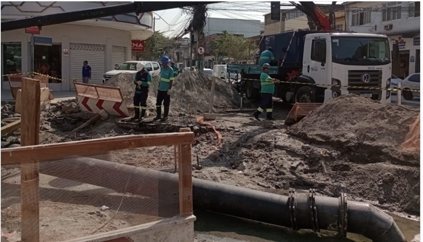
Foto 2 – Tubulação à jusante
