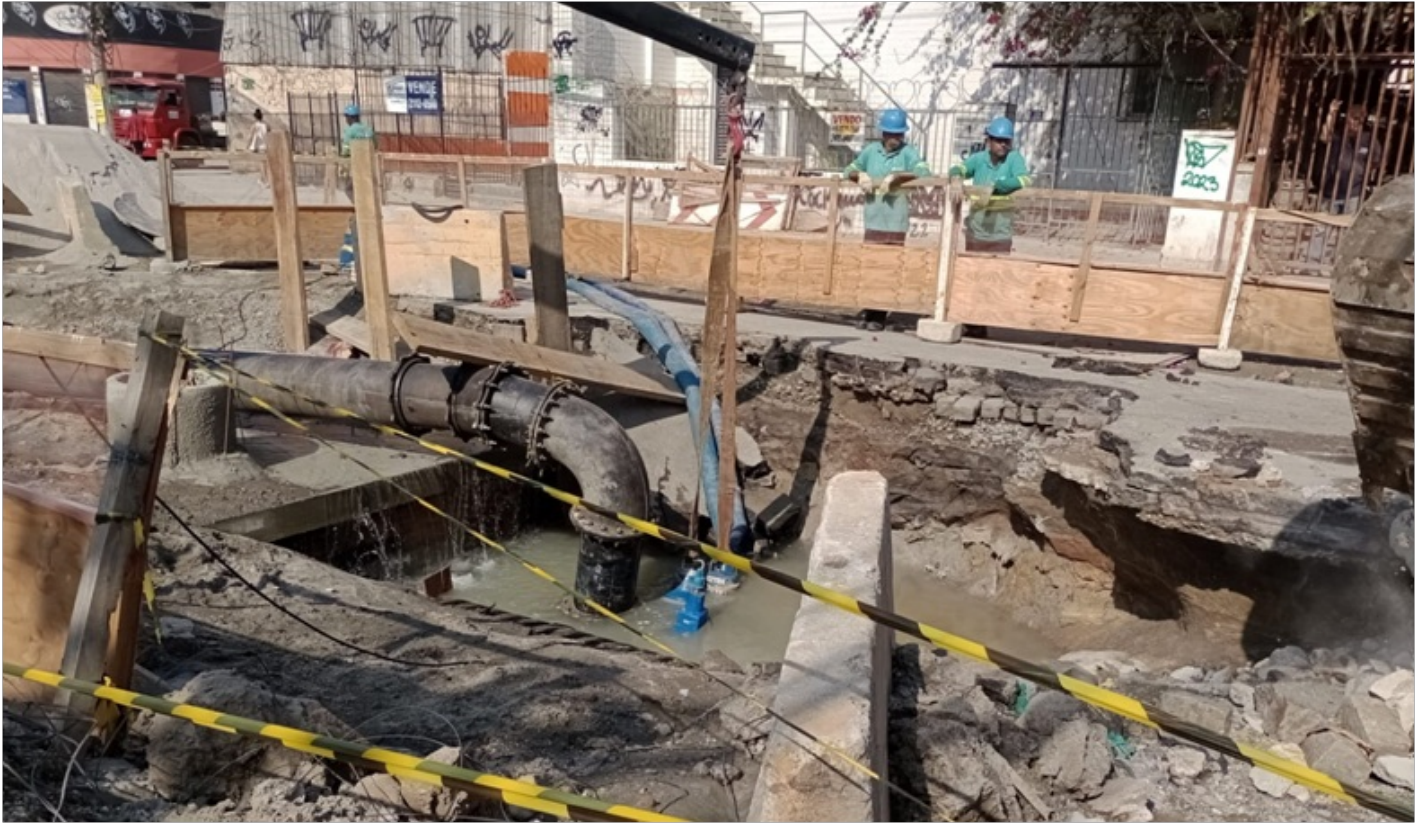
Foto 1 – Tubulação à montante
