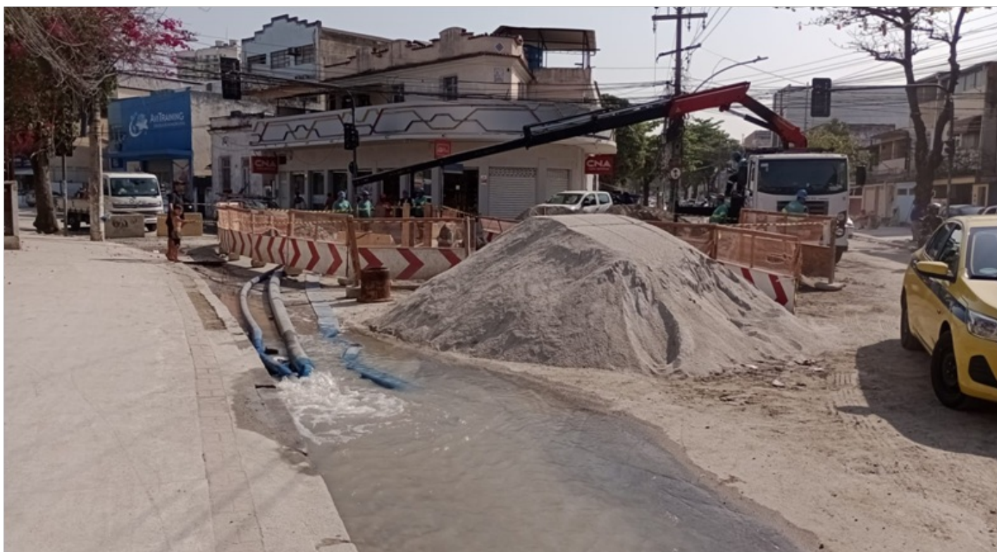
Foto 6 – Água sendo esgotada
