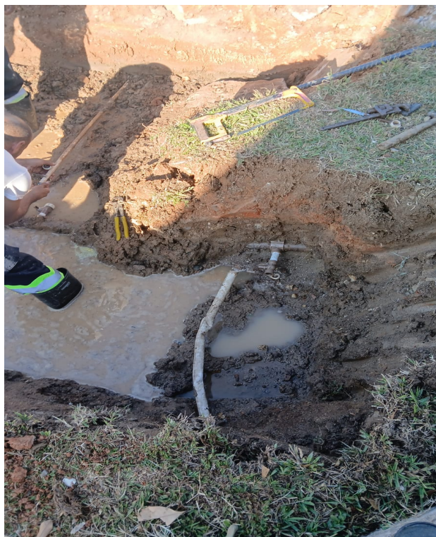
Foto 4. Reparo na rua do p.p.
