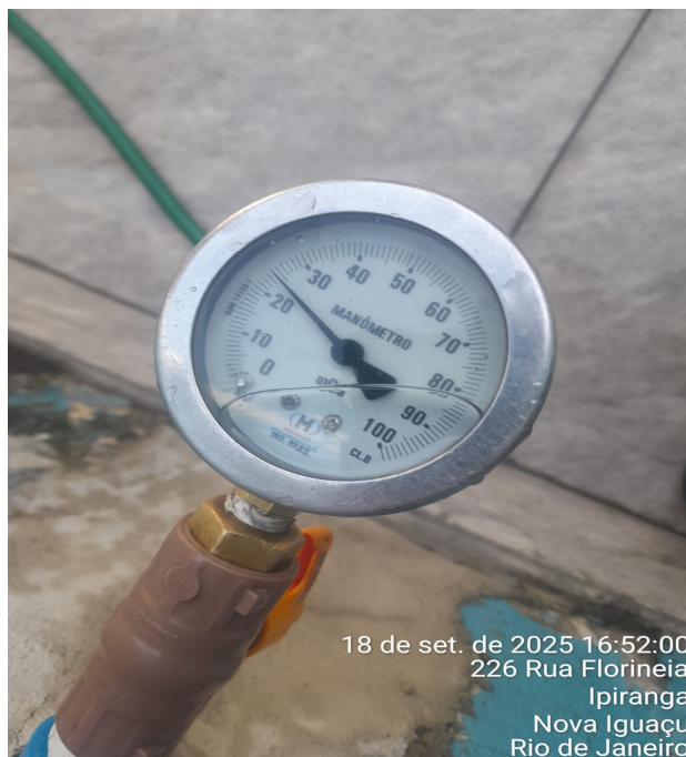
Foto 6. 24mca de pressão manométrica no logradouro do p.p. após o reparo.
