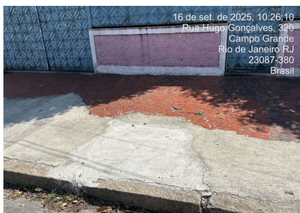
Fotos 8 e 9- Reparos de vazamentos recentes localizados na Rua Hugo Gonçalves
