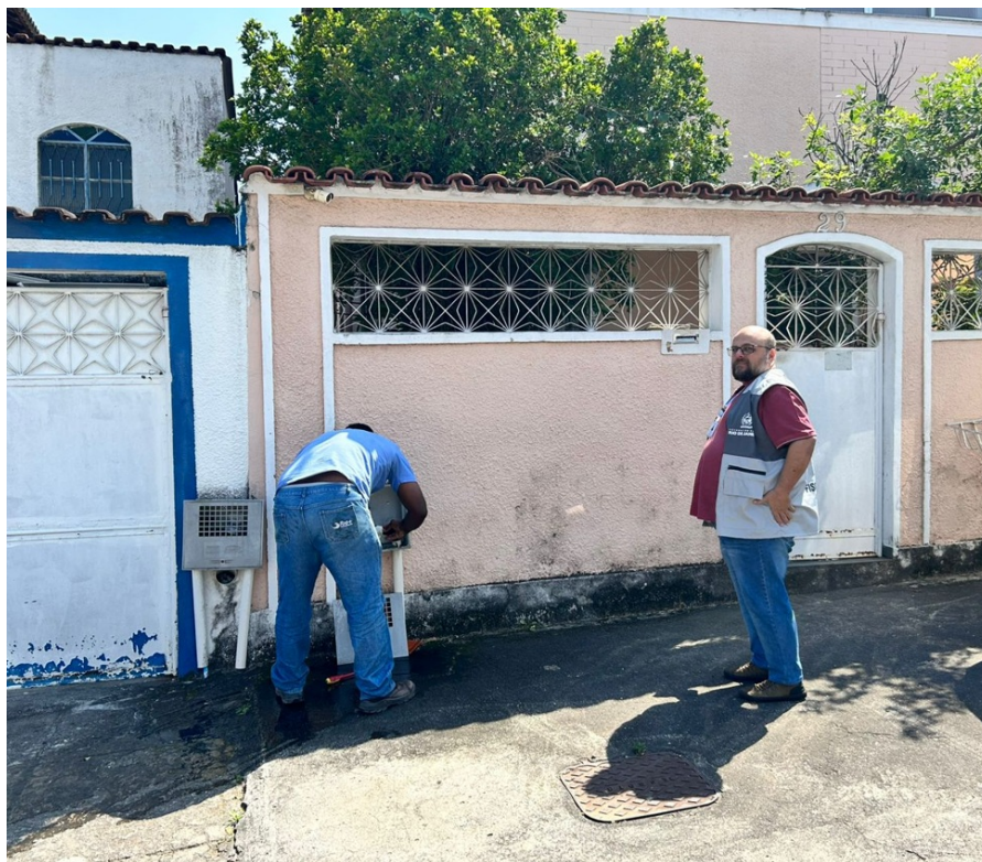
Foto 1- Imóvel nº 29, Rua Hugo Gonçalves
