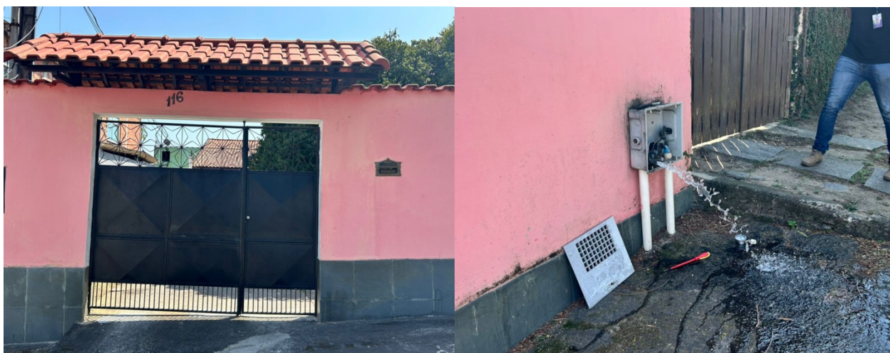
Fotos 4 e 5- Imóvel nº 116, Rua Hugo Gonçalves, com abastecimento
