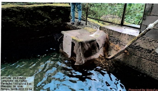
Foto 3: Gradeamento da barragem.
