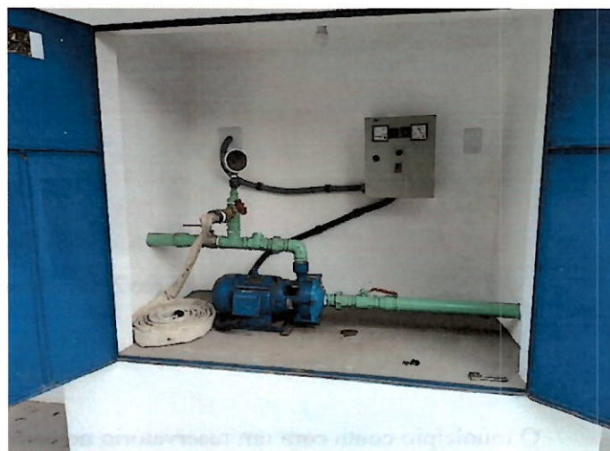
Foto 27: Booster utilizado para abastecer as partes altas do bairro.
