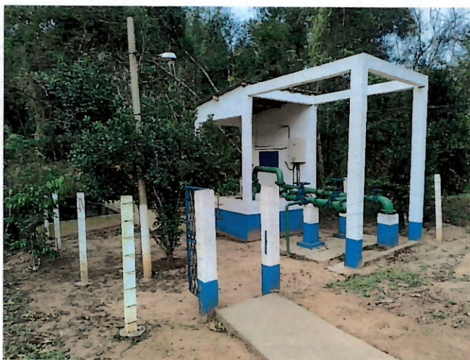
Foto 3: EEAB – área cercada e estrutura adequada.
