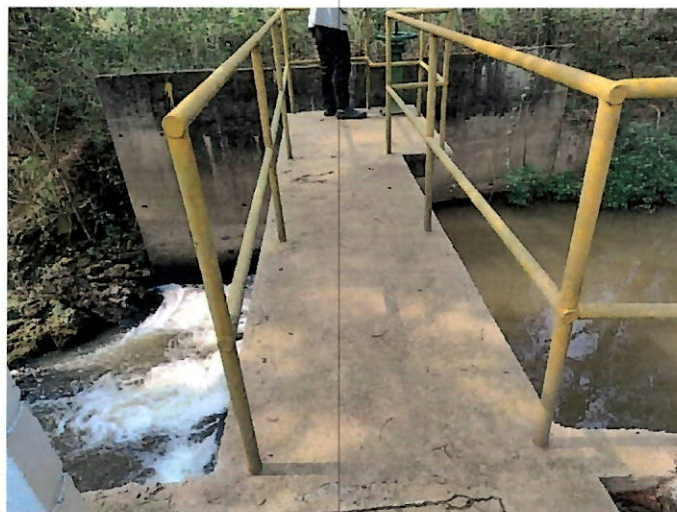
Foto 2: Captação – guarda-corpos instalados.
