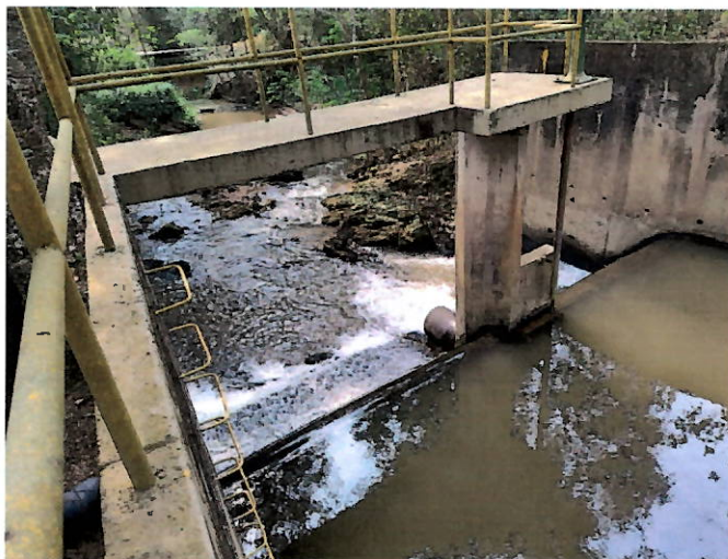
Foto 1: Captação – estrutura e barragem.
