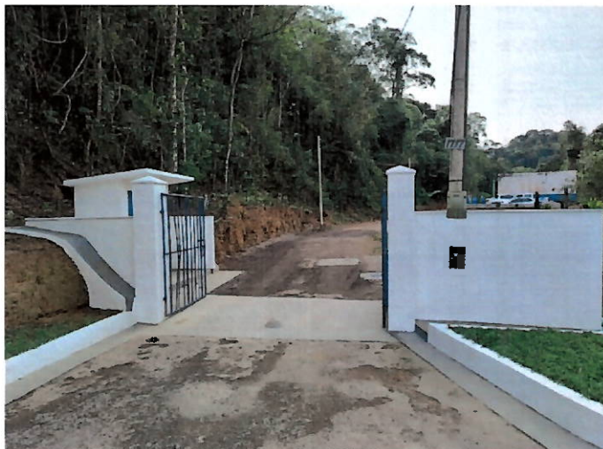
Foto 24: Acesso ao reservatório.
