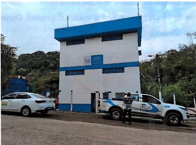
Foto 5: Fachada da ETA Palmas.
