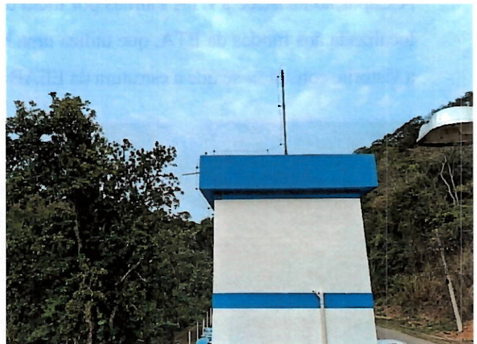
Foto 6: SPDA instalado.
