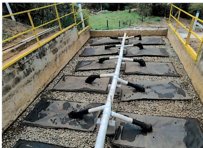
Foto 11: Geobags utilizados para o tratamento do lodo.
