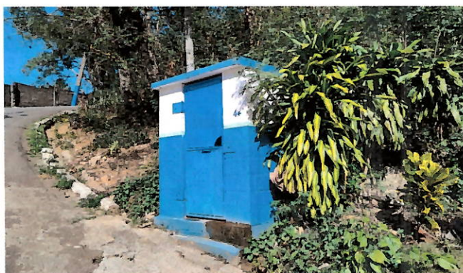
Foto 45: Abrigo do booster.
