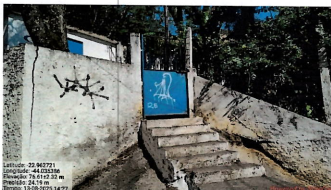
Foto 41: Acesso ao Reservatório R3.
