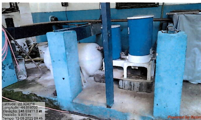
Foto 16: Sistema de tratamento com hipoclorito de cálcio.
