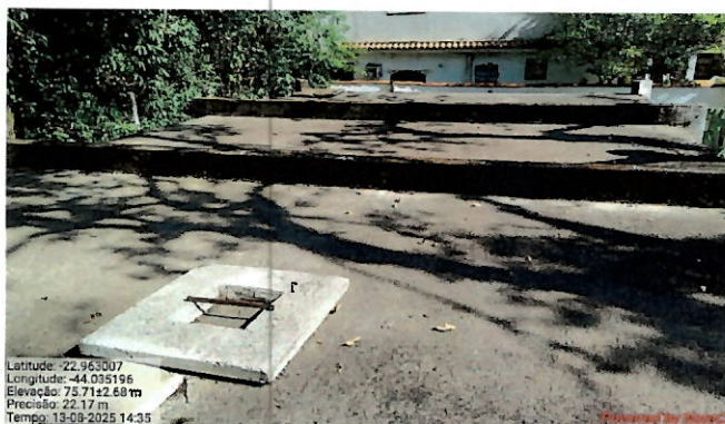
Foto 43: Parte superior do Reservatório R3.
