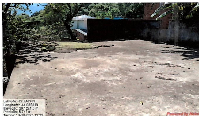
Foto 29: Parte superior do reservatório.
