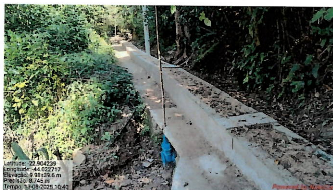
Foto 6: Reparo do vazamento. Tubulação instalada (protegida com concreto e areia).
