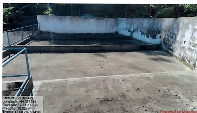
Foto 34: Parte superior do reservatório R2.
