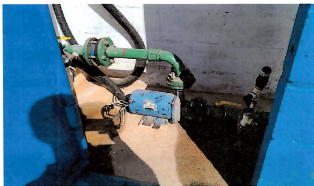
Foto 46: Bosster utilizado para abatecer parte alta de Ibicuí.
