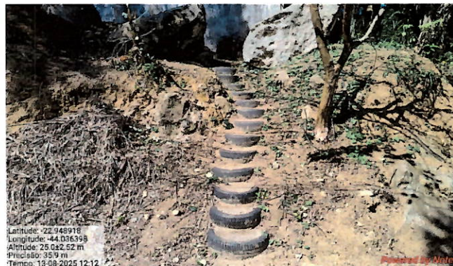
Foto 28: Escada de acesso ao Reservatório R1 (permanece inadequada).
