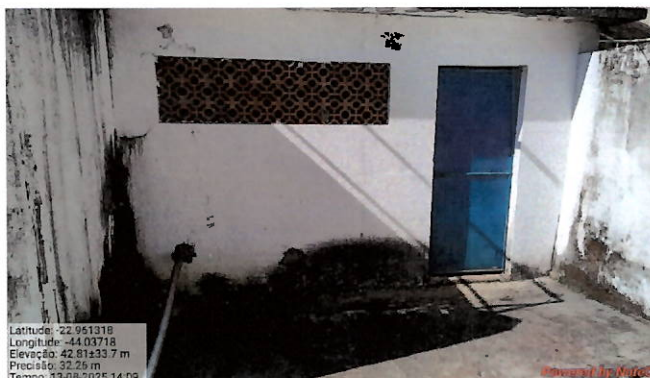
Foto 37: EEAT de Mangaratiba
