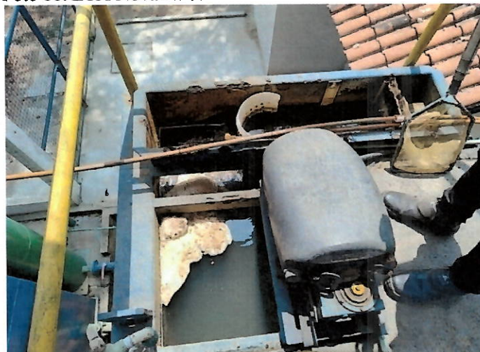
Foto 13: ETA Velha - chegada de água bruta e floculador.
