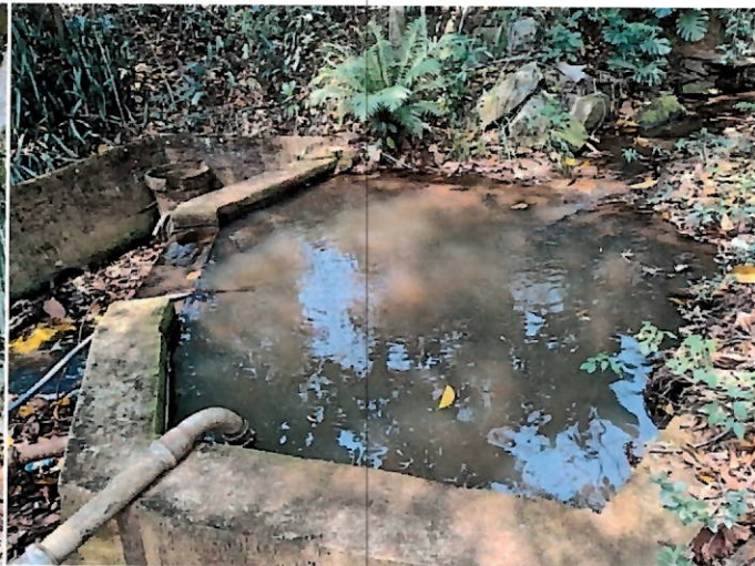
Foto 2: Captação Velha – necessidade de grade ou tela sobre a represa (horizontalmente) para evitar acúmulo de folhas.
