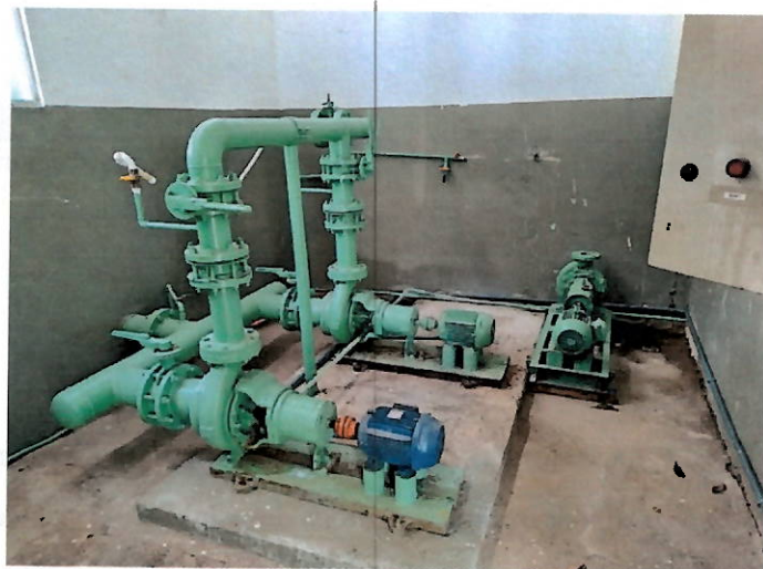
Foto 18: bombas utilizadas para retrolavagem dos filtros.
