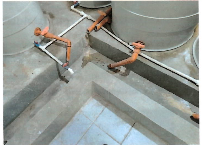
Foto 20: Canaletas de drenagem das águas de lavagem.
