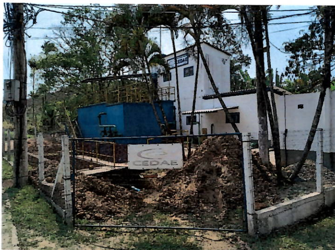
Foto 7: Fachada da ETA Morro Azul.
