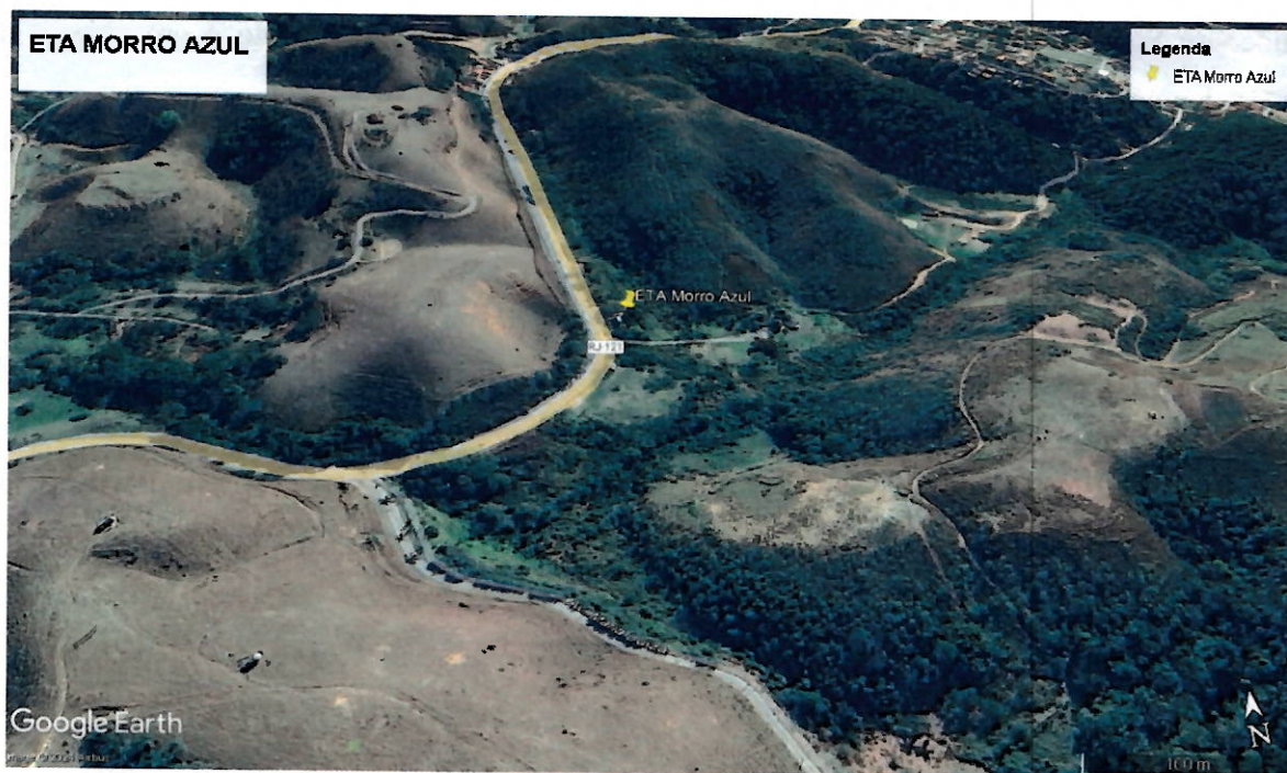
Imagem 1: Localização da ETA Morro Azul (imagem Google Earth).
