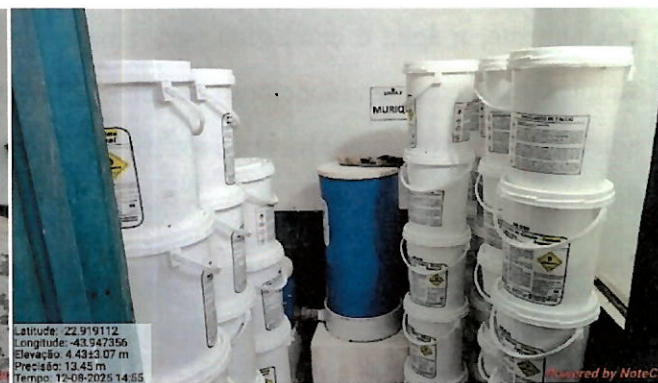
Foto 18: Armazenamento de hipoclorito de cálcio.
