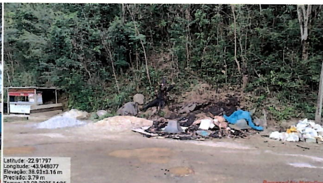
Foto 29: Terreno onde será instalada a nova ETA.
