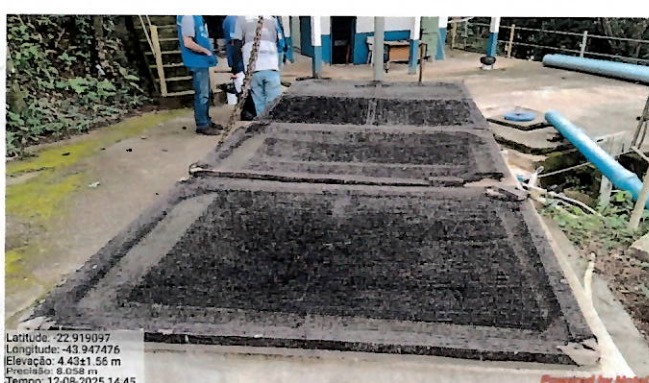
Foto 14: Tela de proteção da caixa de areia.
