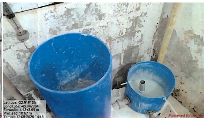
Foto 16: Sistema de desinfecção.
