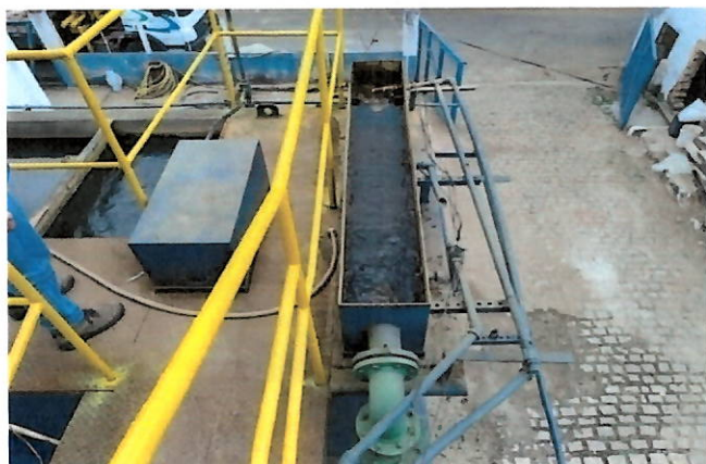
Figura 5- Calha Parshall.
