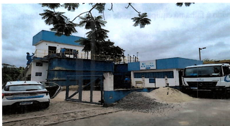
Figura 4- Fachada da ETA Vargem Alegre.
