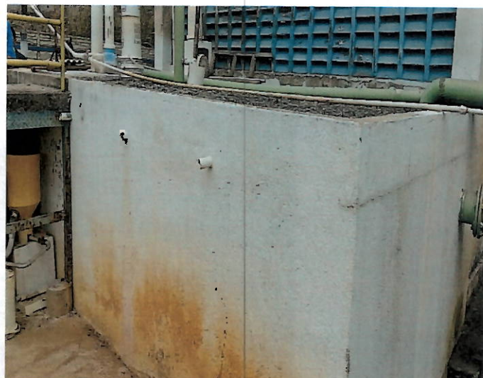
Figura 15- Tanque de contato 25 m 3 .
