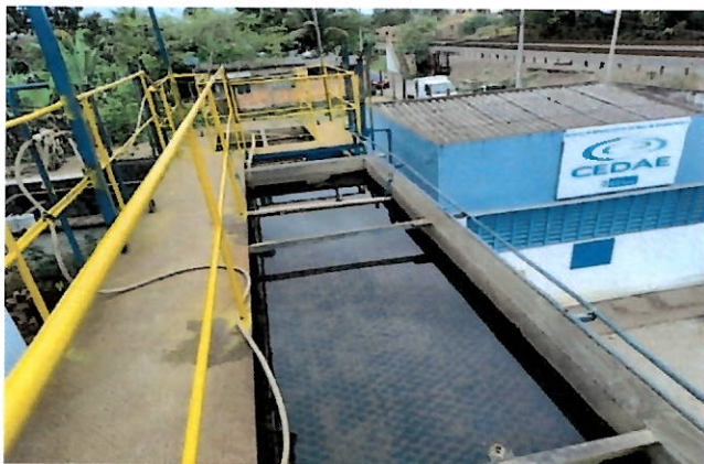
Figura 7- Decantador.
