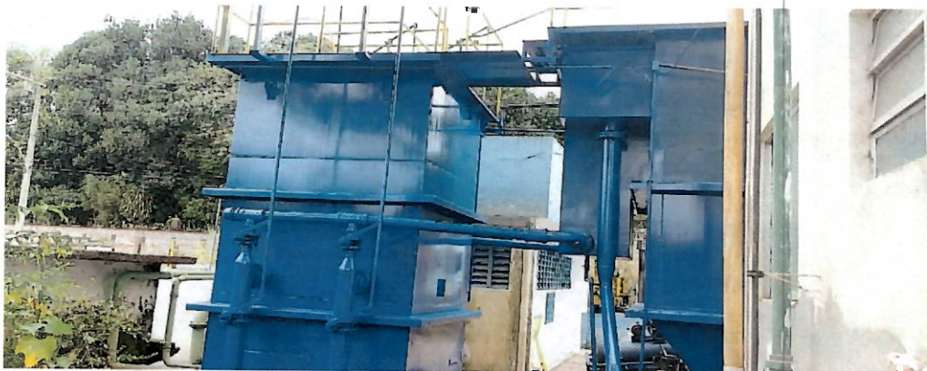
Figura 9 – A estrutura da ETA foi recentemente revitalizada, com a aplicação de uma nova camada de pintura.
