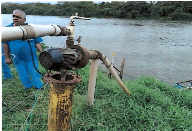
Figura 2- Cojunta motobomba de potência 5 cv (sucção direto do Rio).
