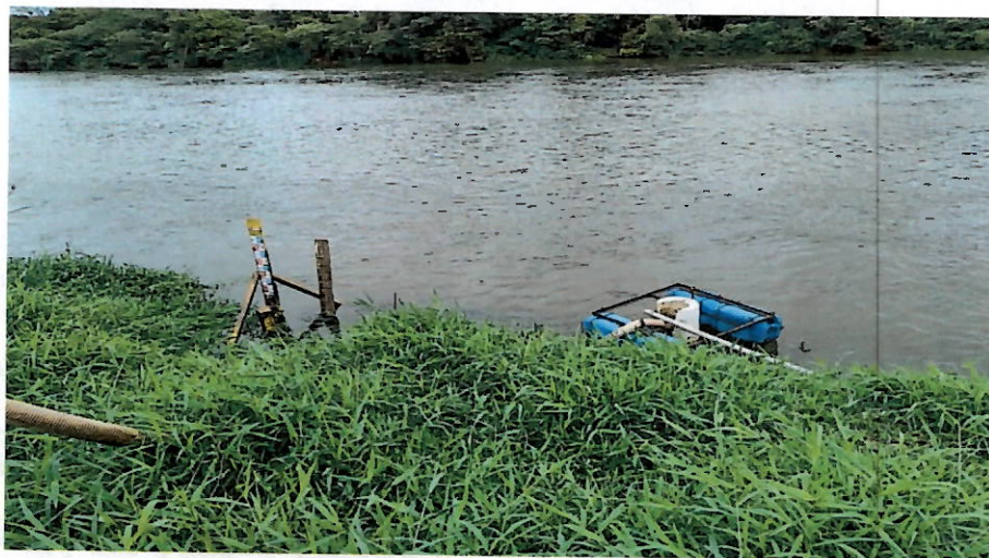
Figura 1- Captação de água realizada nas margens do Rio Paraíba do Sul.
