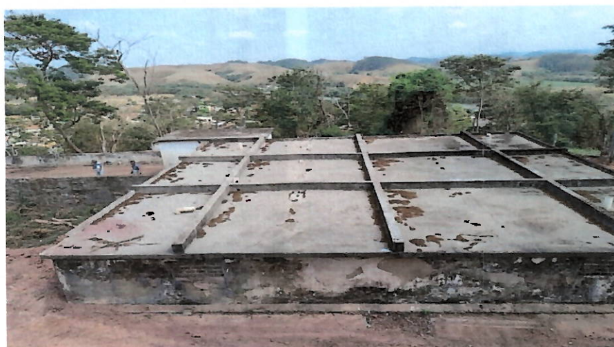
Figura 17- Vista superior do Reservatório.
