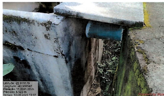
Foto 25: Ausência de vazamento identificado em vistoria anterior.
