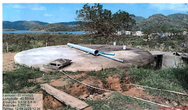
Foto 22: Reservatório de capacidade 200 m 3 .
