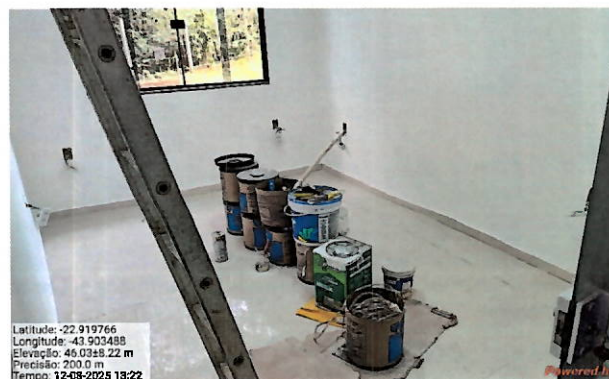
Foto 40: Base Operacional em obras.
