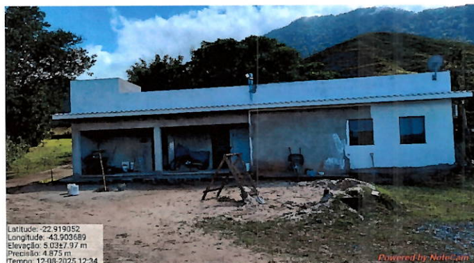
Foto 39: Base Operacional em obras.
