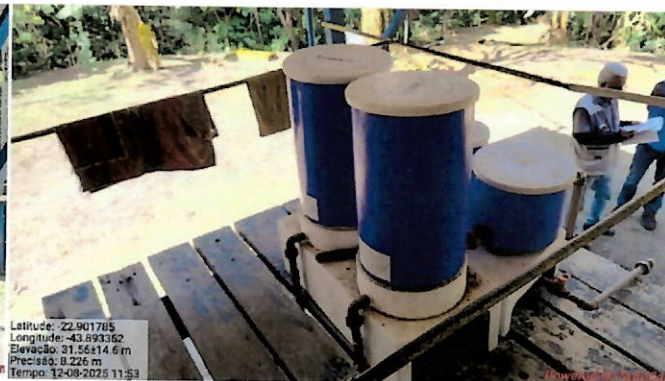
Foto 16: Sistema de desinfecção com hipoclorito de cálcio em pastilhas.
