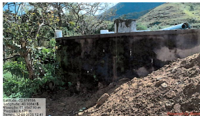
Foto 24: Ausência de vazamento identificado em vistoria anterior.
