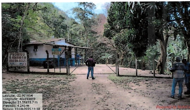
Foto 5: Entrada da UT Itinguçu (ausência de placa de identificação).
