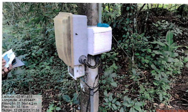
Foto 12: Quadro medidor de energia elétrica. Não atende a NR 10 e NBR 5410.
