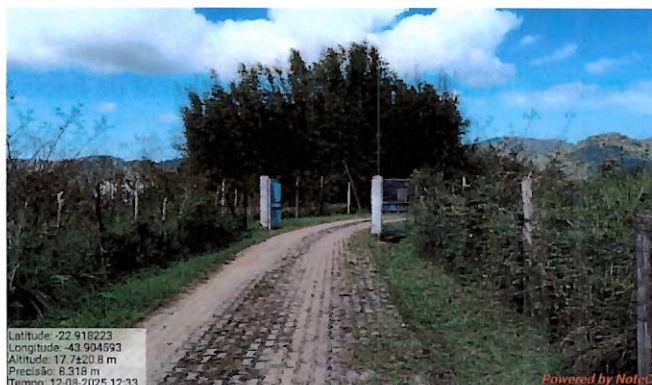
Foto 20: Acesso à Base Operacional. Nota-se a ausência de placa de identificação da unidade.
