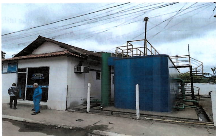
Foto 5- Fachada da ETA Ipiabas.
