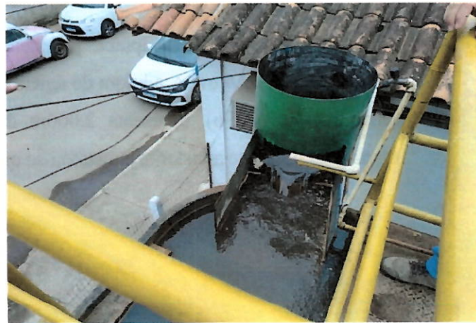
Figura 6- Calha Parshall.
