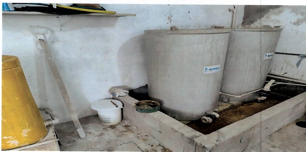
Figura 14 - Tanques de armazenagem do agente coagulante.
