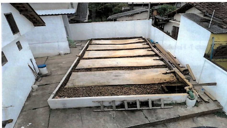
Figura 10- Leitos de secagem (Bags).
