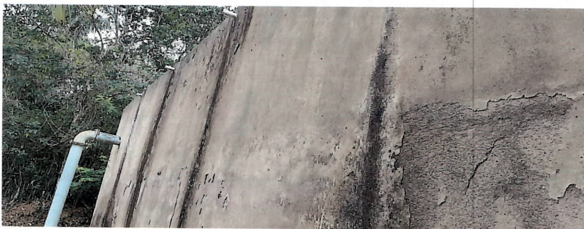
Figura 18- Vista lateral do Reservatório.
