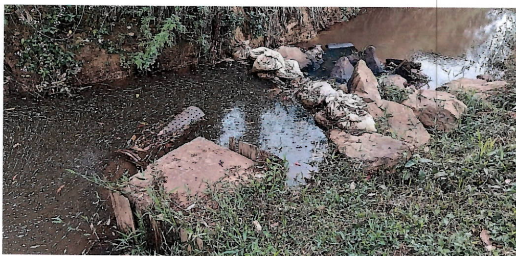
Foto 1 – Ponto de captação.
