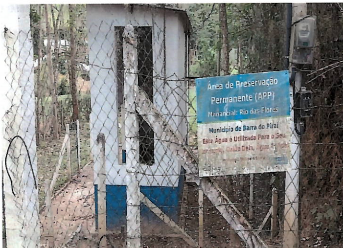
Foto 2- EEAB – Area cercada e estrutura adequada.
