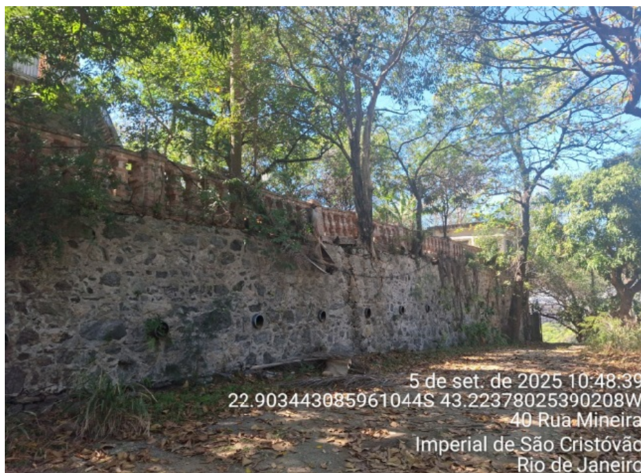
Foto 3. Muro entre a entrada da Unidade e o Reservatório
