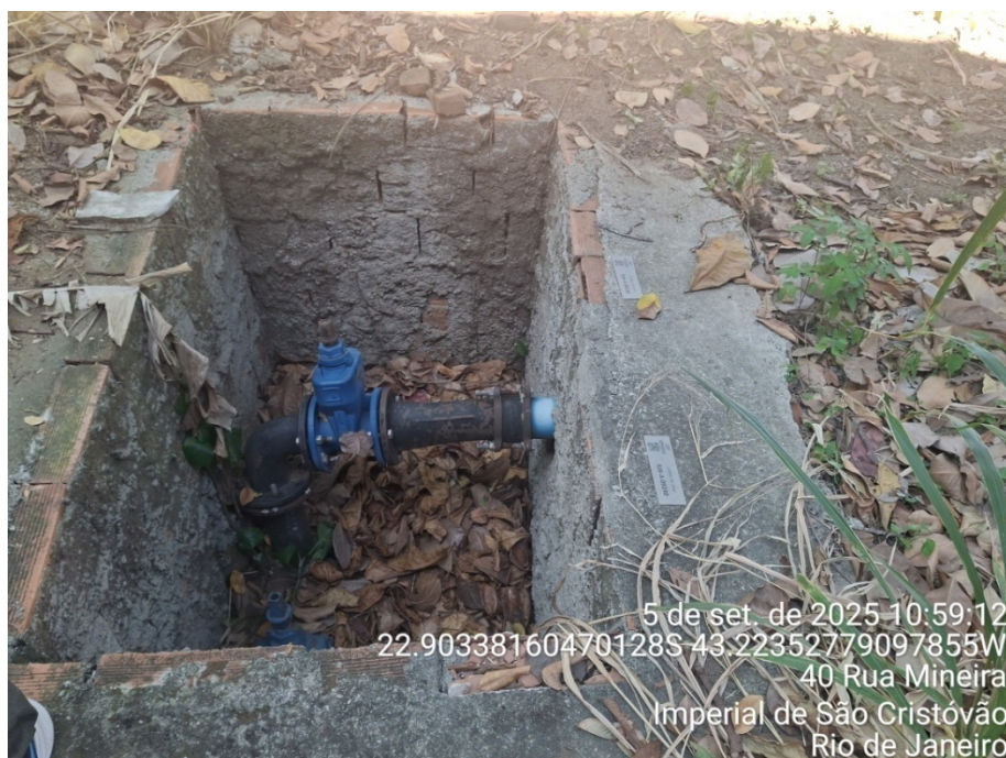
Foto 4. Estrutura do by-pass
