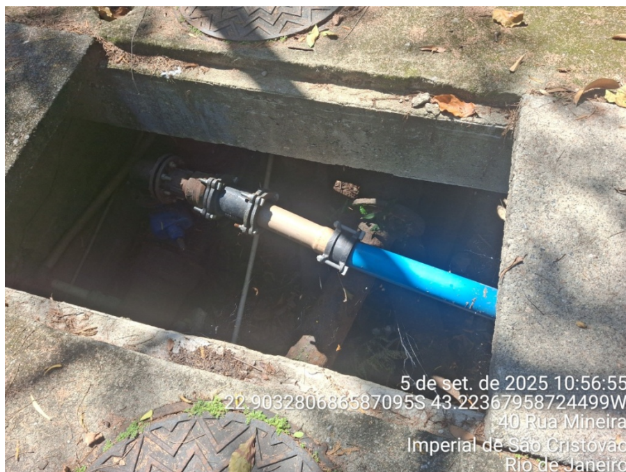
Foto 5. Estrutura do by-pass
