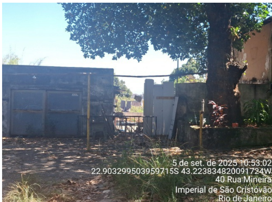
Foto 7. Terreno ocupado pela casa
