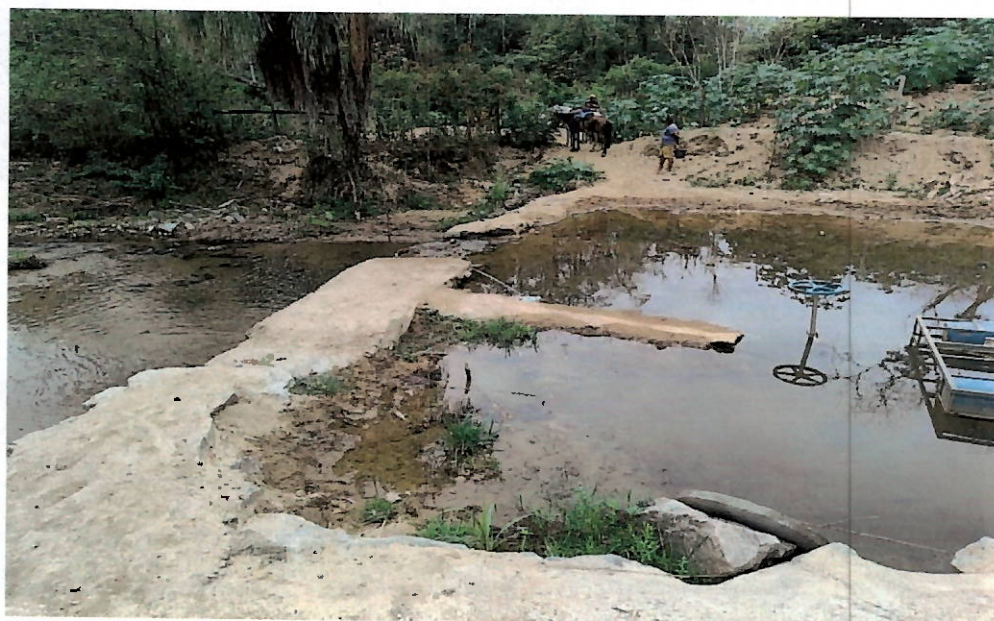
Figura 2- Área de captação mostrando acesso de pessoas não autorizadas.
