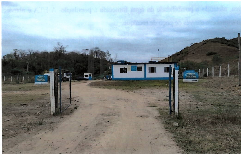
Figura 3- Entrada da Estação de Tratamento de Água Vale do Ipiranga.
