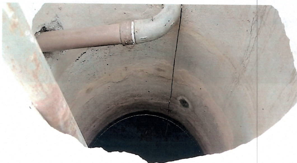
Figura 10- Poço de recalque.
