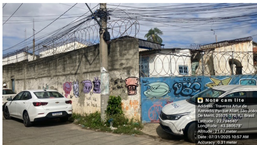
Foto 2. Entrada da Unidade.
