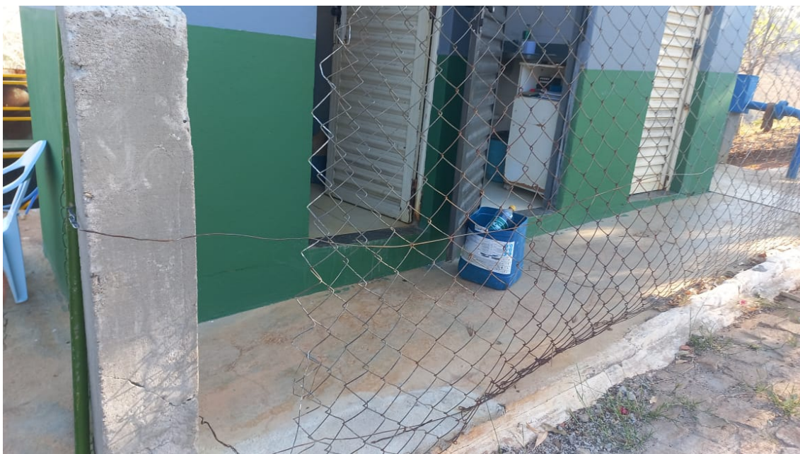
Foto 09 - detalhe da abertura
