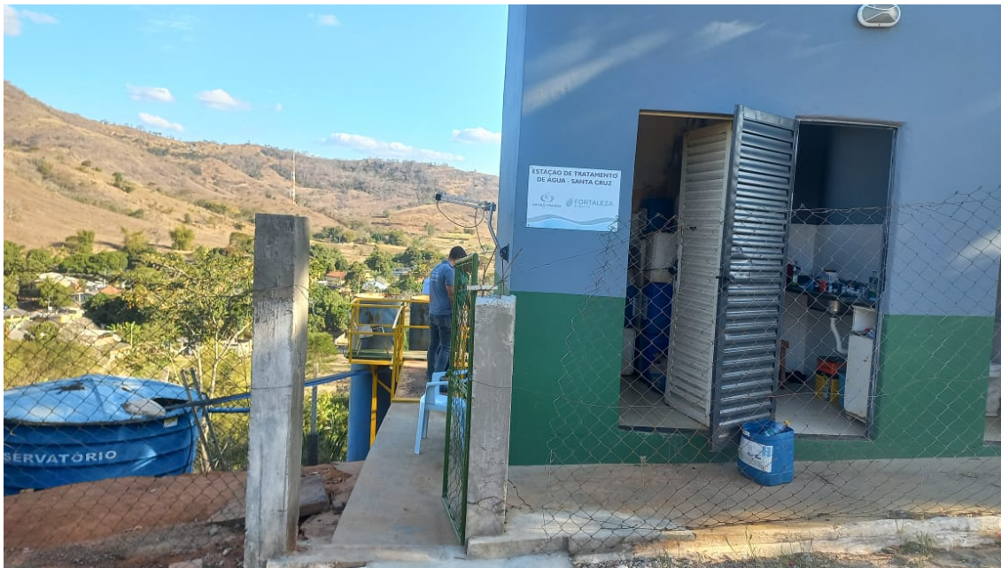
Foto 01 - entrada e identificação
