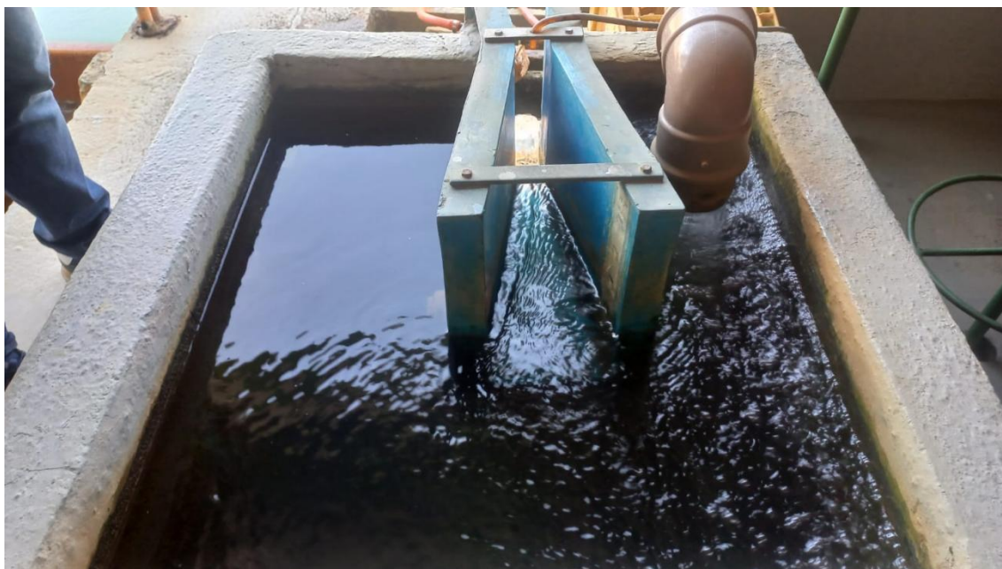
Foto 02 - calha Parshall na entrada do tratamento
