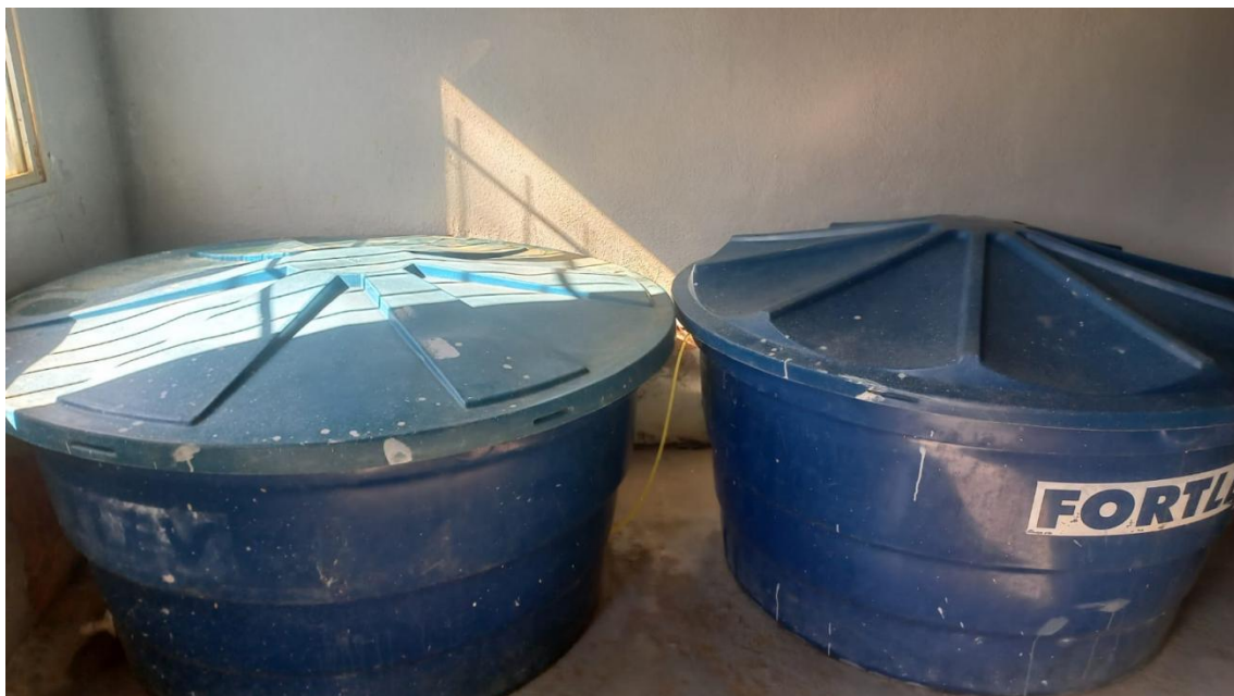
Foto 08 - recipientes sem bacia de contenção
