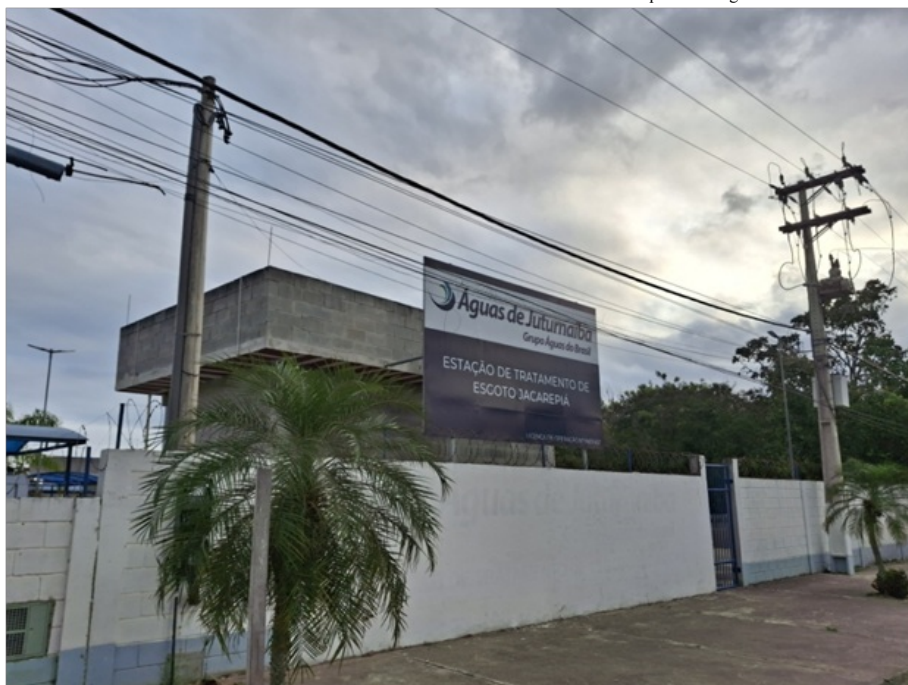
Foto 11 – Vista da fachada da ETE, pintada e identificada
