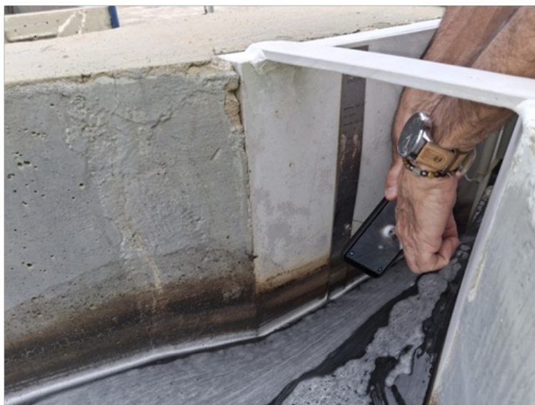
Foto 6 – Calha Parchall (escala de medição de vazão)
