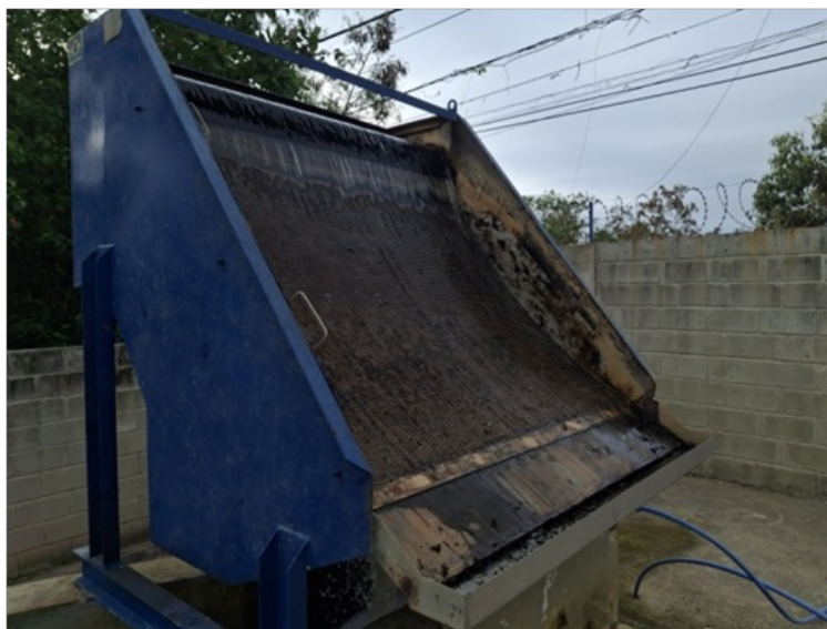
Foto 3 – Gradeamento com chapa da calha coletora trocada
