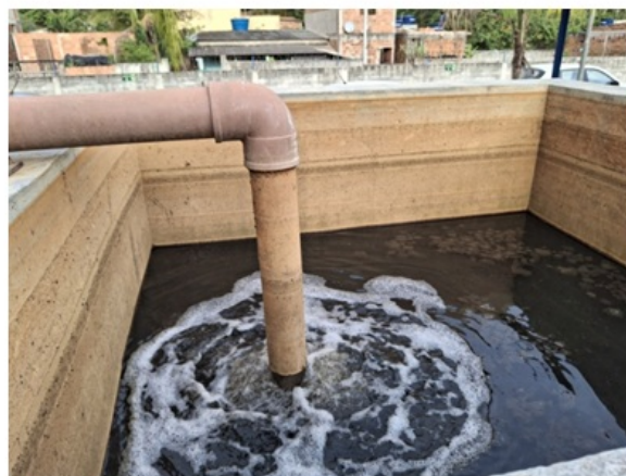
Foto 17 e 18 – Tratamento do lodo (coagulação)
