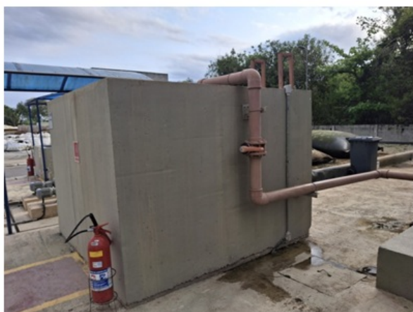
Foto 17 e 18 – Tratamento do lodo (coagulação)
