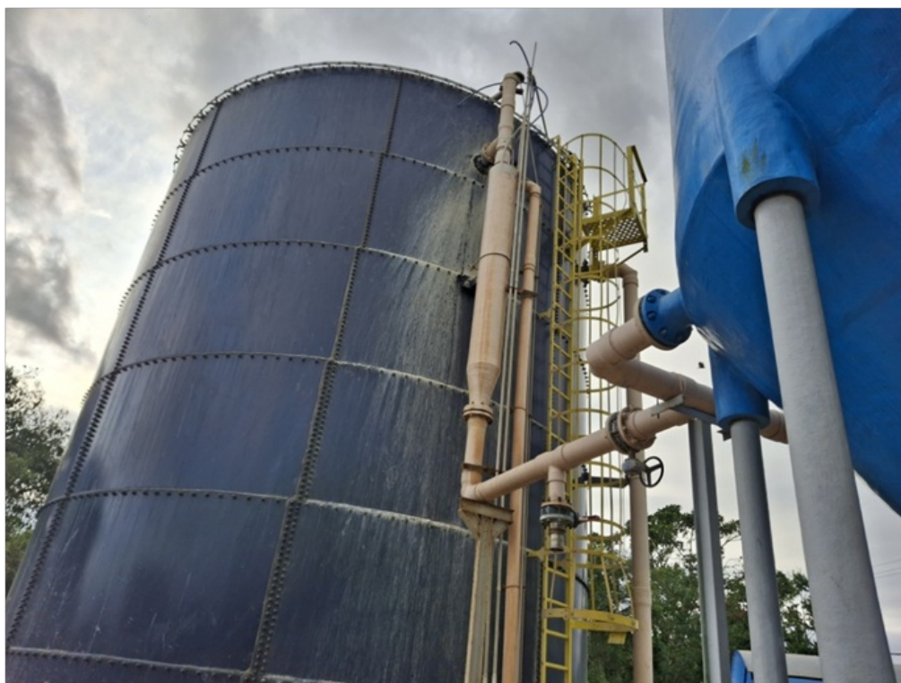
Foto 9 – O projeto utiliza tubo Venturi para economizar energia no processo.
