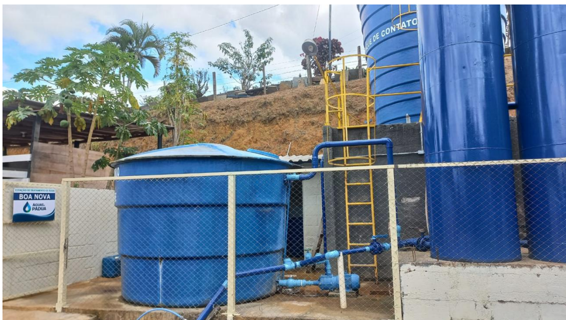
Foto 02 - tanque de contato e filtros
