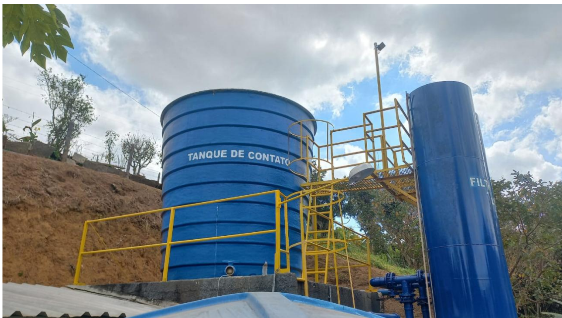
Foto 02 - tanque de contato e filtros
