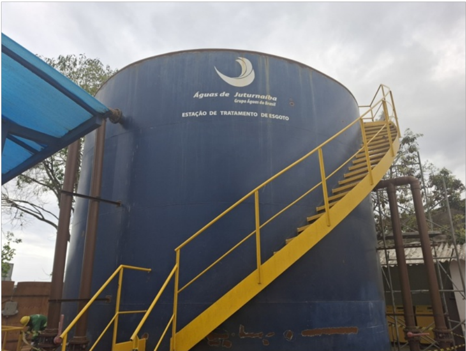
Foto 2 - Reator RANOX , com tratamento primário na parte central e secundário na externa (radial).
