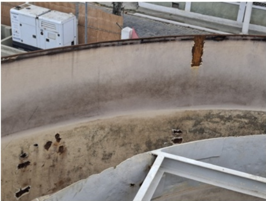
Foto 3 e 4 – Reator parado para reforma (perfis internos oxidados e chapa externa)
