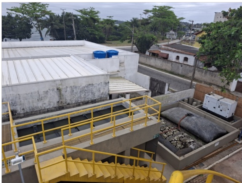
Foto 8 – Gerador para segurança operacional, com baia de contenção e depósito de óleo diesel; Baia de armazenamento de secagem de lodo em bag's ; Tratamento Terceário que está sendo utilizado como tratamento de esgoto com dosagem de PAC , durante a reforma do reator.
