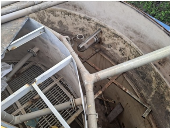
Foto 3 e 4 – Reator parado para reforma (perfis internos oxidados e chapa externa)
