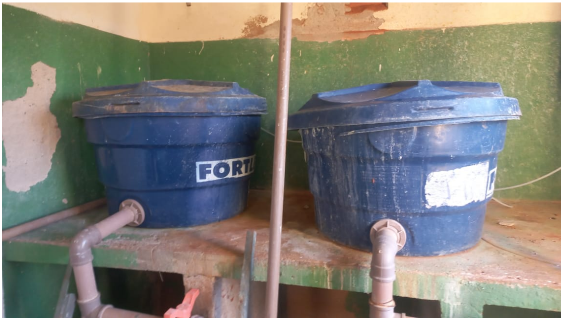
Foto 06 - tanques de sulfato
