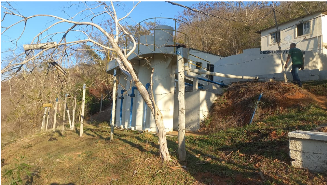
Foto 01 - entrada da ETA
