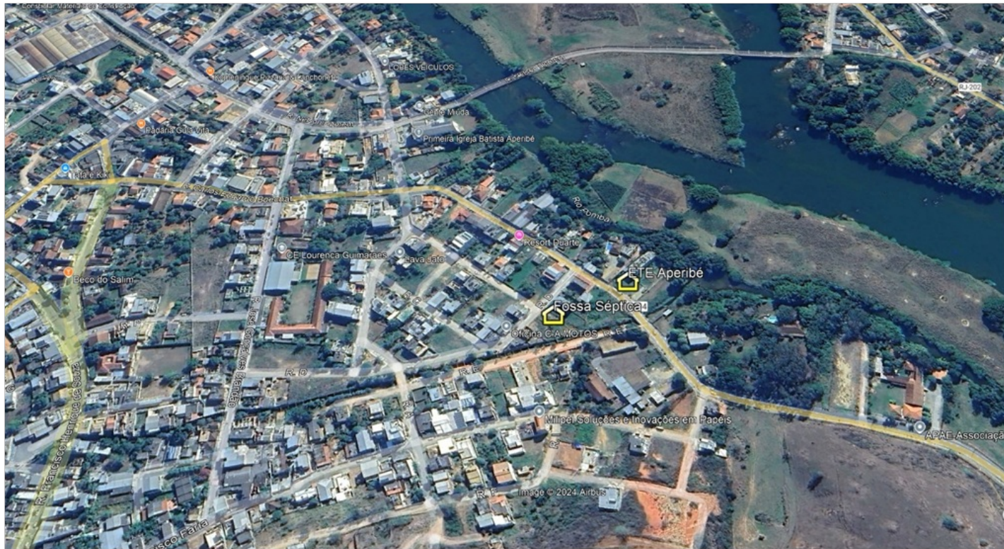
Foto 1 – Localização da ETE Aperibé
