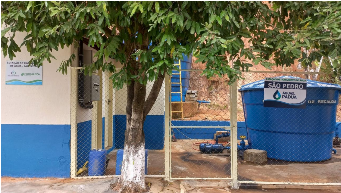
Foto 01 - entrada da estação e identificação
