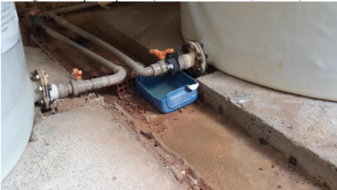
Foto 11 - vazamento; é possível observar recipiente para contenção do líquido
