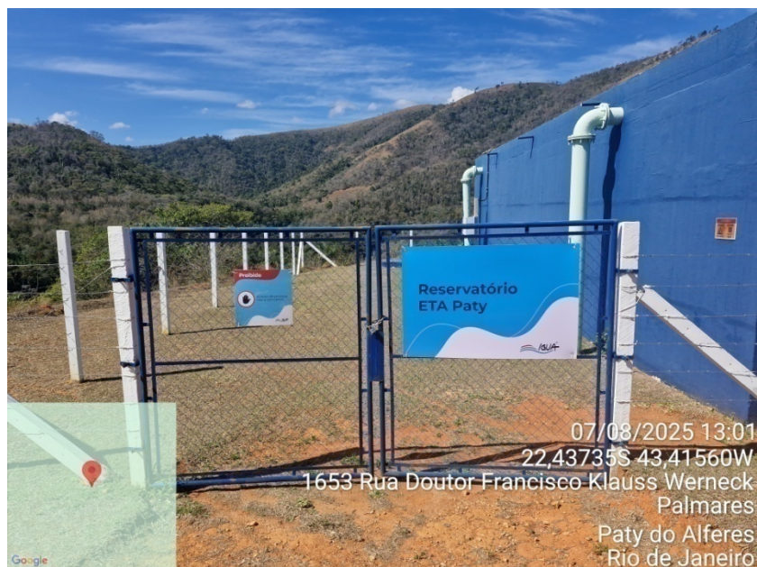
Foto 1 – Entrada do reservatório com identificação
