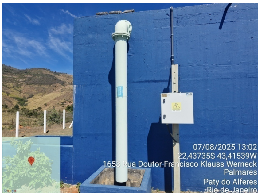
Foto 8 – Tubulação extravasora
