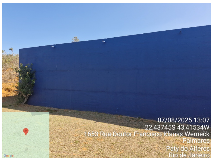
Foto 10 – Vista de trás do reservatório
