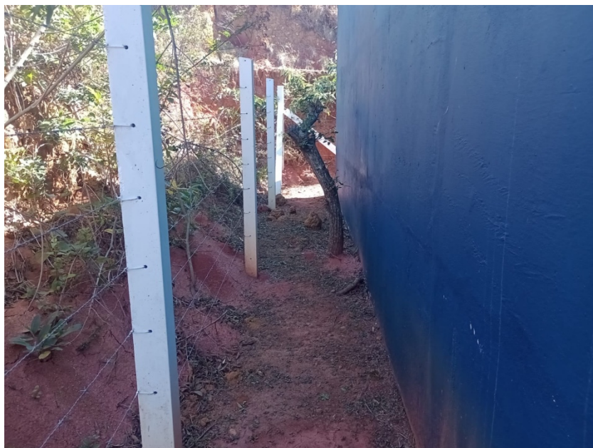
Foto 11 – Vista lateral esquerda do reservatório
