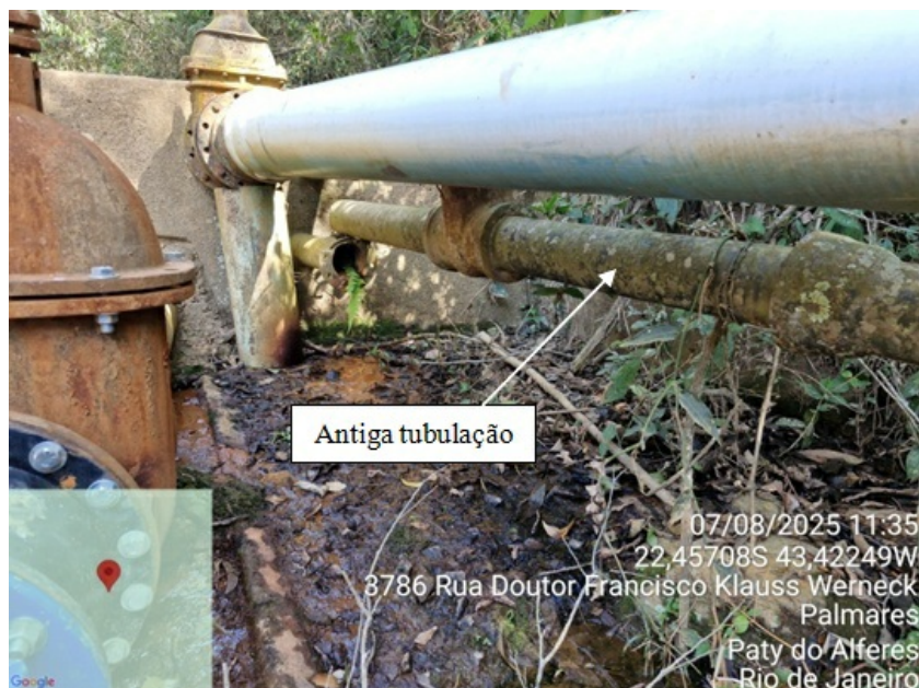
Foto 17 – Antiga tubulação adutora
