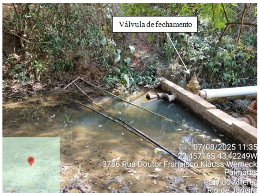
Foto 11 – Água direcionada para a tubulação
