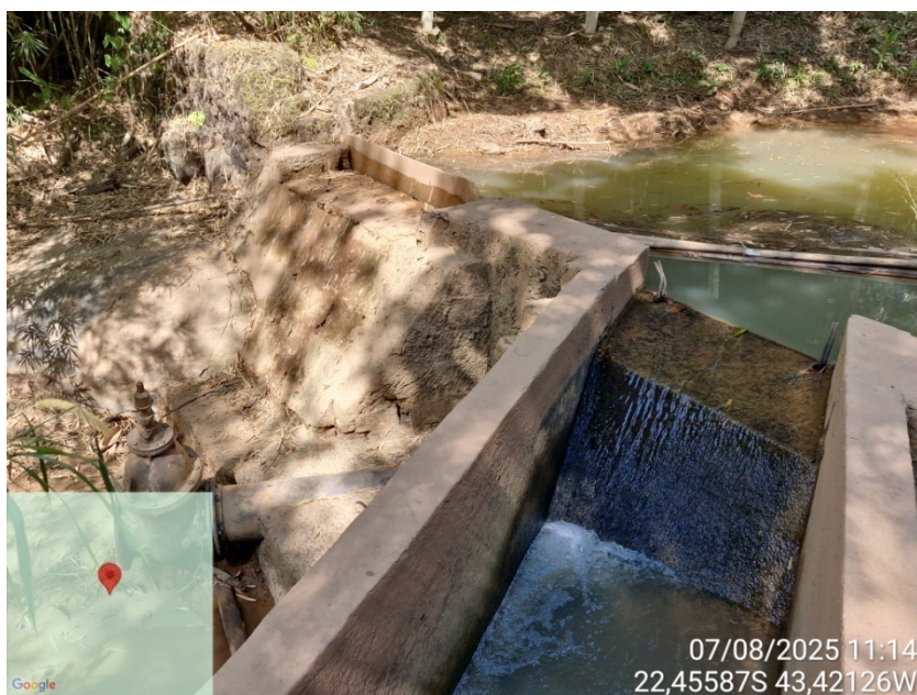
Foto 13 – Canal de captação
