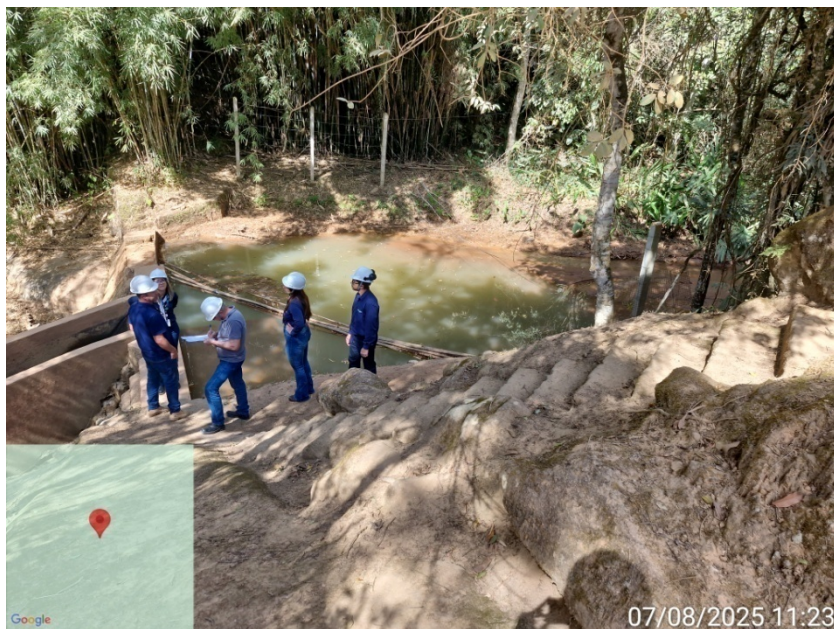
Foto 5 – Vista geral da captação
