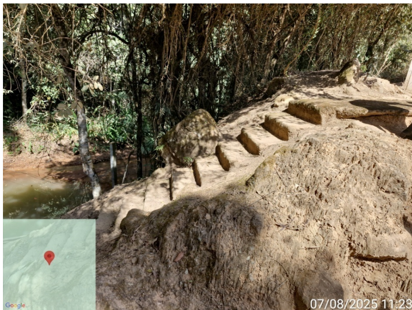
Foto 7 – Escada de acesso
