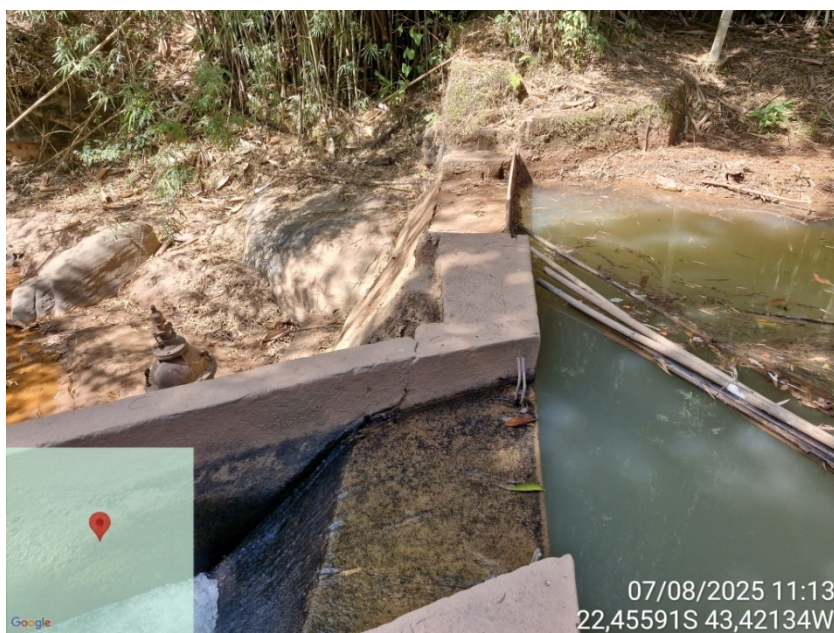
Foto 12 – Canal de captação
