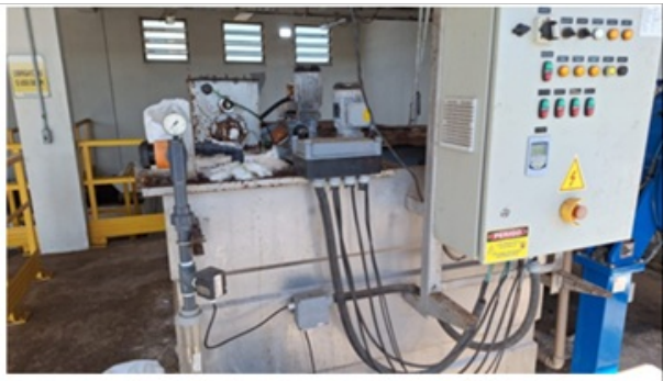
Fotos 14 e 15 – EEE de lodo adensado recalca para centrífuga; preparador de polímero para adição na centrífuga otimizando a coagulação e conseqüente desidratação do lodo.
