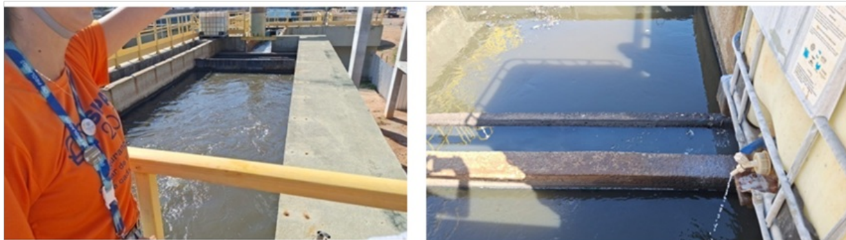
Fotos 7 e 8 – Desarenador com dosagem eventual de anti-espumante.
