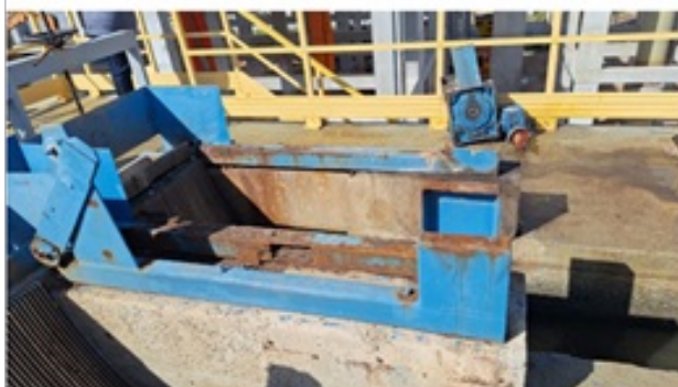
Fotos 4, 5 e 6 – Gradeamento mecanizado em ruínas, operando limpeza manualmente. Canaleta do parafuso raspador sem o equipamento.
