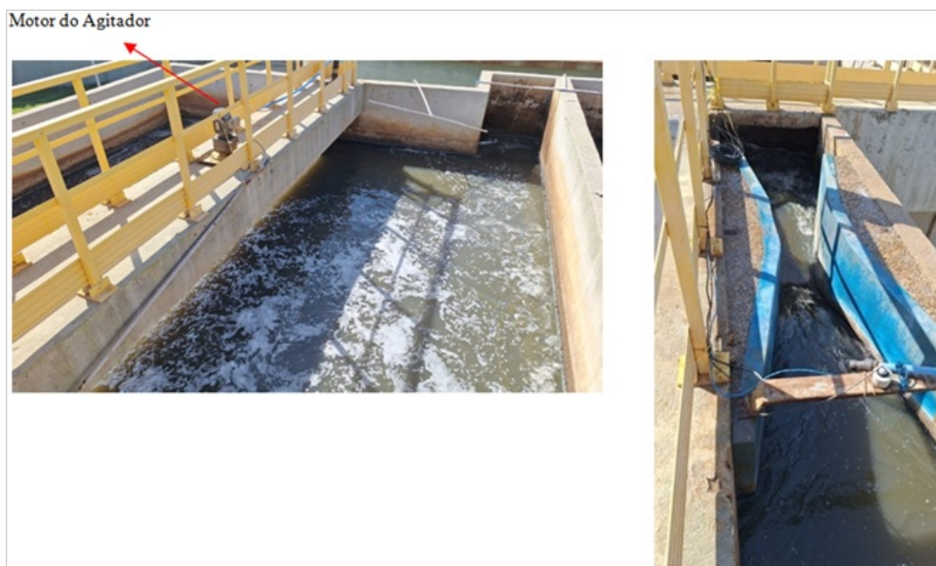
Foto 9 e 10 – Calha Parshall ; Tanque anóxico para remoção de Nitrogênio com adição de PAC ; Agitação para otimizar a floculação.
