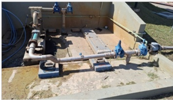
Fotos 14 e 15 – EEE de lodo adensado recalca para centrífuga; preparador de polímero para adição na centrífuga otimizando a coagulação e conseqüente desidratação do lodo.
