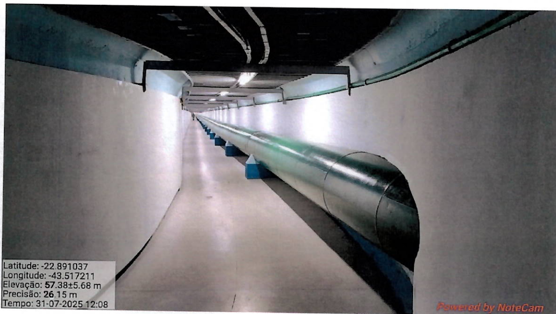
Foto 03 - Tubulação de esgotamento emergencial.
