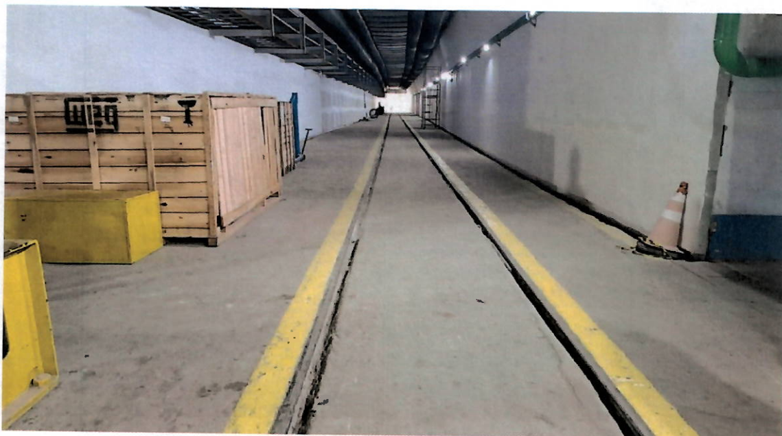
Foto 16 - Trilho para transporte dos equipamentos.
