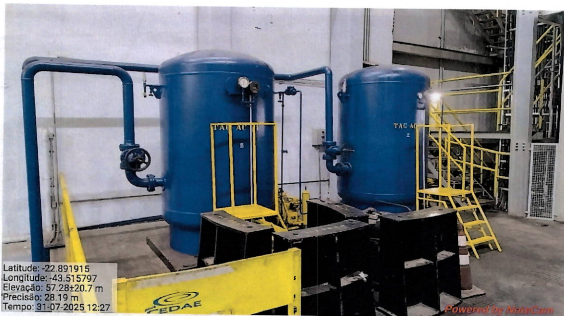
Foto 08 - Tanque de ar comprimido.
