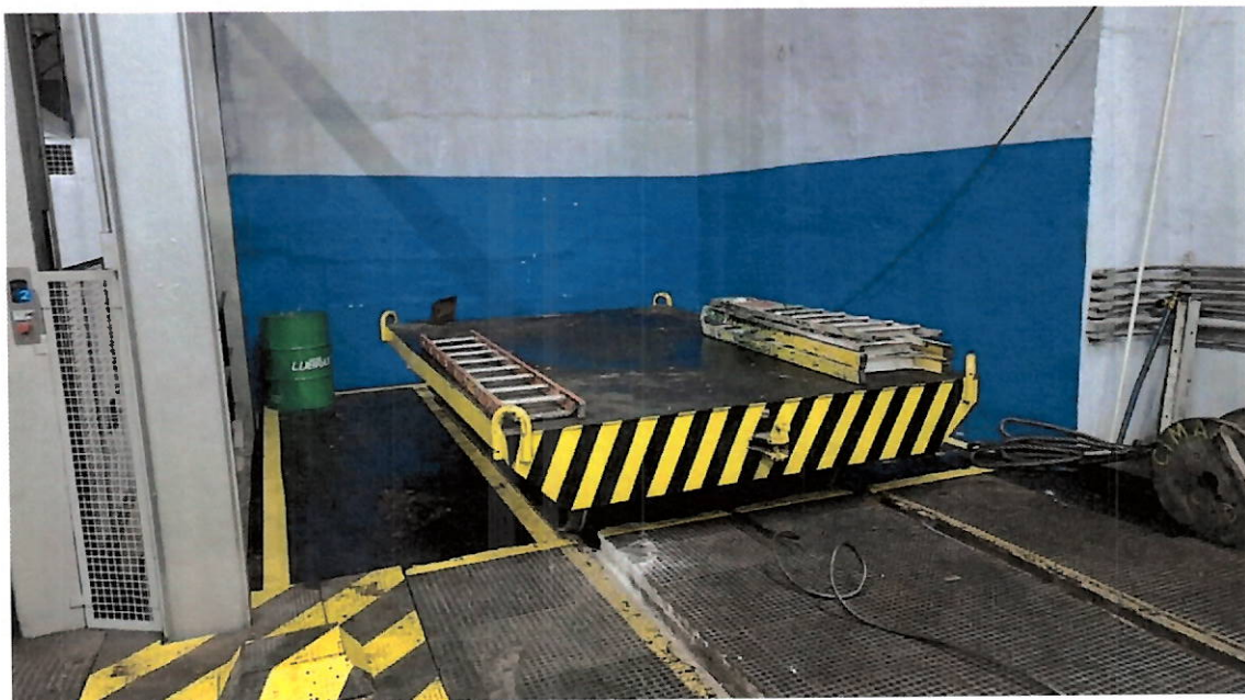
Foto 13 - Plataforma para elevação de equipamentos.
