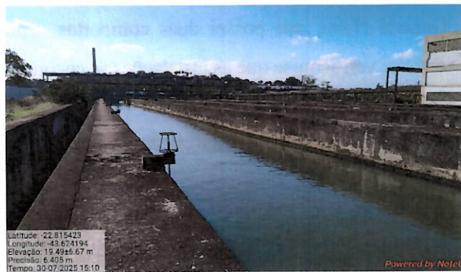
Foto 20: canal desarenador.
