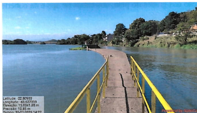
Foto 13: acesso à barragem flutuante.
