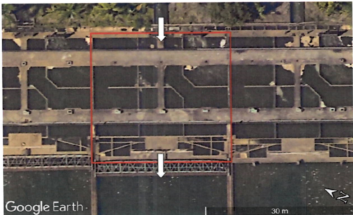
Imagem 5: Vista superior de um dos tanques de floculação com indicação da direção do fluxo da água em direção à decantação.
