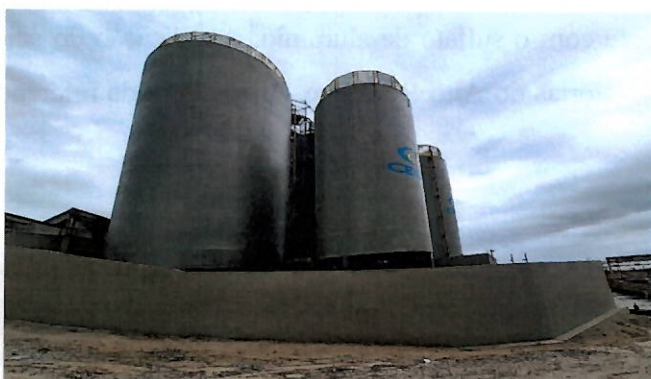
Foto 118: silos de armazenamento de sulfato de alumínio reformados.
