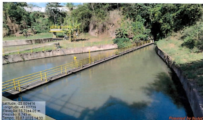
Foto 16: tomada de água velha.
