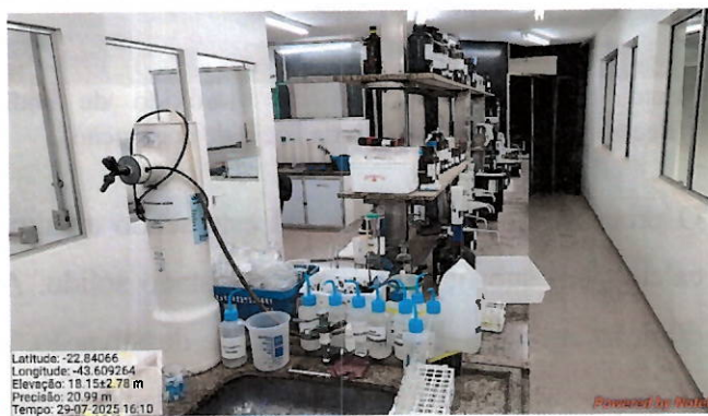
Foto 141: laboratório em reforma.
