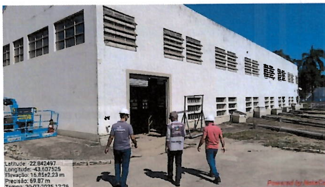
Foto 146: entrada da elevatória ARG.
