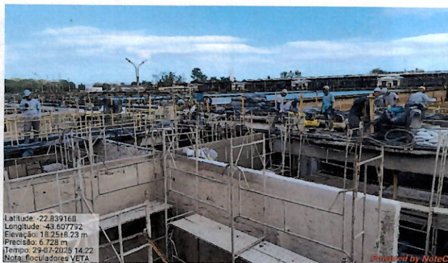
Foto 58: obras civis sendo realizadas no floculador 7.
