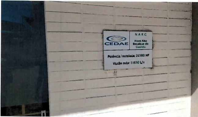
Foto 150: entrada da elevatória NARG.
