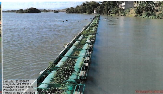
Foto 14: Barragem Flutuante a montante da tomada de água.
