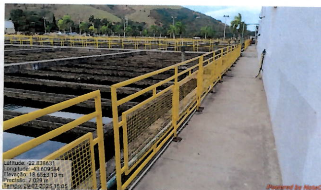
Foto 84: trecho com guarda-corpos.
