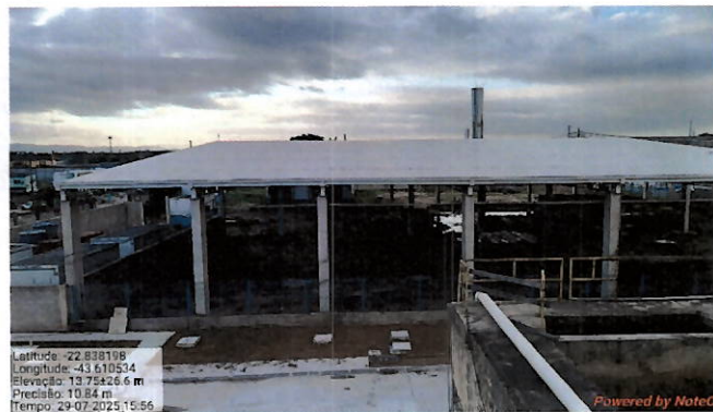
Foto 159: área onde será realizado o tratamento do lodo.
