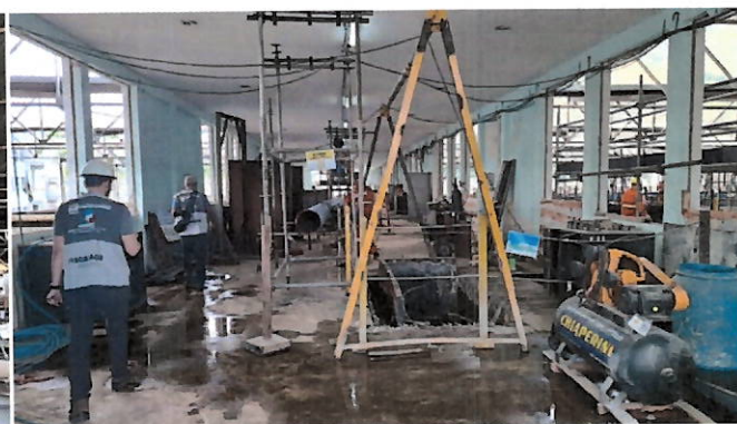
Foto 66: galeria em reforma.
