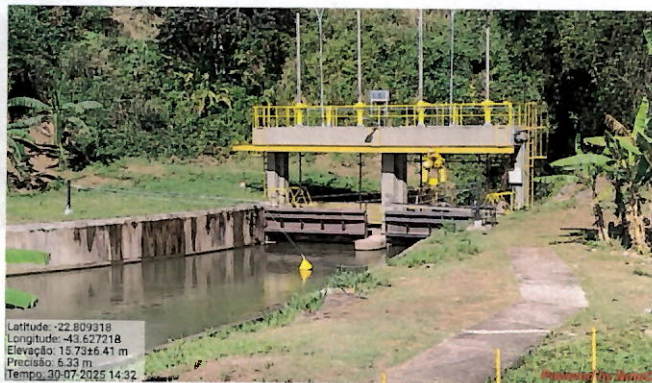
Foto 18: tomada de água nova.
