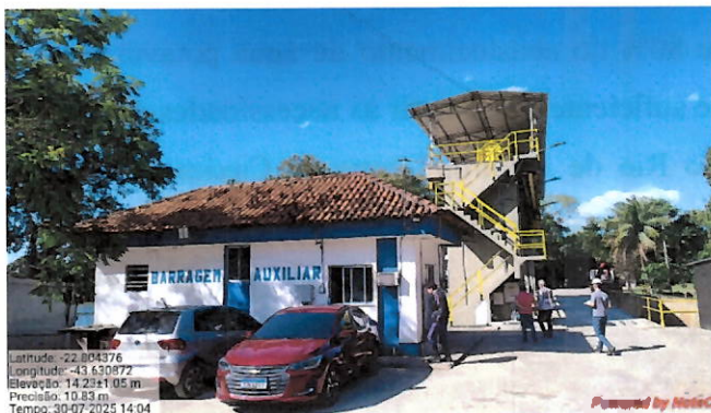
Foto 1: entrada da barragem auxiliar.
