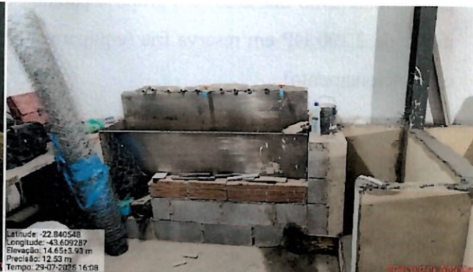
Foto 143: área de coleta de amostra sendo construída.
