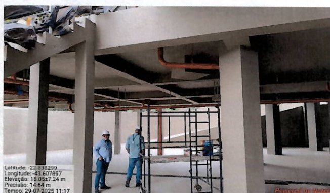
Foto 121: obra em fase final de conclusão.
