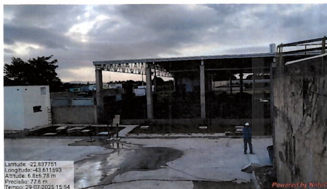
Foto 158: área onde será realizado o tratamento do lodo.
