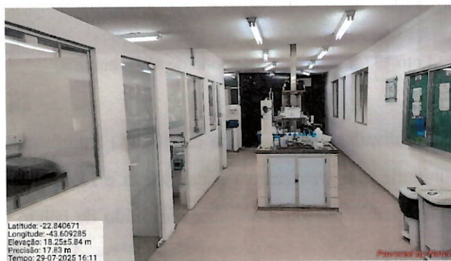
Foto 140: laboratório em reforma.
