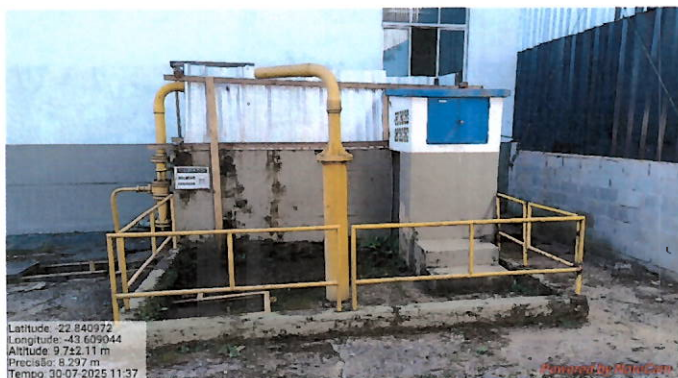
Foto 133: um dos pontos onde é aplicada solução clorada (não foi identificado vazamento de cloro e houve limpeza de vegetação no local).
