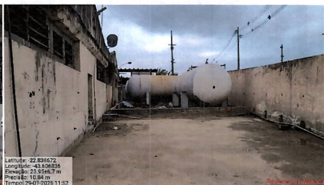
Foto 125: área que passará por reformas para ampliação.
