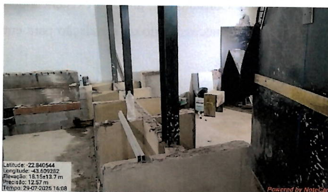
Foto 142: bancadas sendo construídas.
