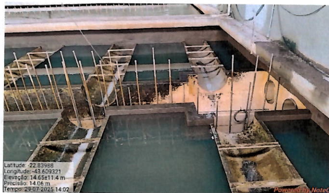
Foto 70: limpeza sendo realizada automaticamente (vergalhões expostos para colocação do sistema de ar).
