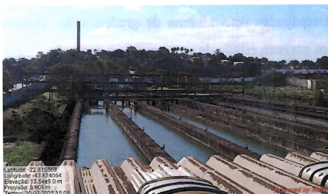
Foto 19: vista dos canais desarenadores.
