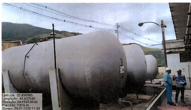
Foto 124: área onde estão armazenados os tanques.
