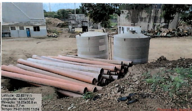
Foto 137: tanques de hidróxido de sódio antigos.
