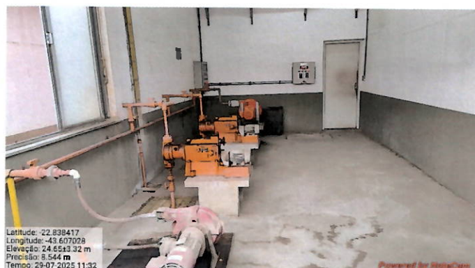
Foto 126: unidade de dosagem de ácido fluossilícico.
