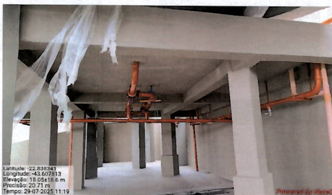
Foto 120: estrutura das vigas reformada.
