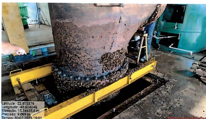
Foto 33: conjunto removido para manutenção.
