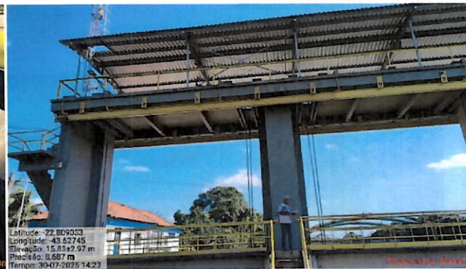
Foto 12: cobertura nova instalada.
