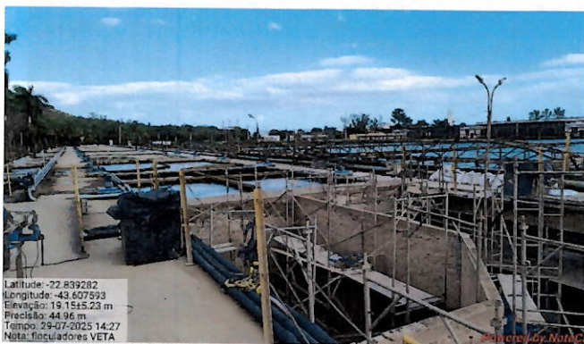
Foto 57: obras civis sendo realizadas no floculador 7.
