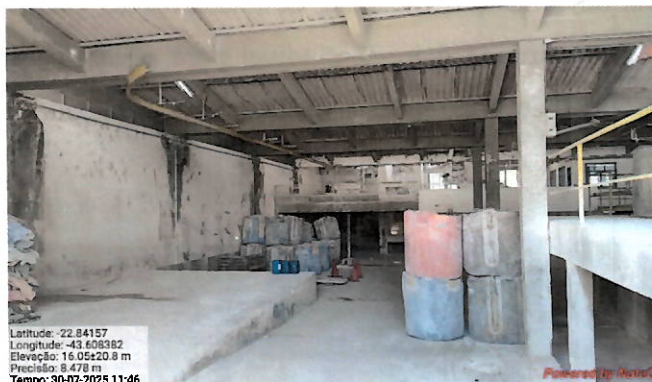
Foto 138: área de diluição de cal sendo desativada.
