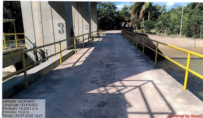
Foto 4: piso em boas condições de uso.
