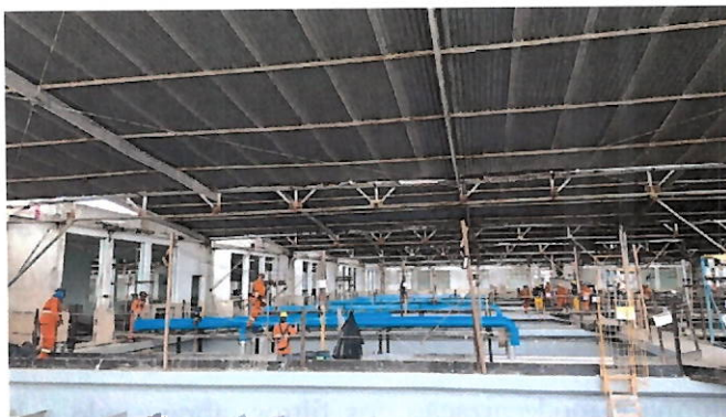
Foto 65: Telhado dos filtros que passará por reformas.
