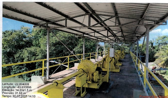
Foto 6: piso superior com cobertura nova.
