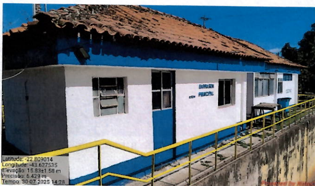
Foto 7: sala de apoio operacional.
