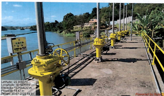
Foto 17: tomada de água velha.
