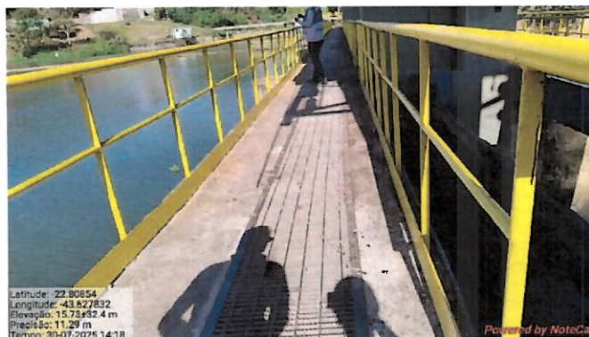
Foto 11: grades do piso substituídas e guarda-corpos restaurados.
