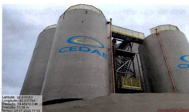
Foto 119: silos de armazenamento de sulfato de alumínio reformados. Nota-se a instalação de guarda-corpos na parte superior.
