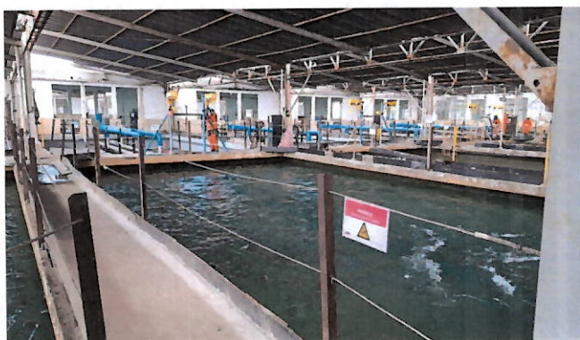
Foto 63: filtros em reforma.
