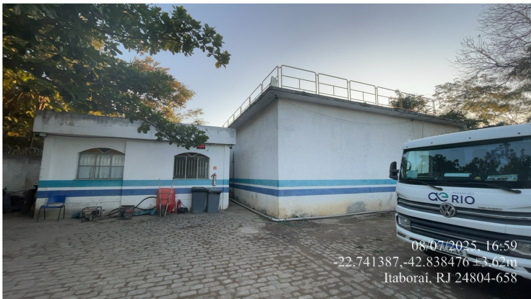
Foto 02 – Pátio de acesso ao reservatório.
