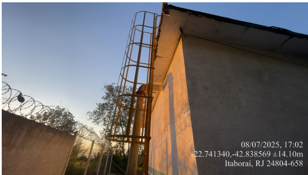
Foto 05: Escada de acesso (tipo marinheiro) ao topo do reservatório.
