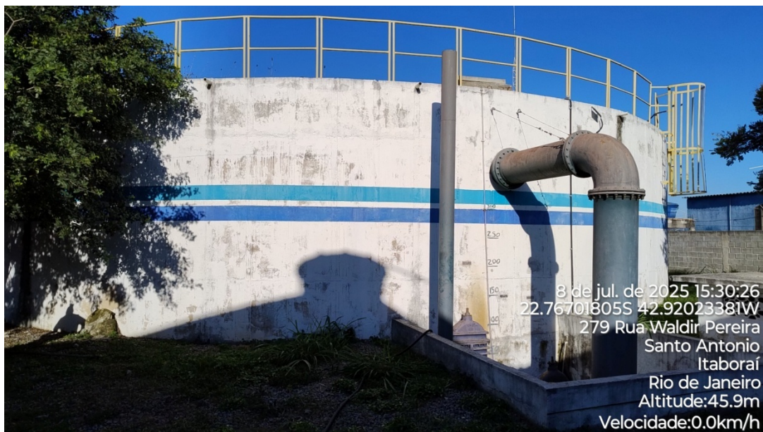
Foto 05: Vista parcial do reservatório.
