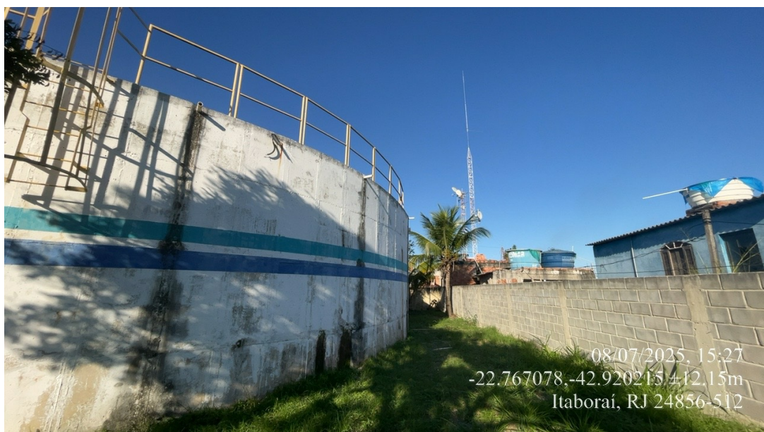
Foto 06: Vista parcial do reservatório.
