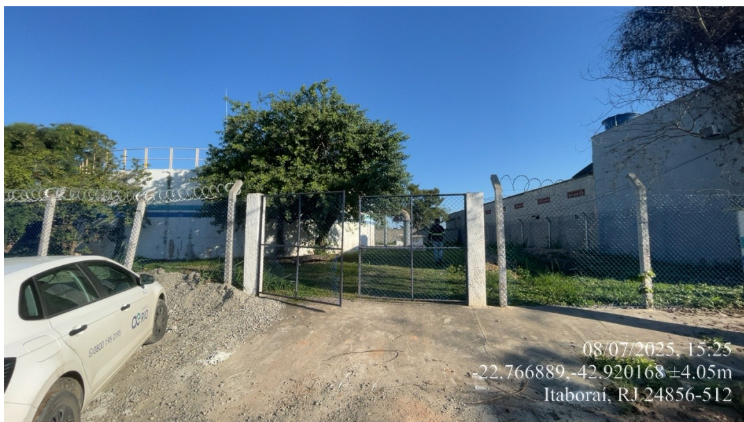
Foto 01 – Entrada do reservatório sem placa de identificação.
