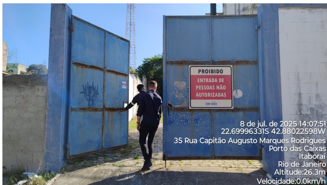
Foto 01 – Entrada do reservatório.
