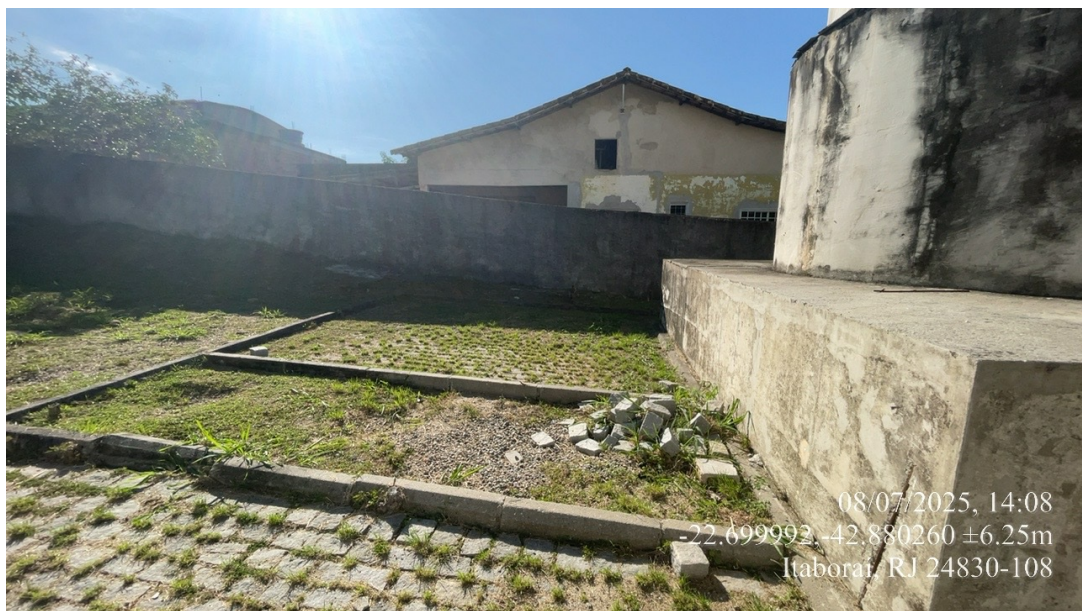
Foto 06: Pátio do reservatório.
