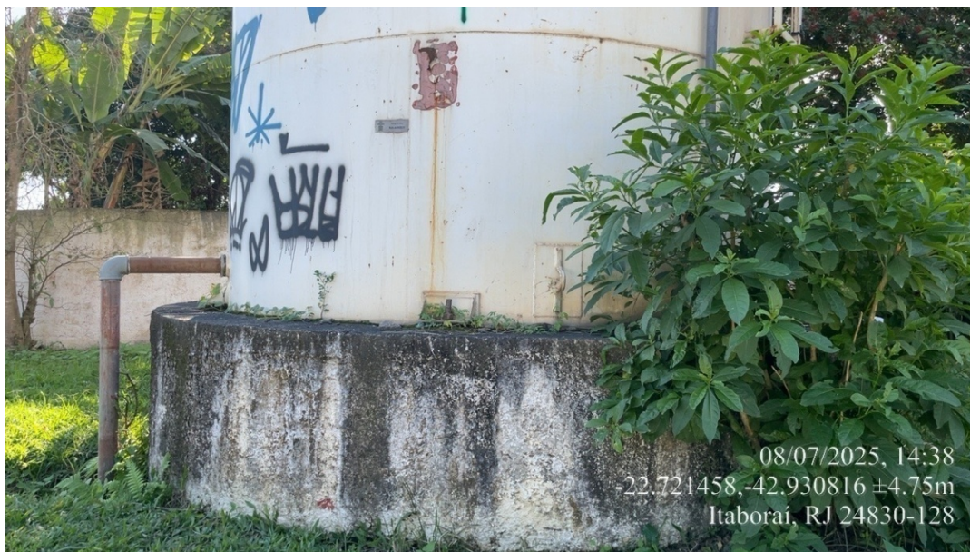
Foto 05: Vista da base do reservatório.
