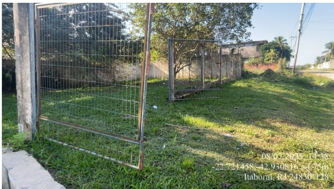
Foto 02 – Acesso ao reservatório sem restrição de acesso.
