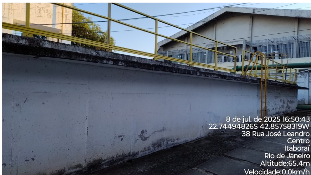
Foto 07 – Vista parcial do reservatório de 1.100 m³.
