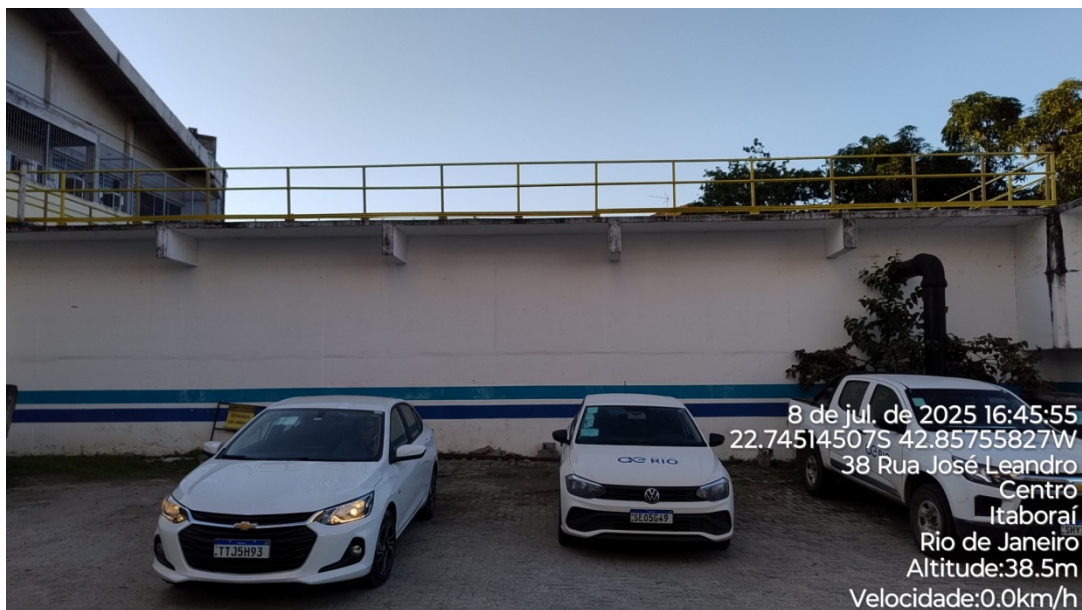
Foto 05: Vista parcial do reservatório de 1.100 m³.
