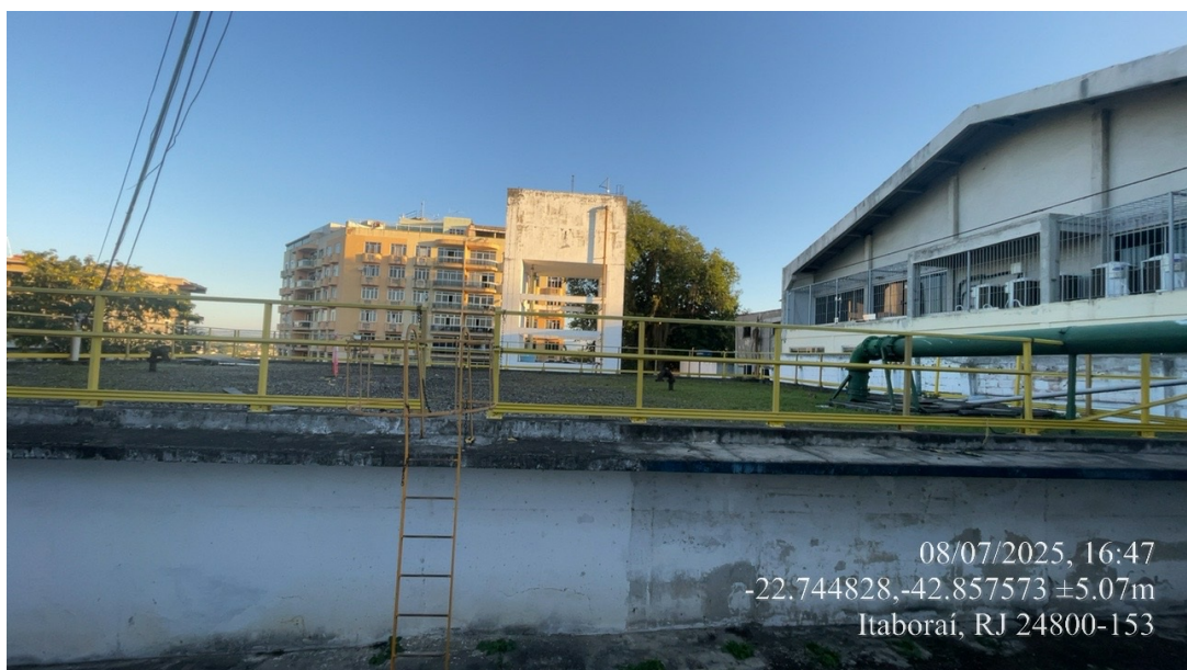
Foto 06: Vista parcial do reservatório de 1.100 m³.
