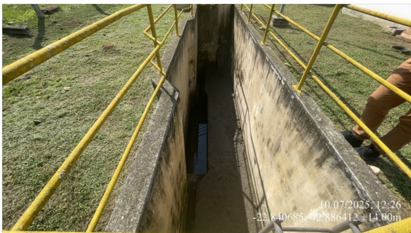
Foto 03 – Caixa de areia e caixa separadora água / óleo.
