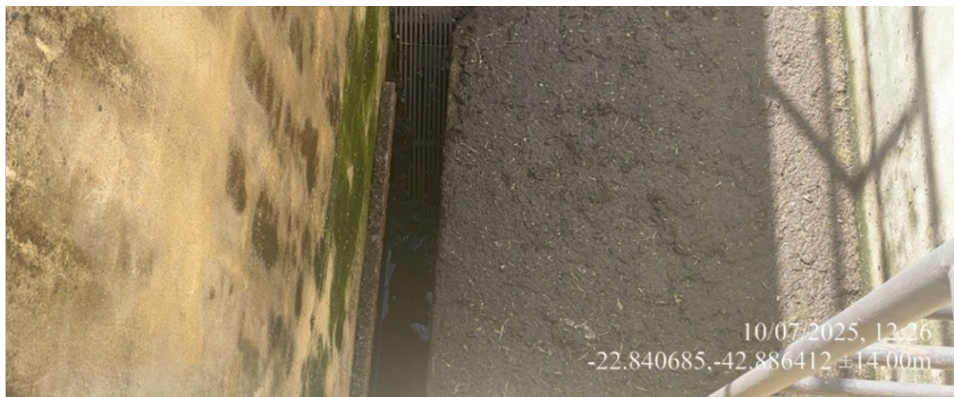
Foto 02 - Gradeamento de sólidos grosseiros na chegada do efluente.
