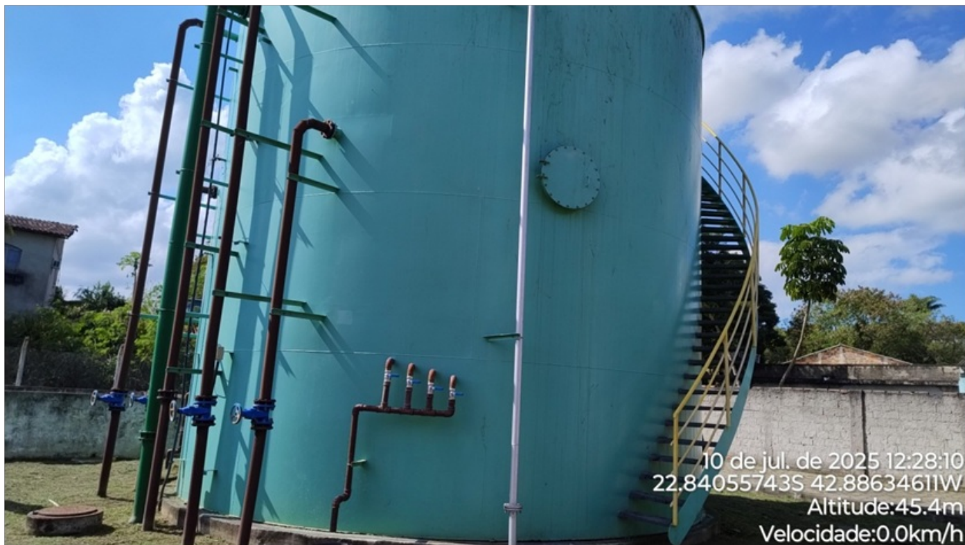
Foto 05 - Vista do tanque do reator UASB.
