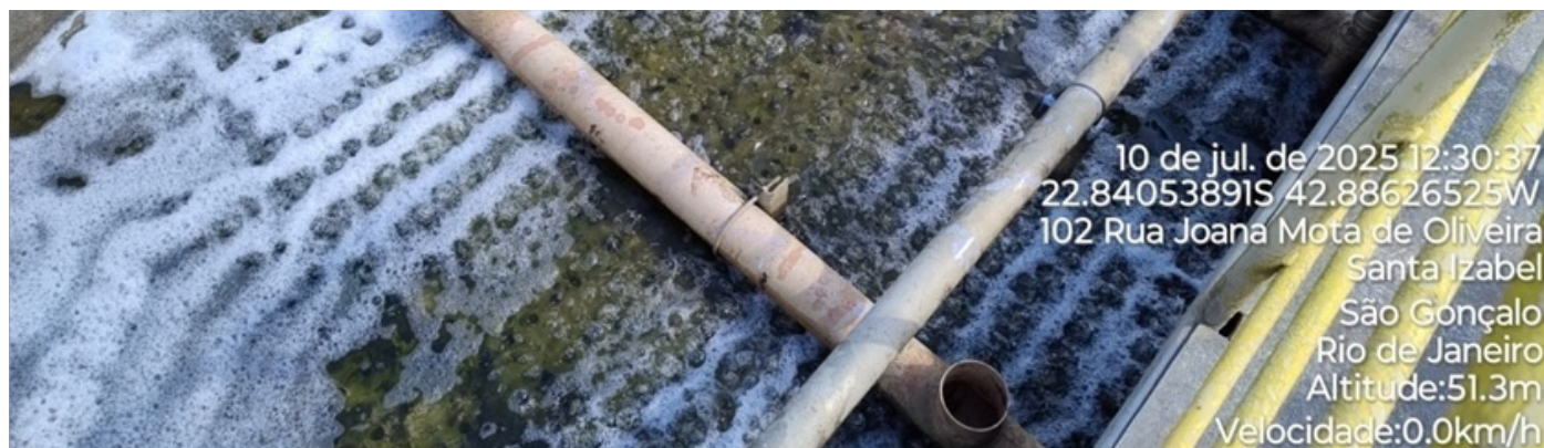
Foto 08 - Filtro biológico anaeróbio.
