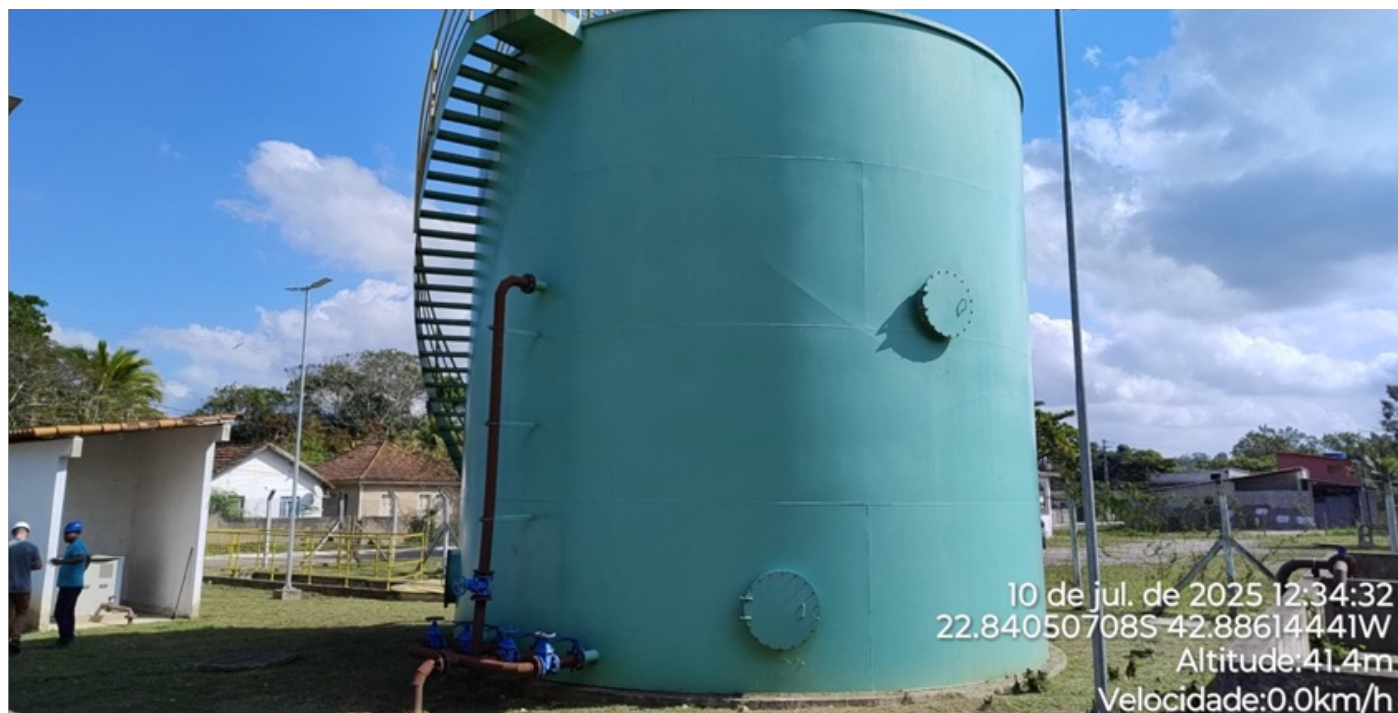
Foto 06 - Vista do tanque do reator UASB.
