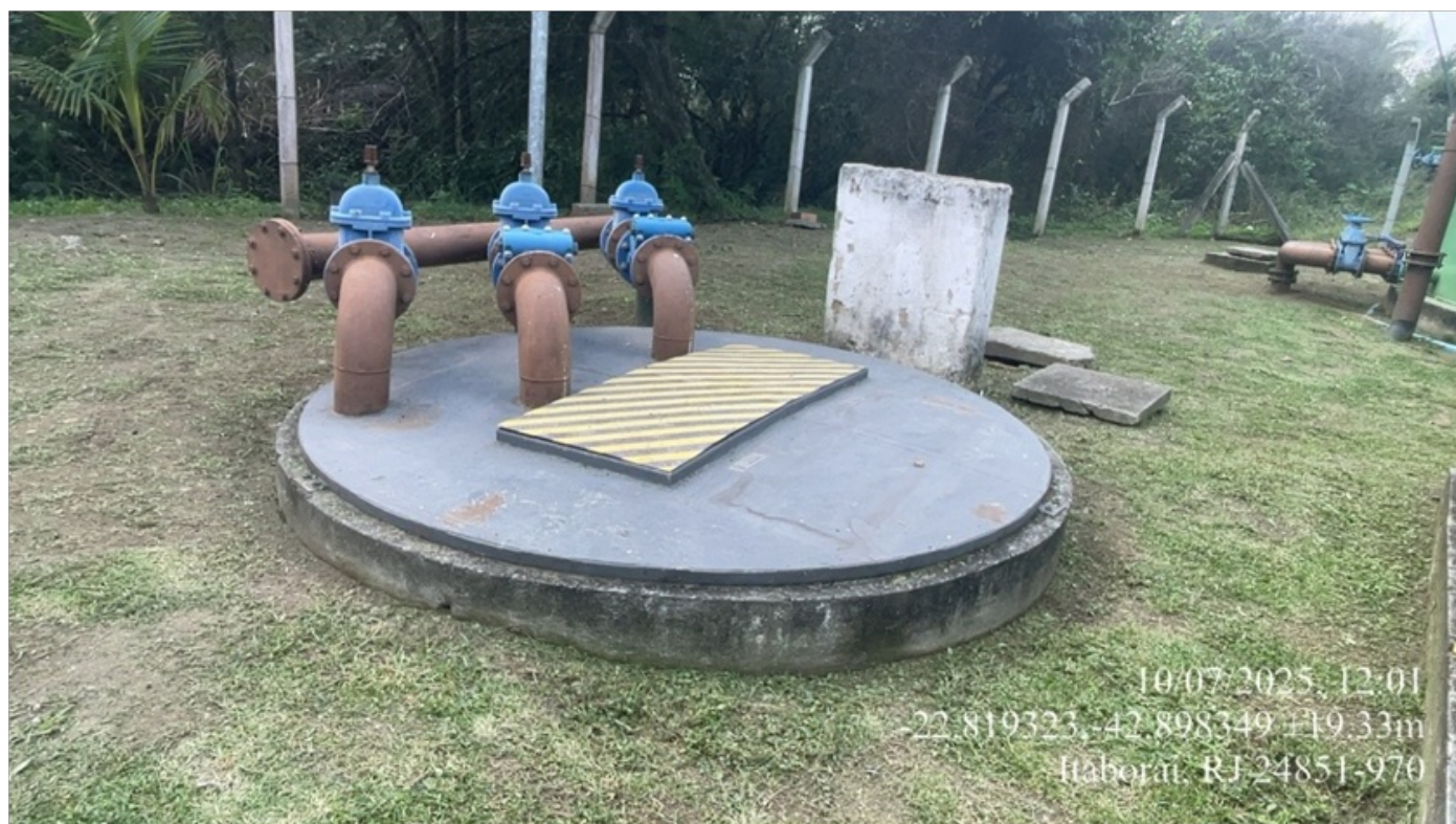
Foto 06 – Poço e elevatória da ETE.
