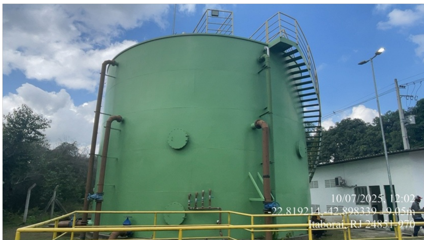
Foto 07 – Vista do tanque do reator UASB.
