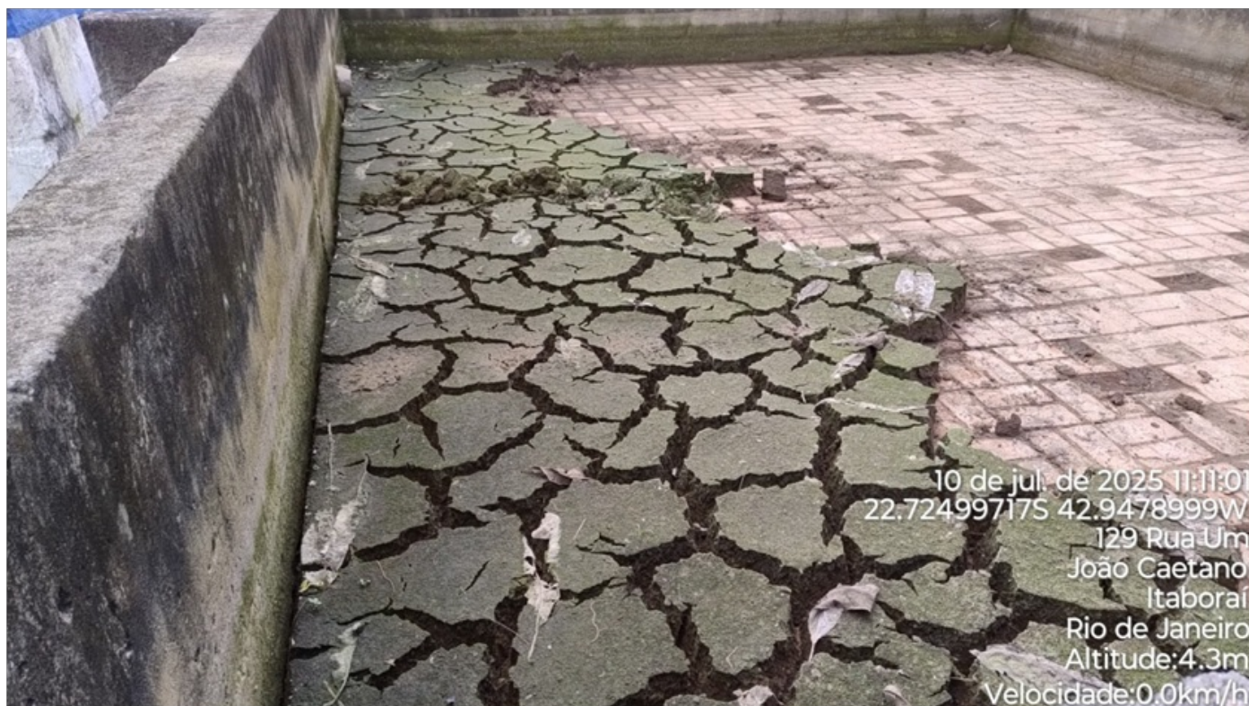
Foto 19 - Leito de sacagem do lodo gerado.
