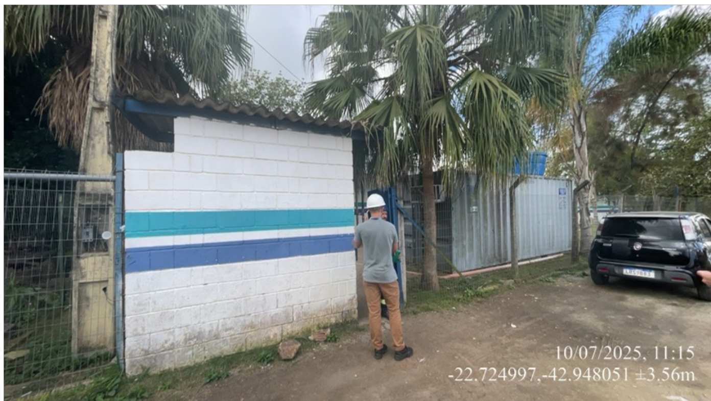
Foto 01- Entrada da ETE.
