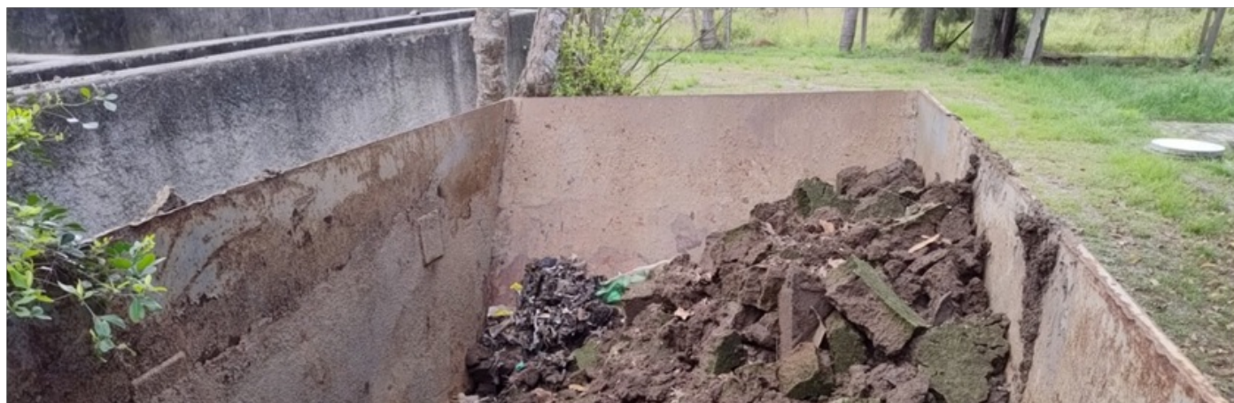
Foto 19 - Leito de sacagem do lodo gerado.
