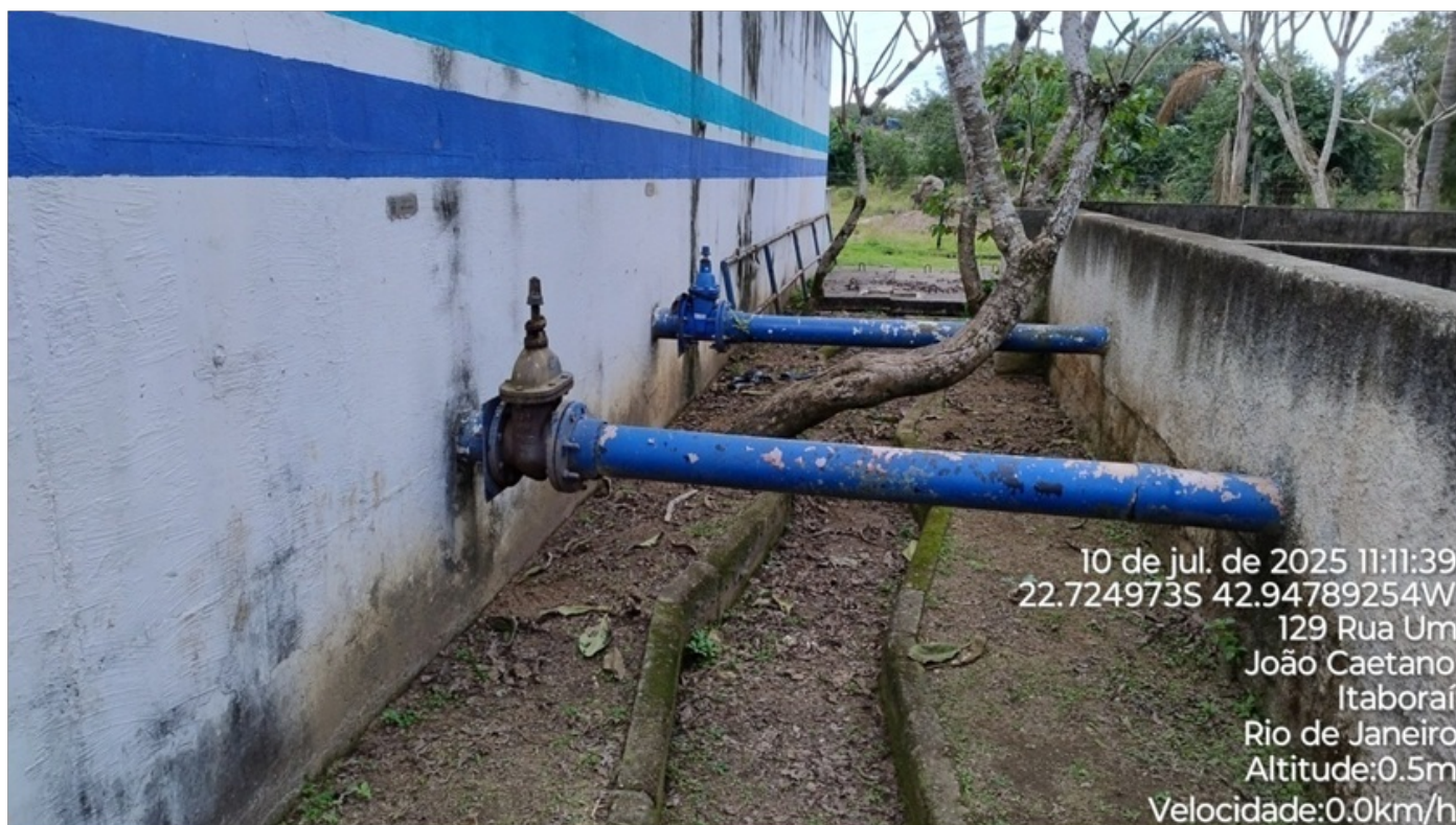
Foto 17 – Sistema de descarga do lodo para o leito de secagem.
