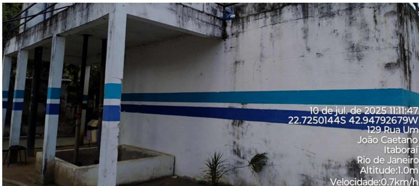
Foto 03 – Vista parcial da ETE.
