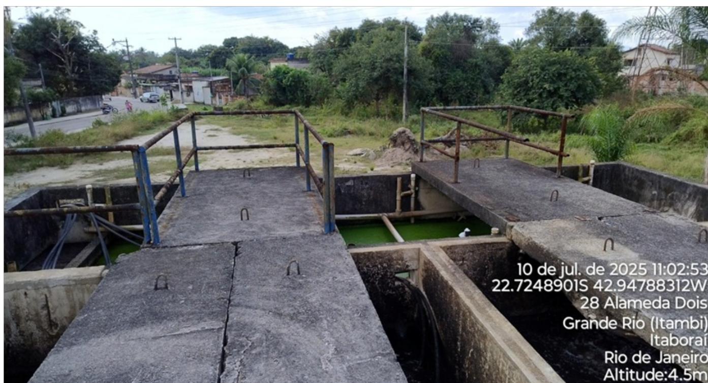
Foto 10 - Tanque de aeração.
