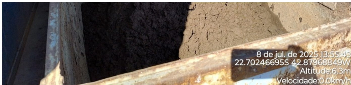
Foto 18 - Acondicionamento do lodo desidratado.
