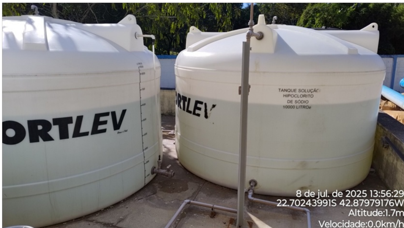
Foto 15 - Armazenamento do hipoclorito de sódio.
