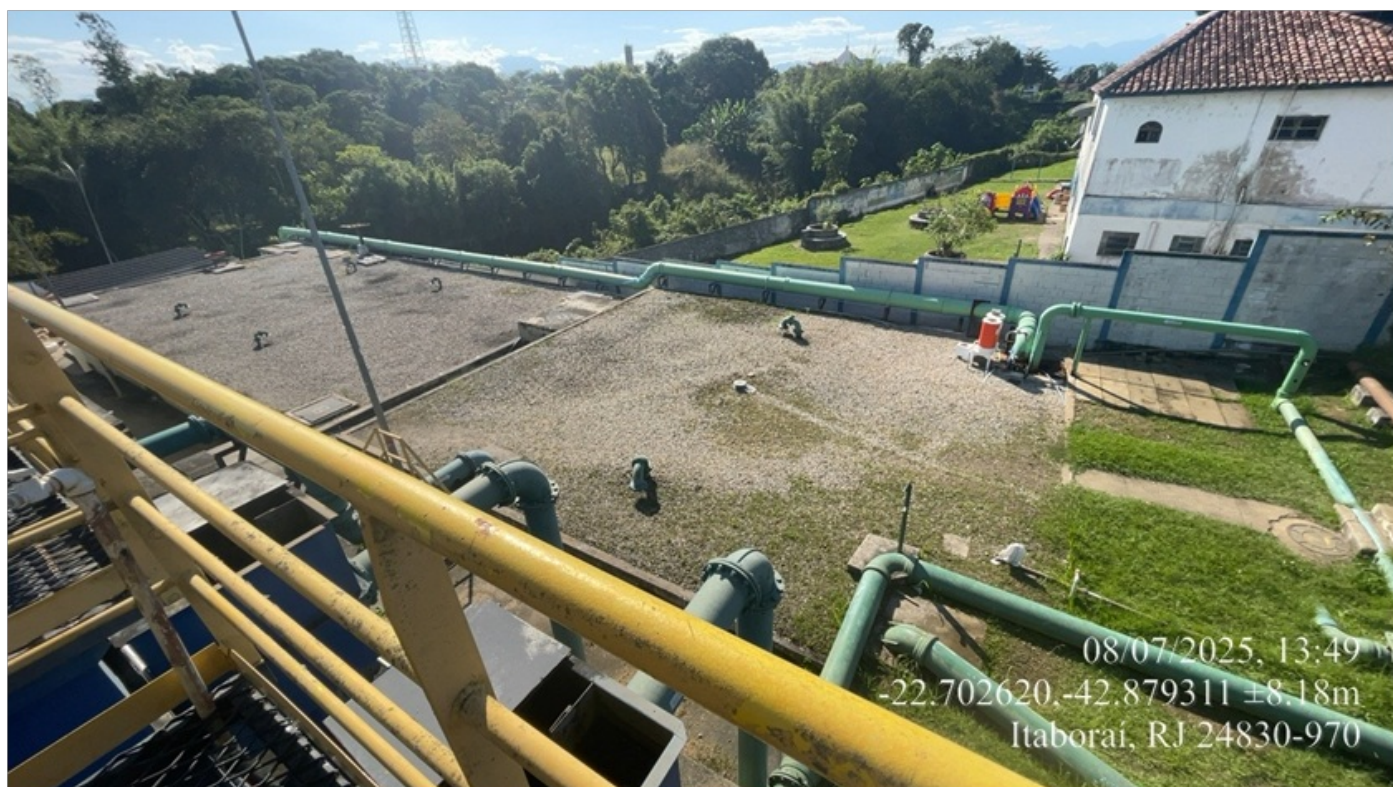
Foto 19 – Reservatórios com capacidade de 2.000 m³ e 800 m³.
