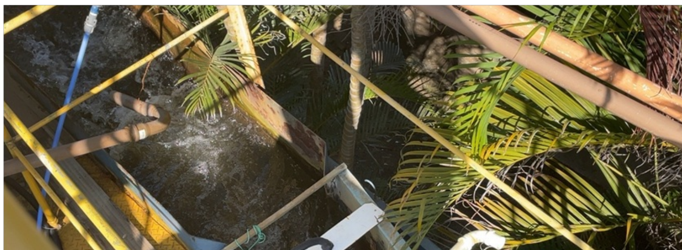
Foto 03 – Dosador do Sulfato de alumínio.
