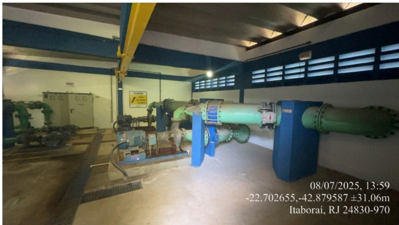
Foto 17 - Bombas de retrolavagem dos filtros.
