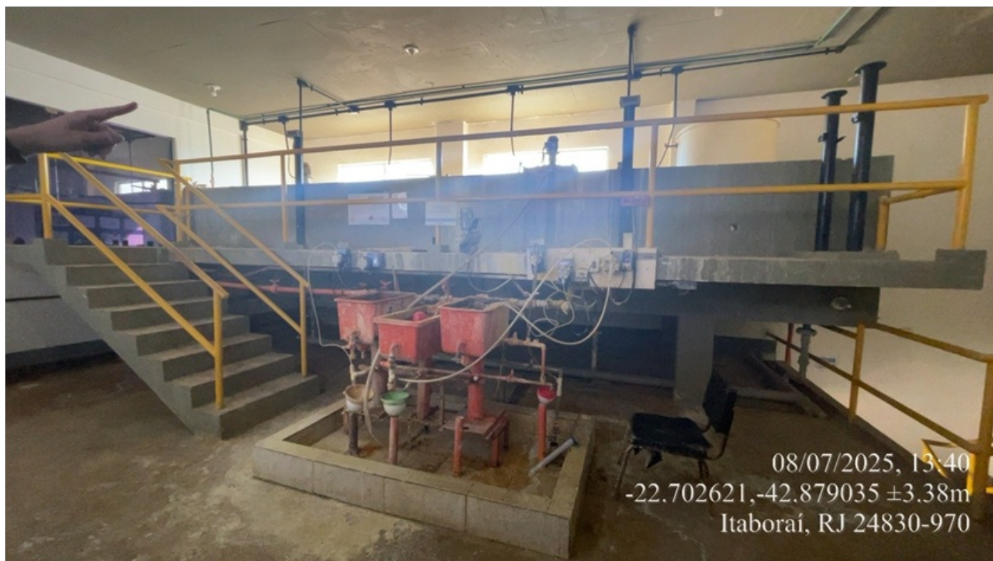
Foto 03 – Dosador do Sulfato de alumínio.
