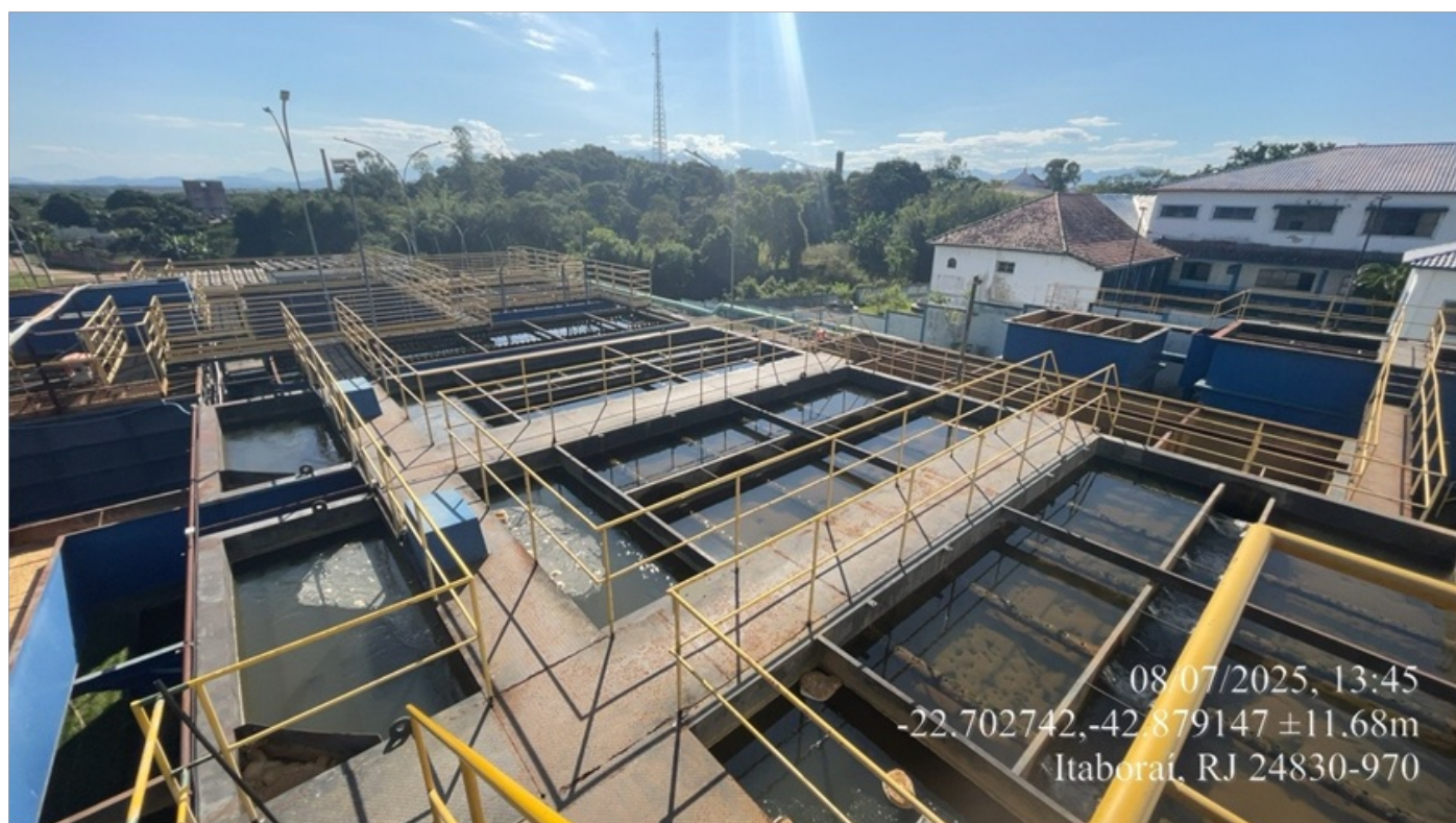
Foto 07 - Vista geral dos módulos de tratamento (floculador, decantador e filtros).
