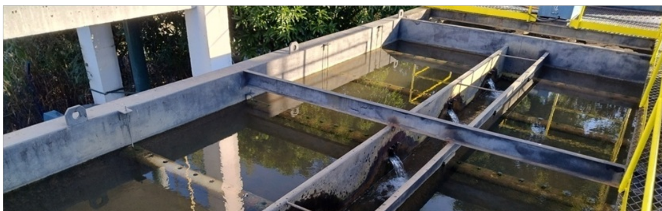
Foto 03 – Chegada da água bruta na Calha Parshall e do agente aglutinante.
