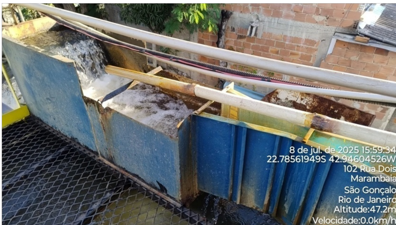
Foto 03 – Chegada da água bruta na Calha Parshall e do agente aglutinante.
