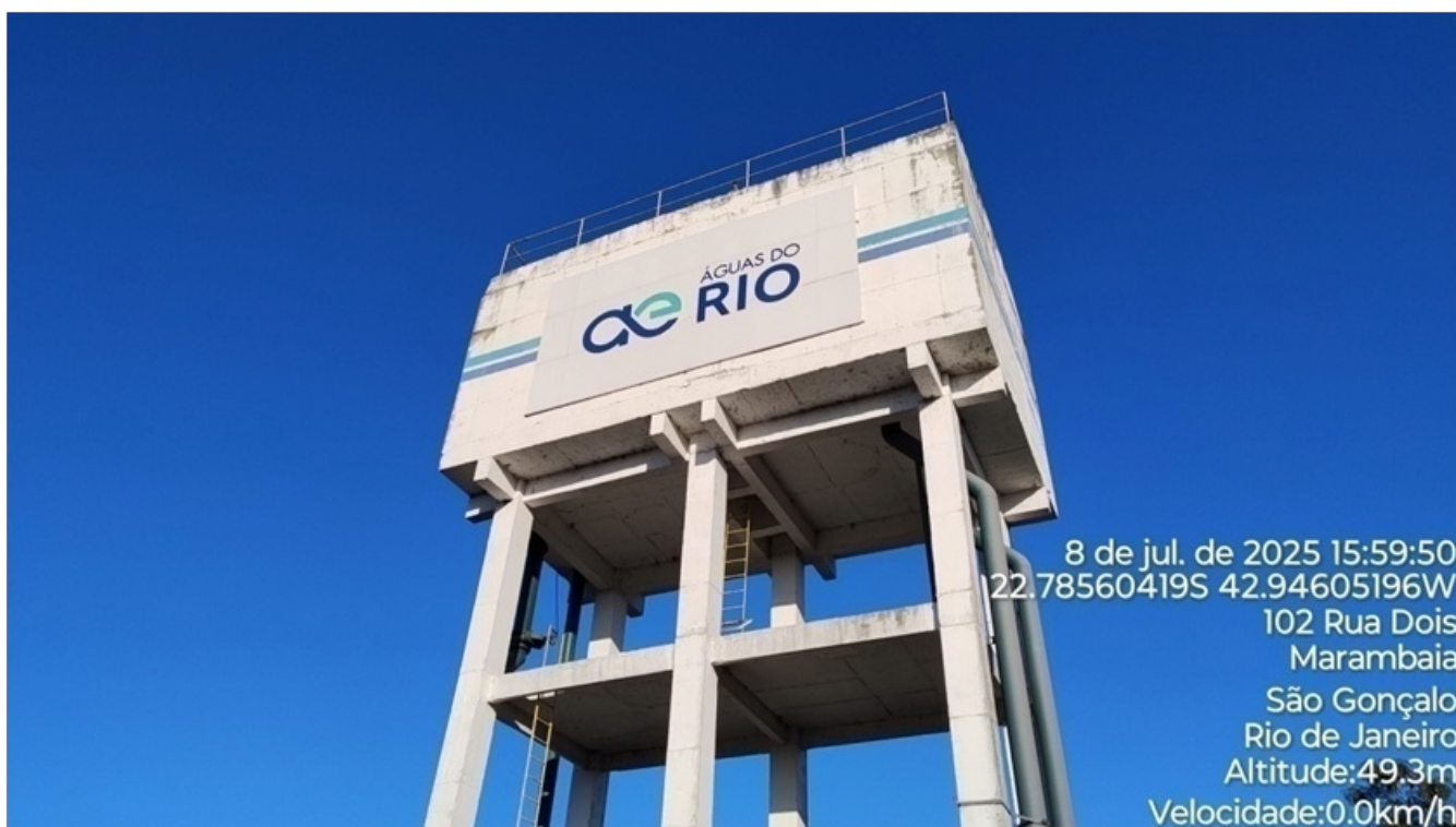
Foto 13 – Reservatório (tipo elevado) com capacidade de 400 m³.
