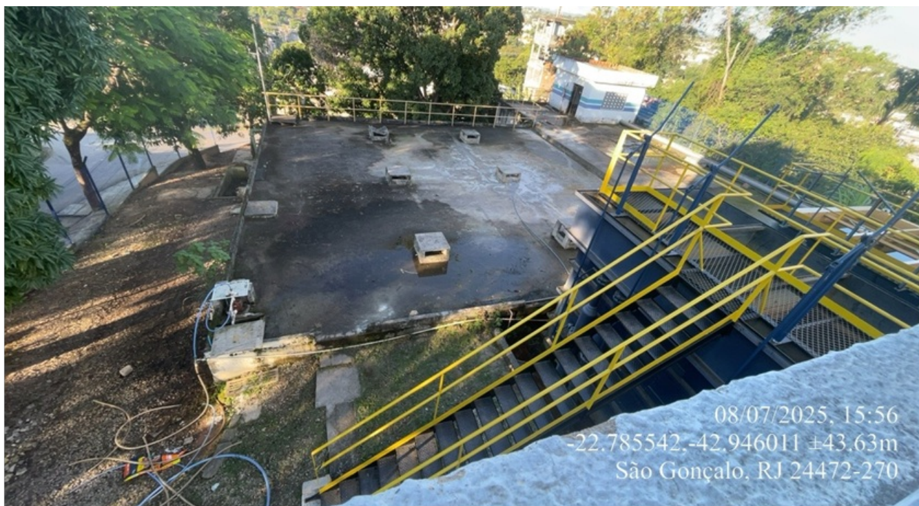
Foto 12 – Reservatórios (tipo apoiado) com capacidade de 800 m³ e 400 m³.
