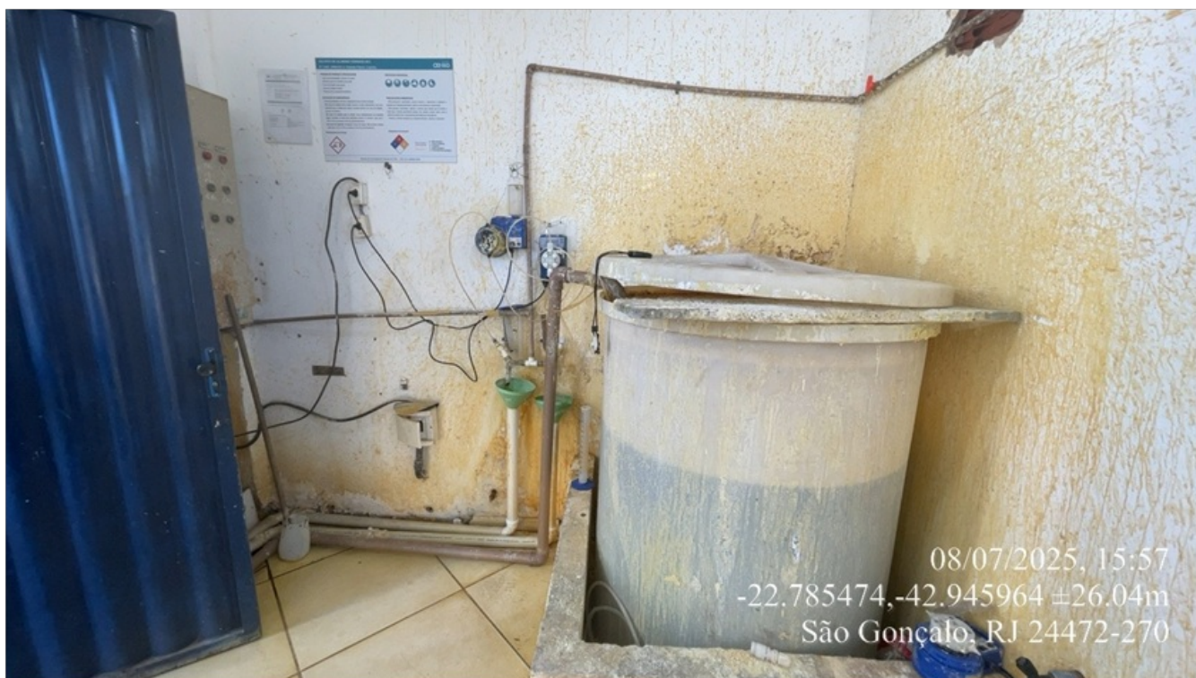
Foto 02 – Dosador do agente aglutinante (Sulfato de alumínio).
